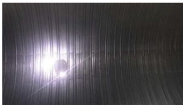
据付勾配 0.1% 第 1 孔開栓 滞水状況（中央透明枠）
