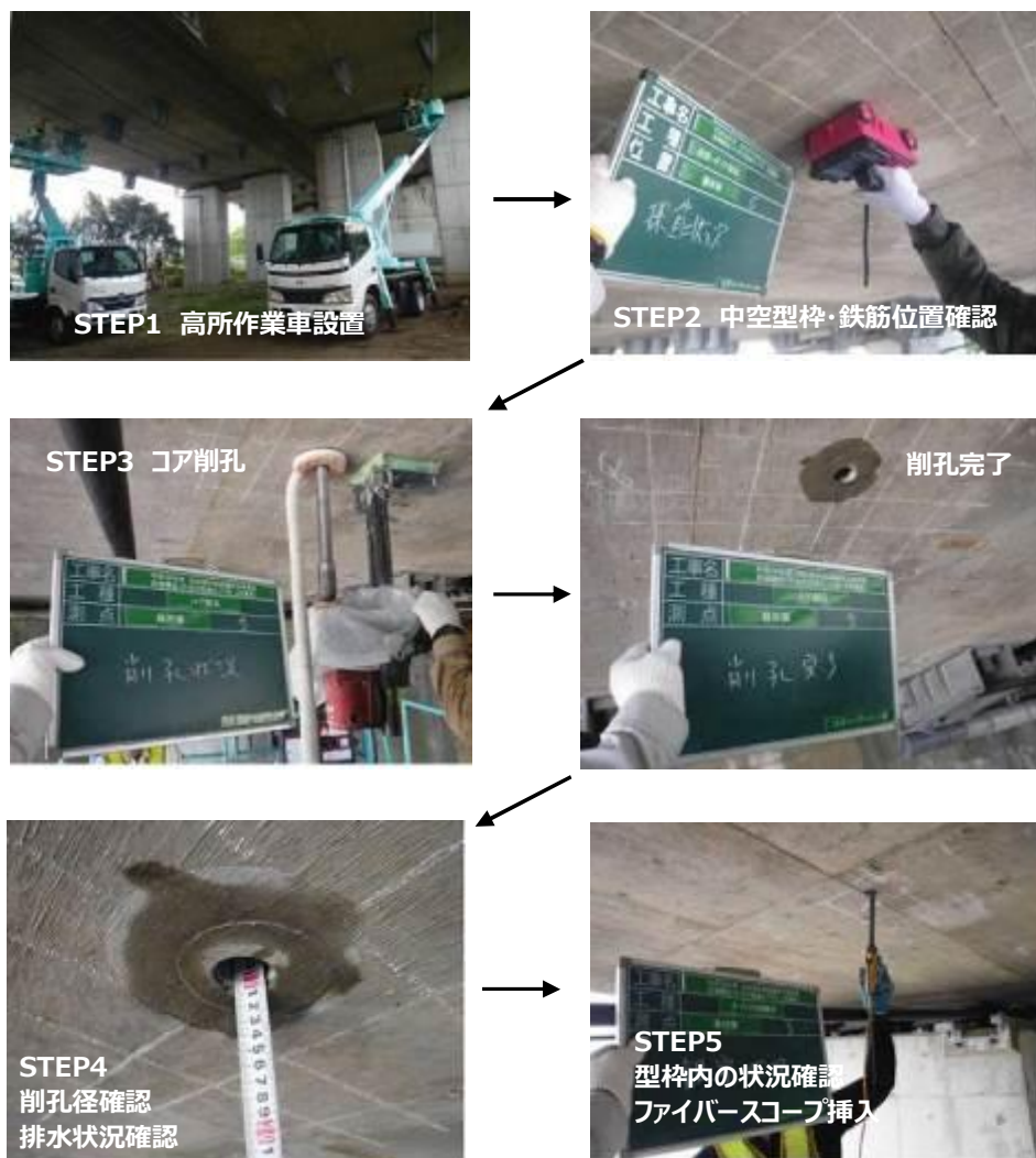
写真- 3.2.2 コア削孔（φ40）対策
