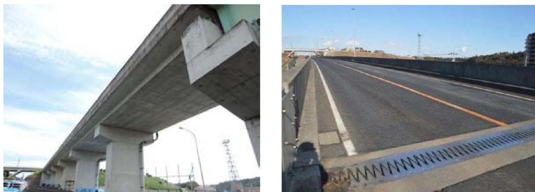
写真- 4.3.9 橋梁外観
