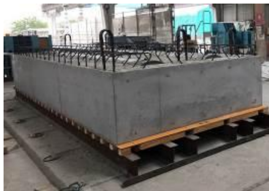
写真- 4.2.2 1次コン打設完了状況
