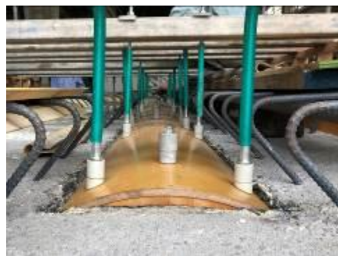
写真- 4.2.7 吊り型枠設置完了状況
