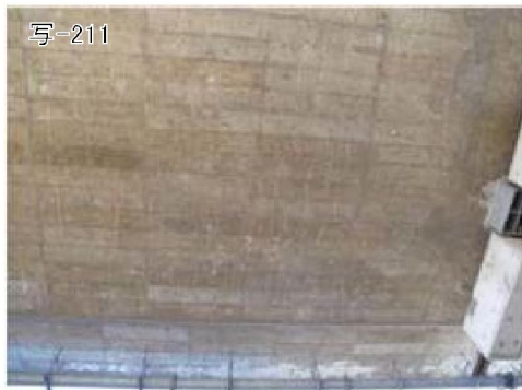
写真-4.1.2 P12-P13 径間 床版下面変状状況（漏水・遊離石灰、ひび割れ）
