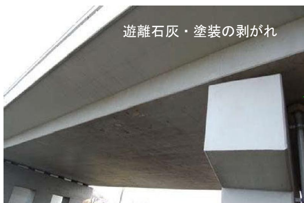
(a)全景（張出床版～床版下面）
