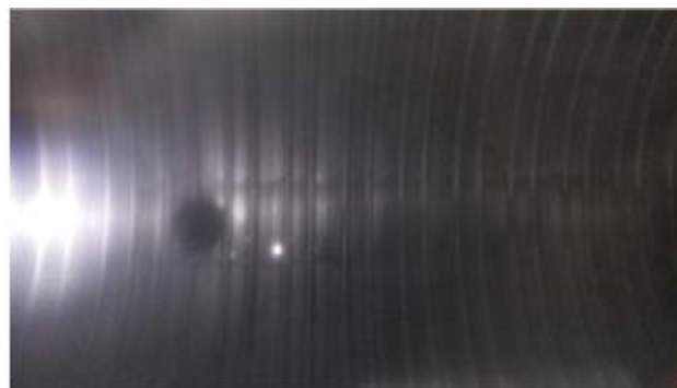
据付勾配 4.0% 第 1 孔開栓 滞水状況（中央透明枠）
