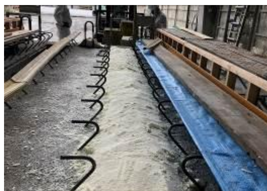
写真- 4.2.4 ウレタン成型完了状況
