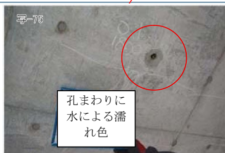
写真- 4.3.10 床版下面変状状況(漏水・遊離石灰、ひび割れ)
