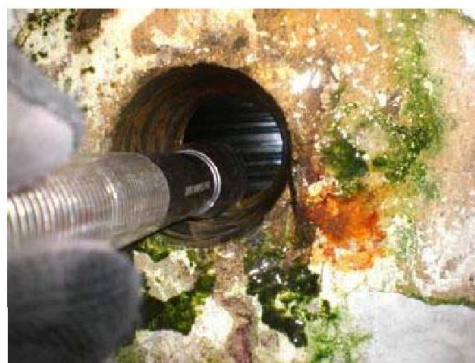
写真- 3.1.1 中空床版橋の下面の変状例
