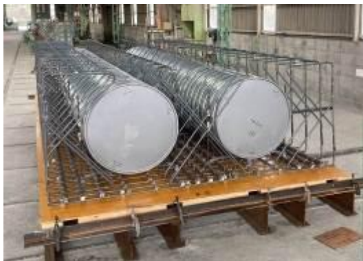
写真- 4.2.1 中空型枠及び鉄筋配置状況
