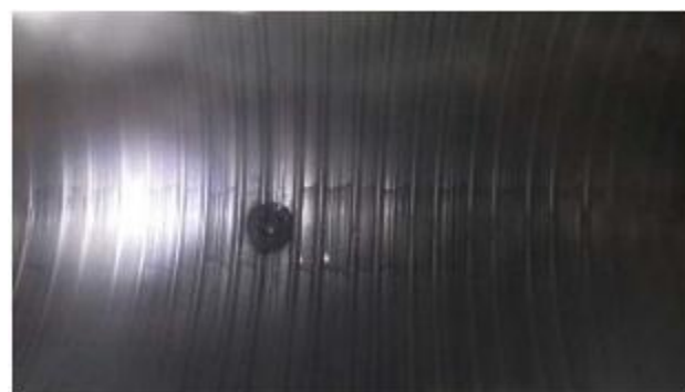
据付勾配 4.0% 第 1, 2 孔開栓 滞水状況（中央透明枠）
