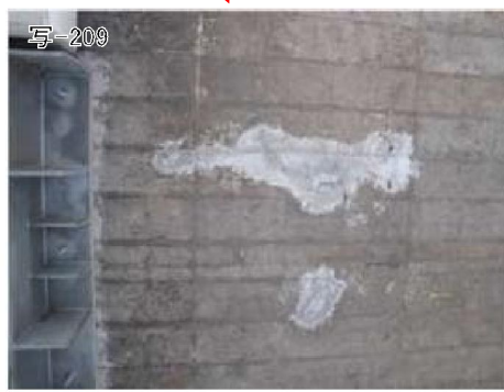
写真-4.1.2 P12-P13 径間 床版下面変状状況（漏水・遊離石灰、ひび割れ）
