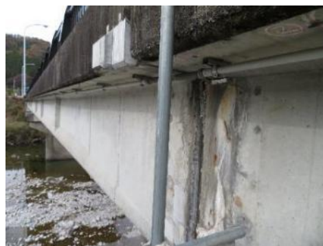
P2 橋脚（上流側）
