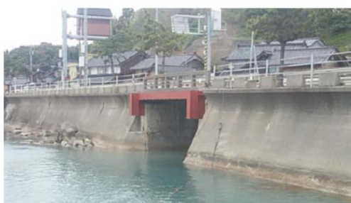
写真- 4.1.8 対策完了 (L 側)
