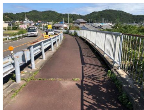
写真 7. 橋面舗装状況（歩道部）
