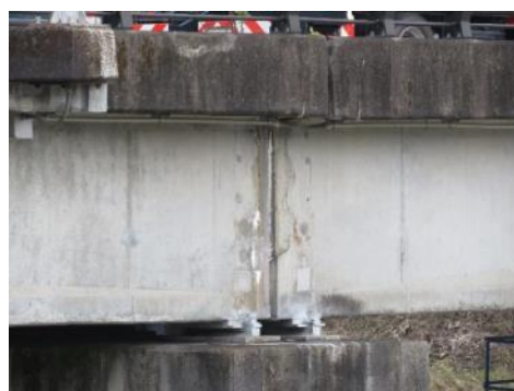
P1 橋脚（下流側）
