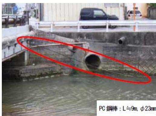
(b) 鋼材突出部（側面）
