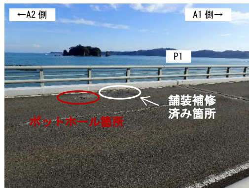
P1-A2 径間 橋面 (P1 付近)
