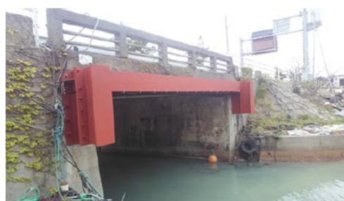
写真- 4.1.9 対策完了 (R 側)
