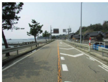
写真-4.1.2 橋梁全景 (手前が A1 側)
