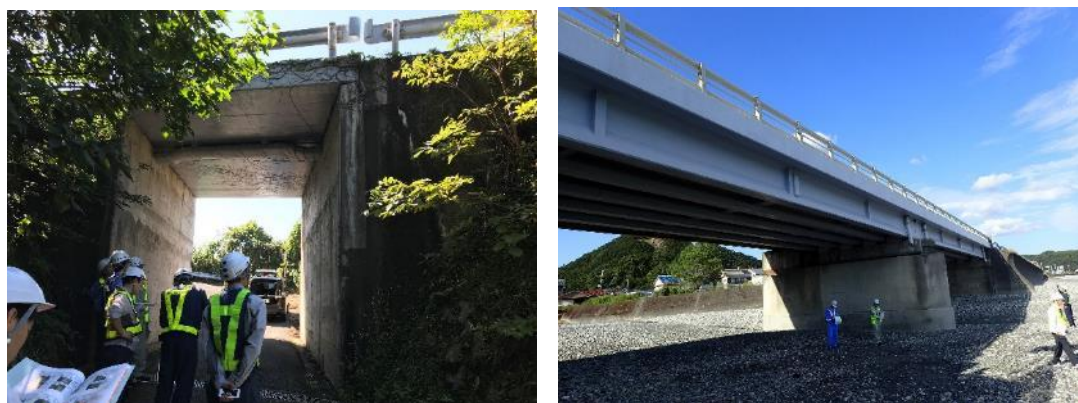
写真- 4.2.1 現地調査実施状況
