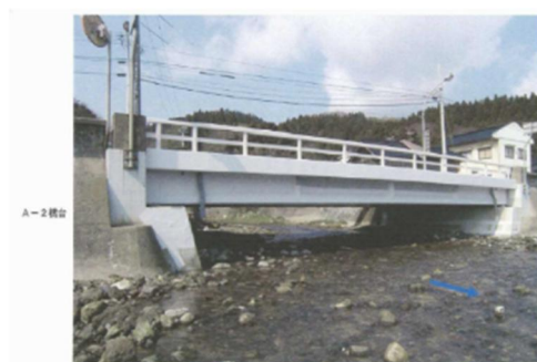
写真-3 補修完了全景
