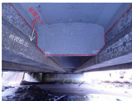
写真-5 調査時点の被覆状況
