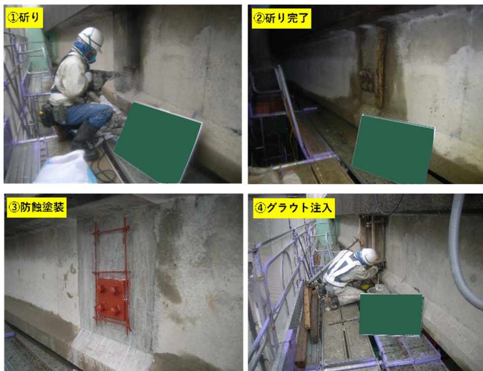
写真-3 中間横桁端部の補修 (P7-P8 径間)
