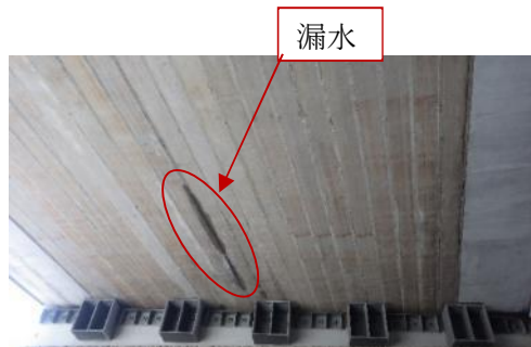
P2-A2 間写真 (A2 側)
