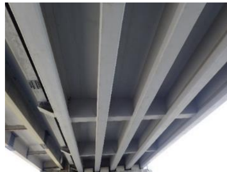
A1-P1 径間 桁下 (P1 側)
