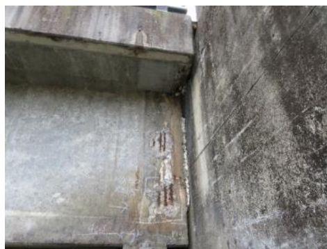
A1 橋台（下流側）
