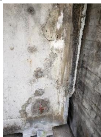
A2 橋台（上流側）
