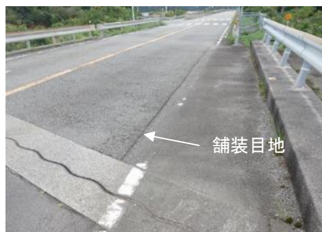
舗装目地（手前が A1 側）
