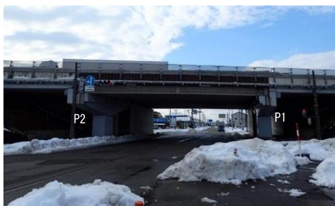
全景写真（左：南側、右：北側）
