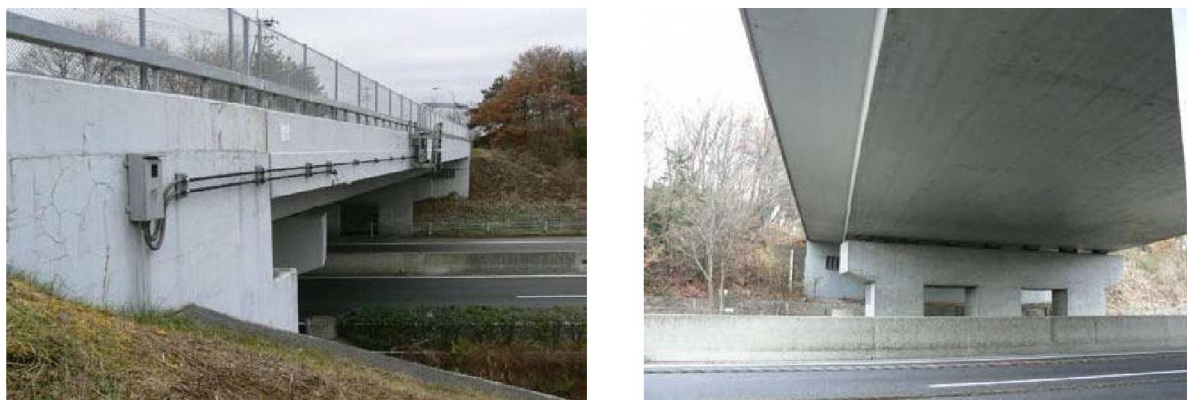
写真-4.3.5 橋梁外観
