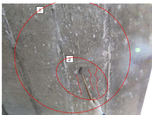
写真- 4.1.6 主桁下面
