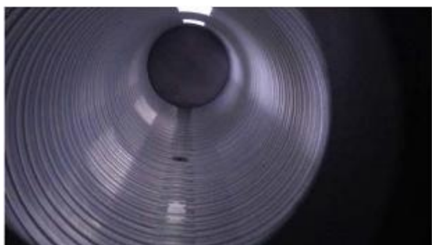
据付勾配 0.1% 第 1, 2 孔開栓 滞水状況（妻枠）
