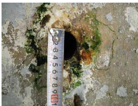
写真- 3.1.2 既設水抜き孔の変状例
