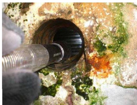
写真- 3.1.1 中空床版橋の下面の変状例
