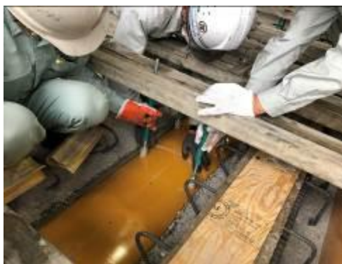
写真- 4.2.6 吊り型枠取付け状況
