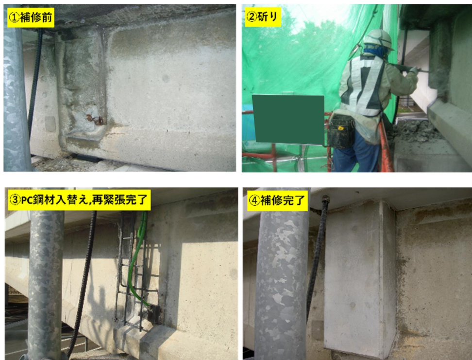
写真-2 横締め PC 鋼材の取替え (P7-P8 径間、P8 橋脚上)
