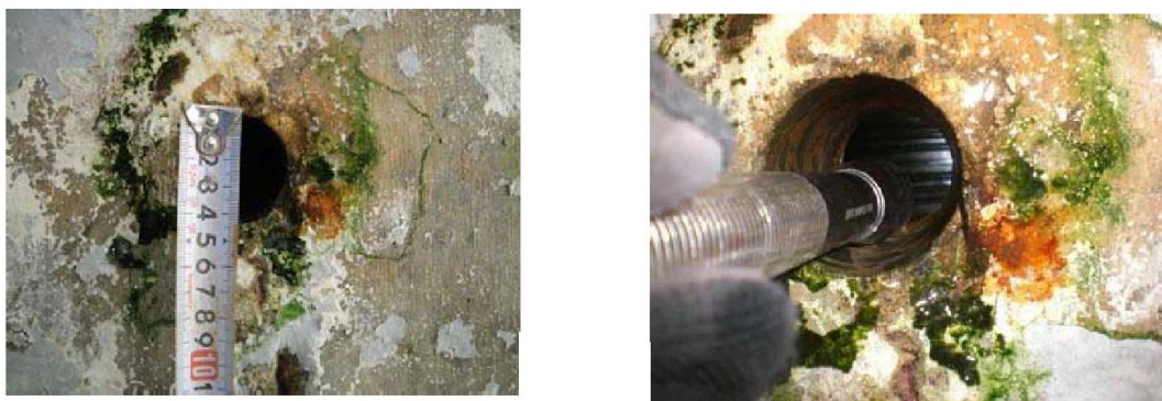
写真- 4.3.8 既設水抜き孔の状況
