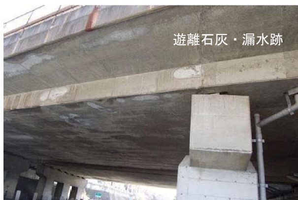
(a)全景 (張出床版～床版下面)
