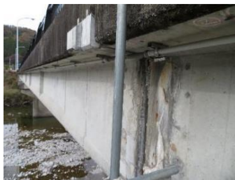
P2 橋脚（上流側）
