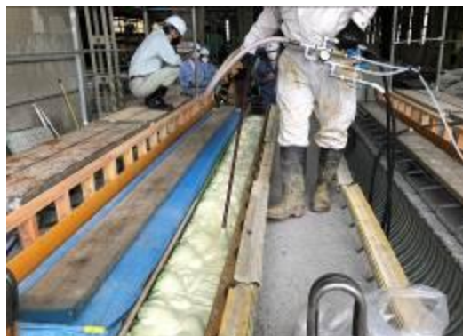
写真- 4.2.3 ウレタン充填状況
