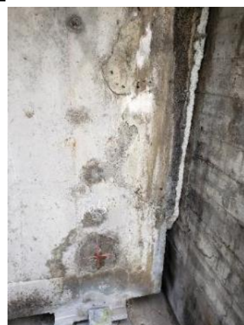
A2 橋台（上流側）
