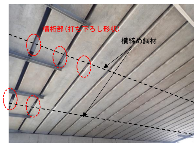
写真-1.1.3 横桁部の打ち下ろし
