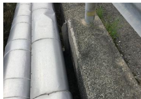
橋面から橋の側面を望む
