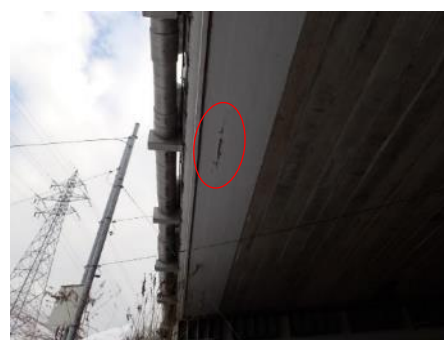
P2-A2 間（下り線、床版橋部）
