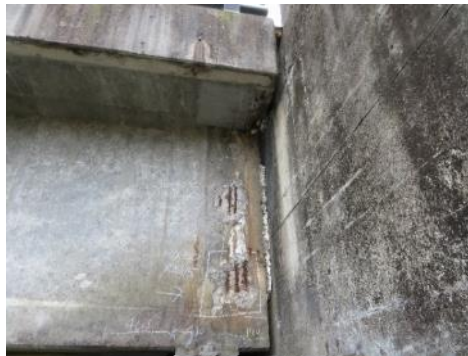
A1 橋台（下流側）
