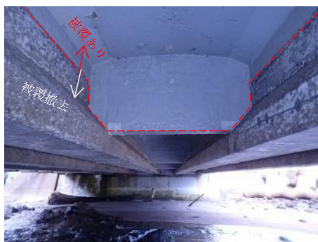
写真-5 調査時点の被覆状況
