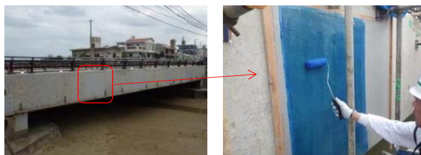
写真- 5.3.2 繊維シートによる突出防止対策
