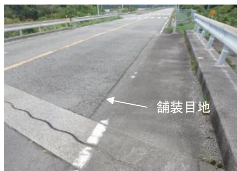
舗装目地（手前が A1 側）
