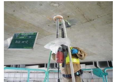
参写真-2.2.1 削孔状況
