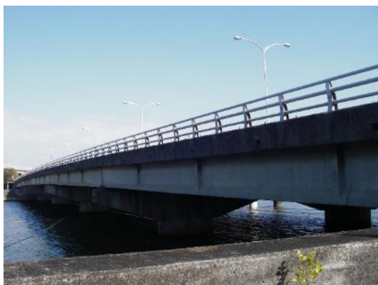
写真- 4.1.15 橋梁全景（側方）
