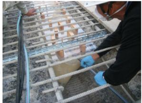
図-4.2.7 発泡ウレタン充填におけるポリエチレン円筒袋の併用事例
