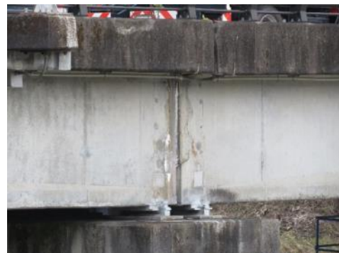
P1 橋脚（下流側）
