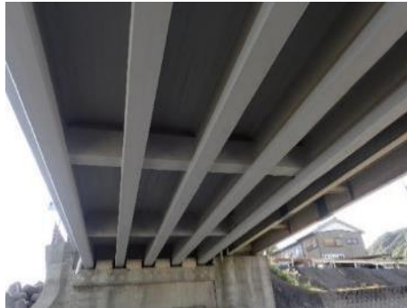
A1-P1 径間 桁下 (A1 側)
