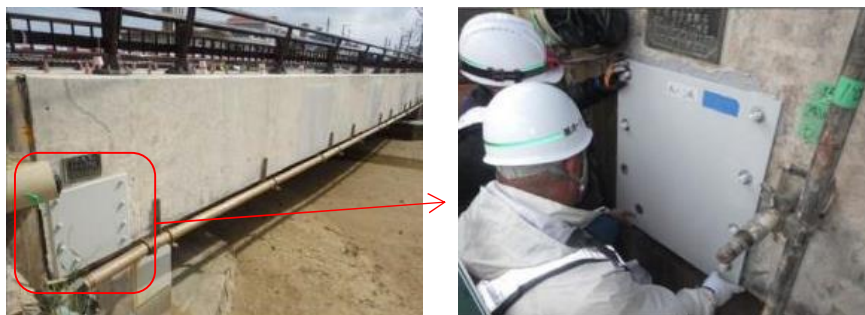
写真- 5.3.1 鋼板による突出防止対策
