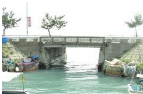
写真-4.1.1 橋梁全景 (左が A1 側)
