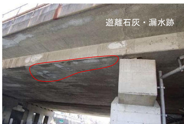
写真- 3.1.1 中空床版橋の下面の変状例
