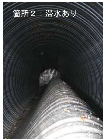
写真- 3.1.3 中空型枠内の滞水状況例
