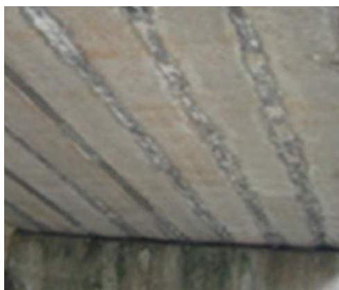
写真-1.1.4 間詰め部の幅一定
