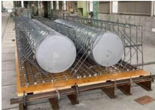
写真- 4.2.1 中空型枠及び鉄筋配置状況
