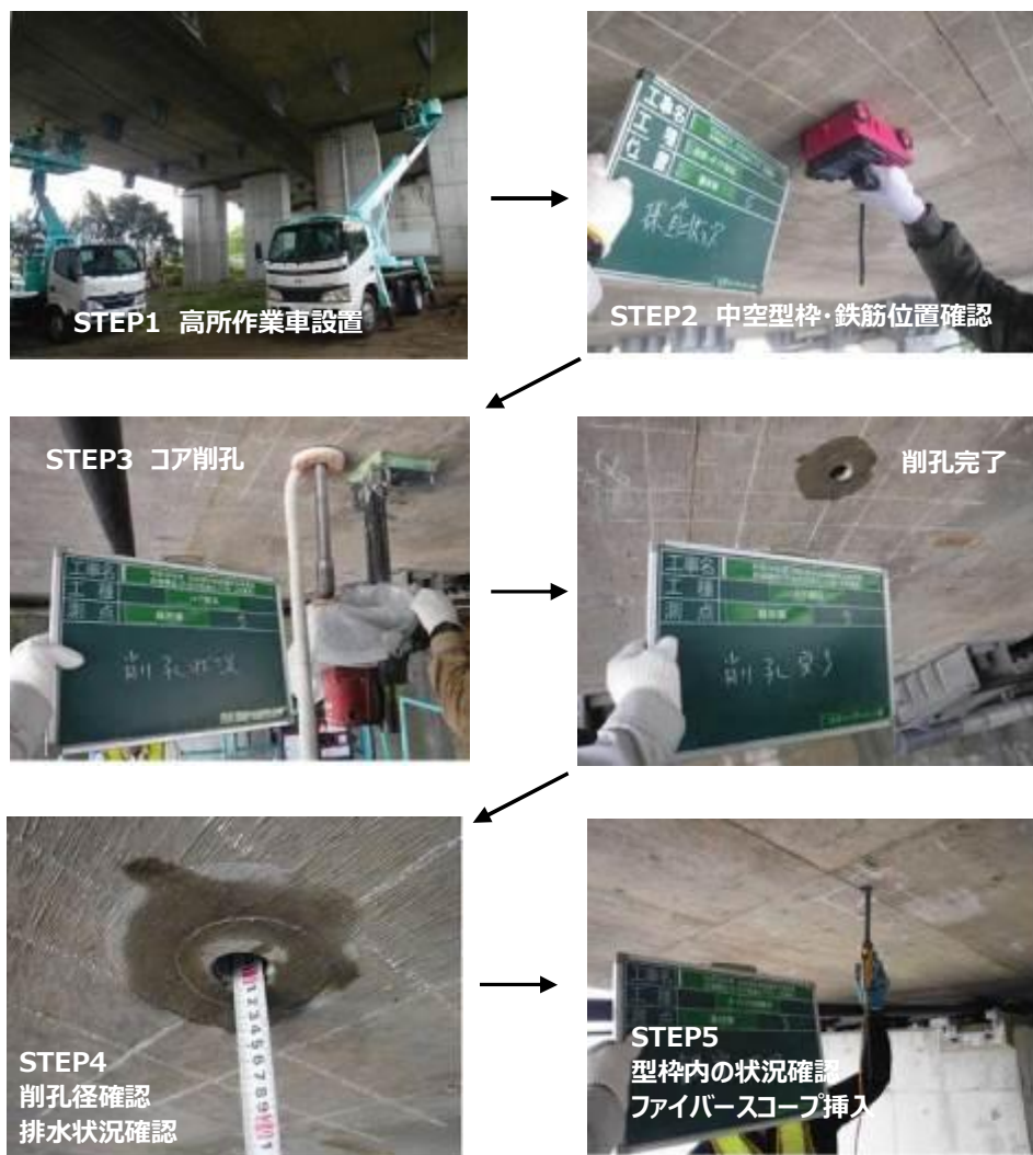
写真- 3.2.2 コア削孔（φ40）対策
