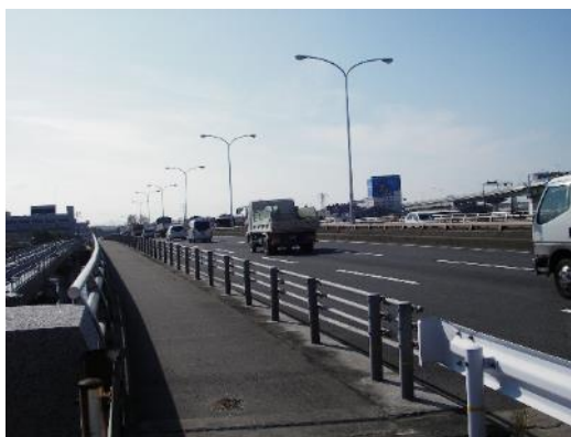
写真- 4.1.14 橋梁全景（橋面）
