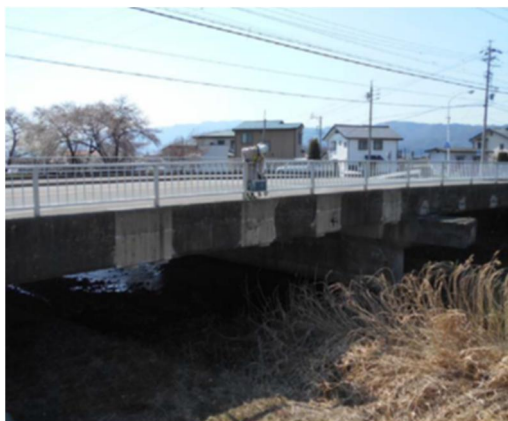
(a) 横締め PC 鋼材突出状況
