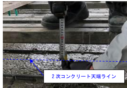
写真- 4.2.9 沈下量測定方法
