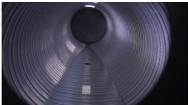
据付勾配 4.0% 注水完了（妻枠）
