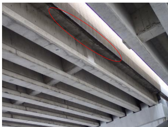
P1-P2 間（下り線、T 桁部）
