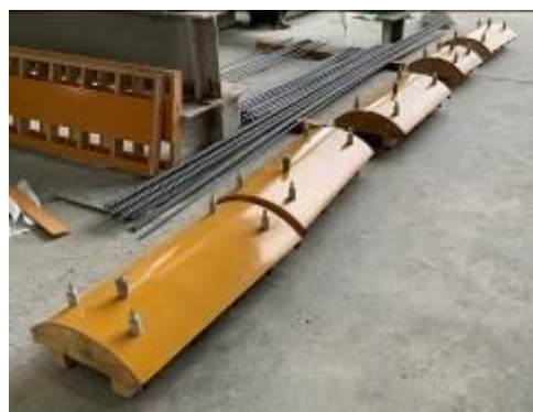
写真- 4.2.5 吊り型枠製作状況
