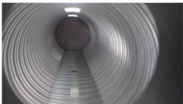
据付勾配 0.1% 注水完了（妻枠）
