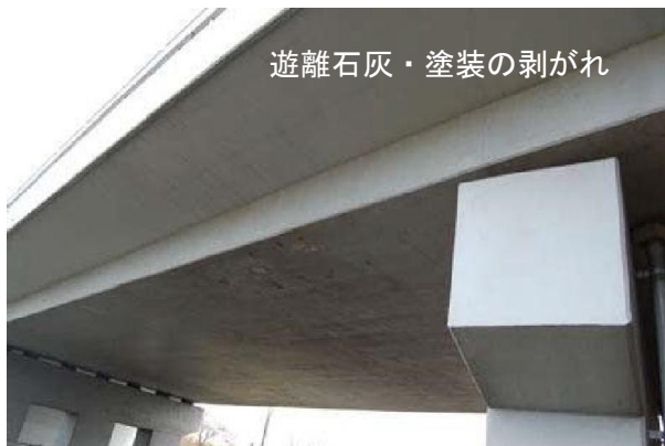
(a)全景 (張出床版～床版下面)
