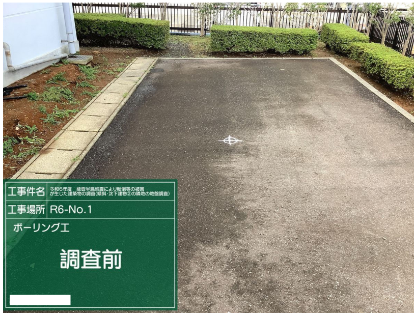
ボーリング工 R6-No.1 調査前
