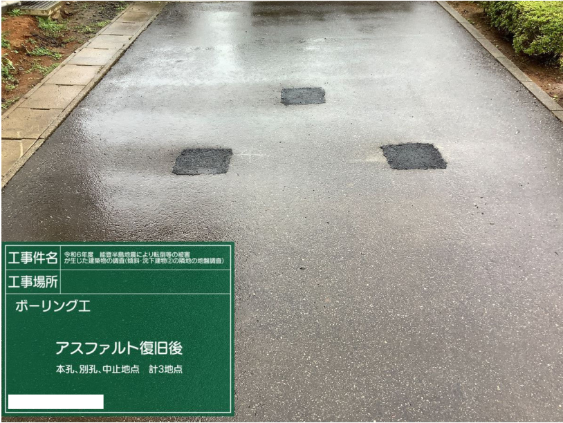
ボーリング工 R6-No.1 表層アスファルト復旧後
