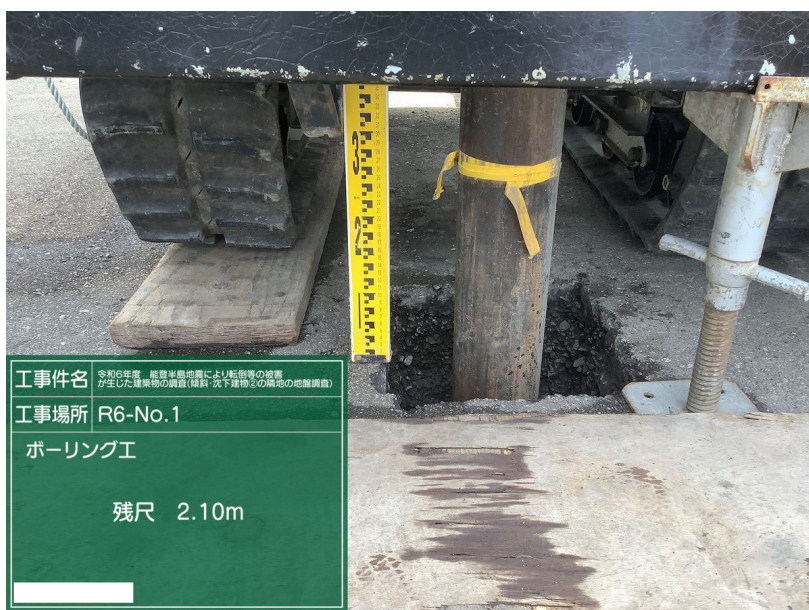
ボーリング工 R6-No.1 掘進長の確認 残尺 2.10m 近景下部
