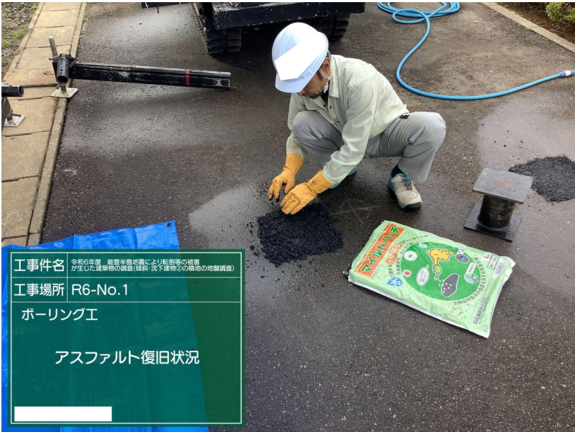
ボーリング工 R6-No.1 表層アスファルト復旧状況
