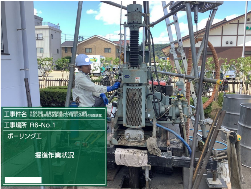
ボーリング工 R6-No.1 掘進作業状況
