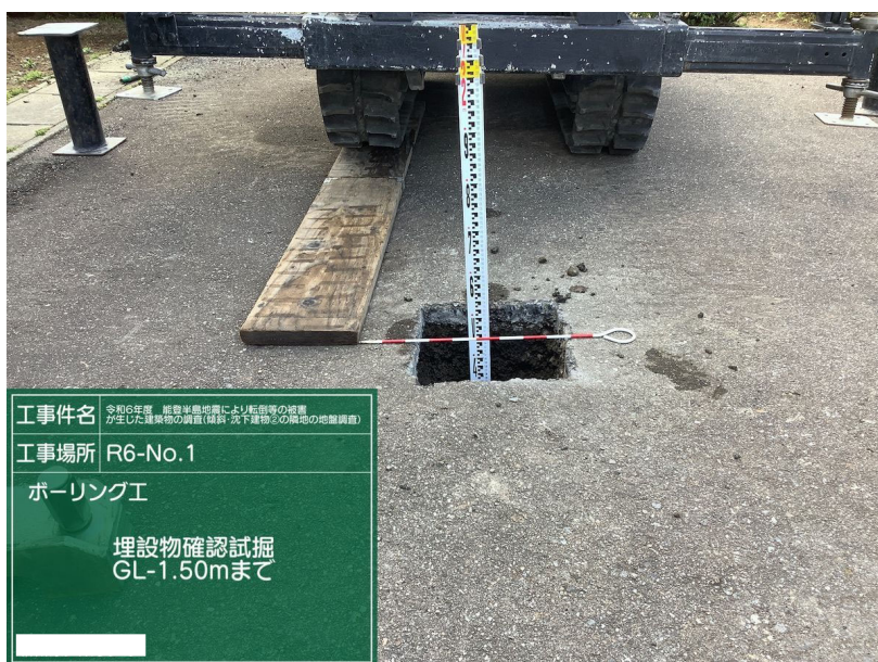
ボーリング工 R6-No.1 埋設物確認試掘 GL-1.50mまで
