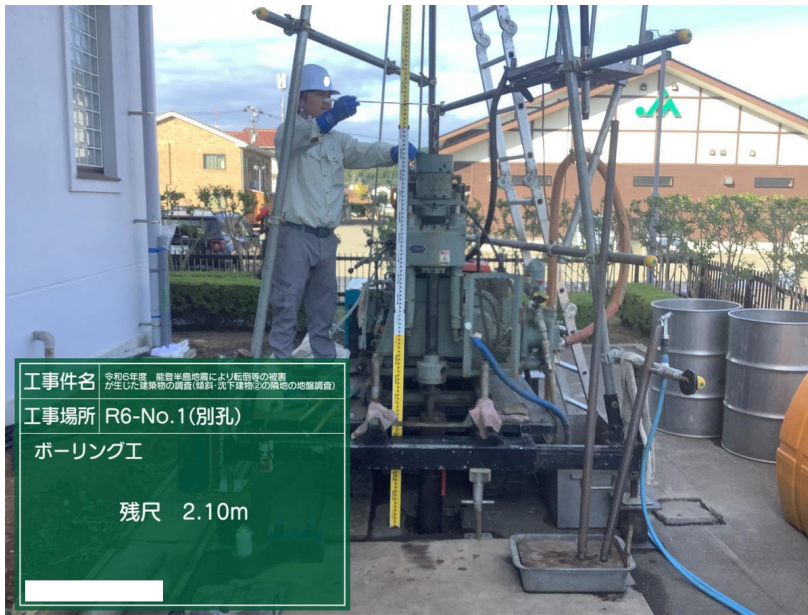
ボーリング工 R6-No.1(別孔) 掘進長の確認 残尺 2.10m
