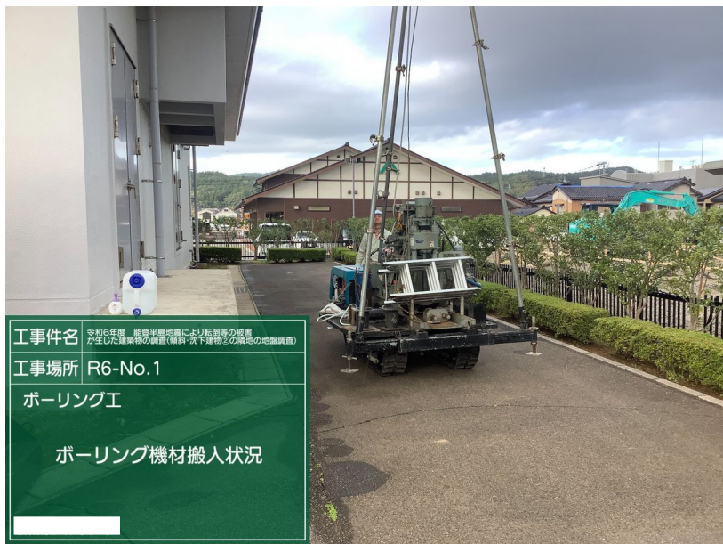
ボーリング工 R6-No.1 ボーリング機材搬入状況
