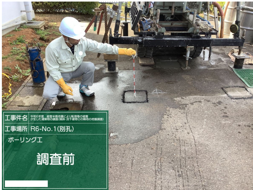
ボーリング工 R6-No.1(別孔) 調査前
