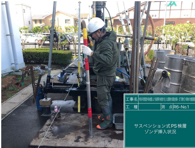
ボーリング工 R6-No.1 PS検層 サスペンション式 ゾンデ挿入状況
