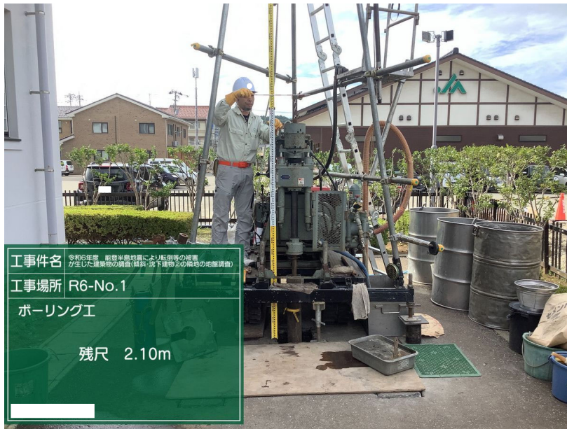
ボーリング工 R6-No.1 掘進長の確認 残尺 2.10m
