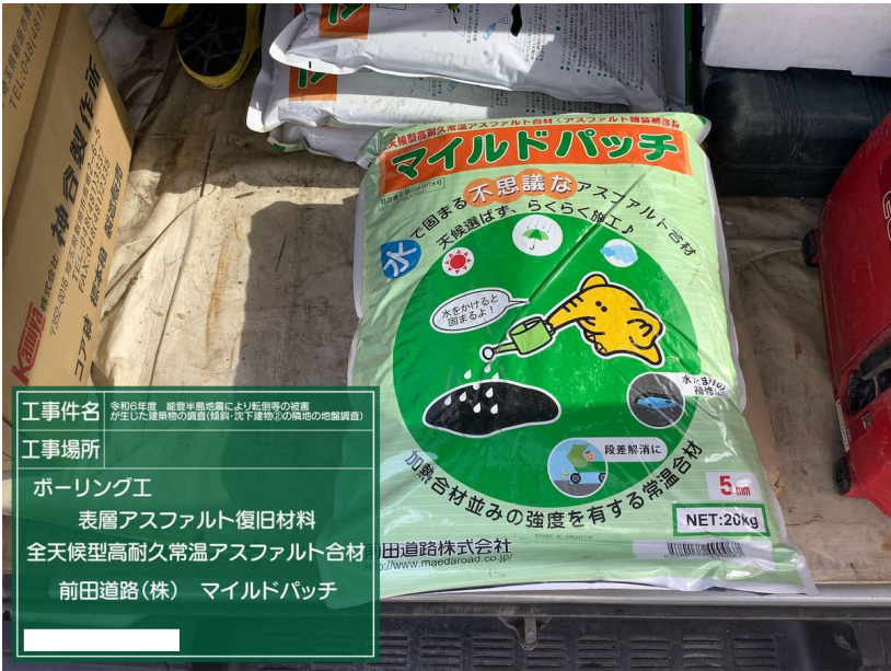
ボーリング工 R6-No.1 表層アスファルト復旧材料 マイルドパッチ
