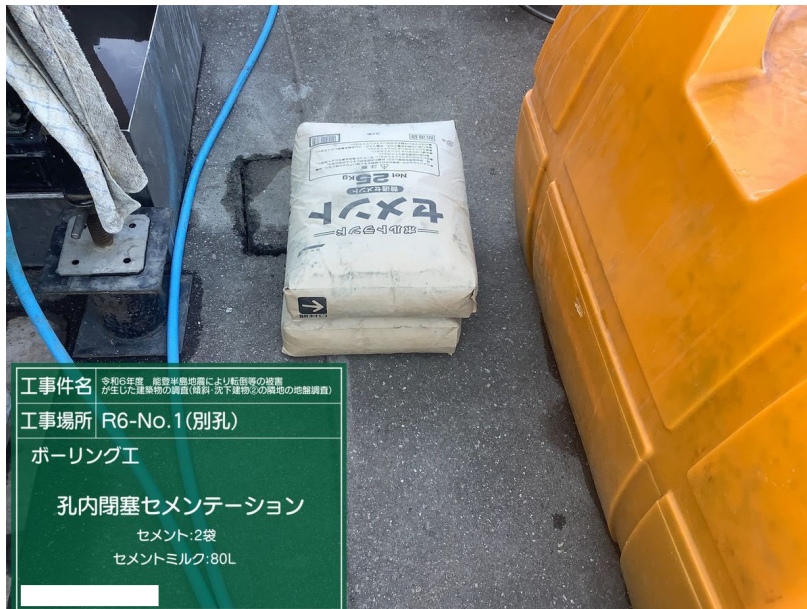
ボーリング工 R6-No.1(別孔) 孔内閉塞セメンテーション
