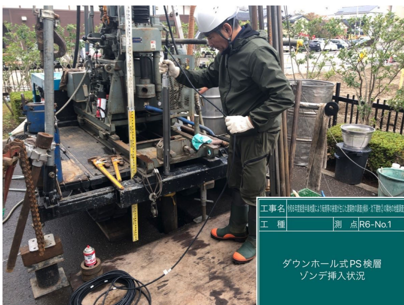
ボーリング工 R6-No.1 PS検層 ダウンホール式 ゾンデ挿入状況
