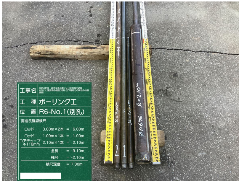
ボーリング工 R6-No.1(別孔) 掘進長の確認 検尺深度 7.00m 近景下部
