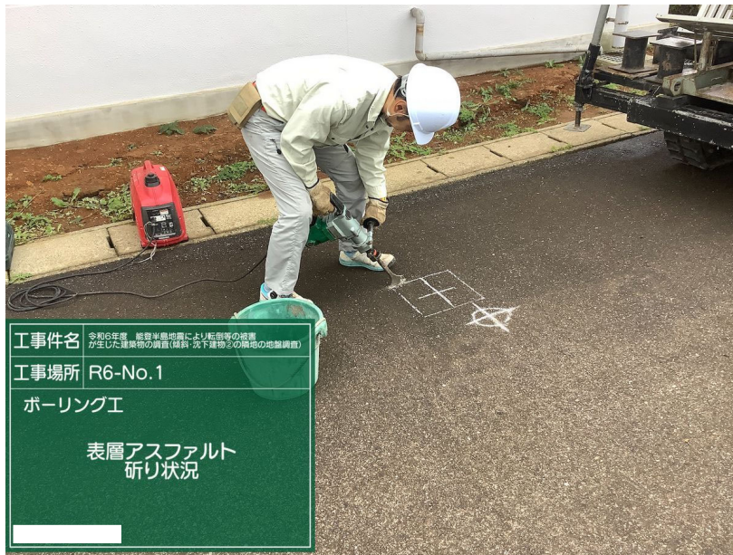
ボーリング工 R6-No.1 表層アスファルト研り状況
