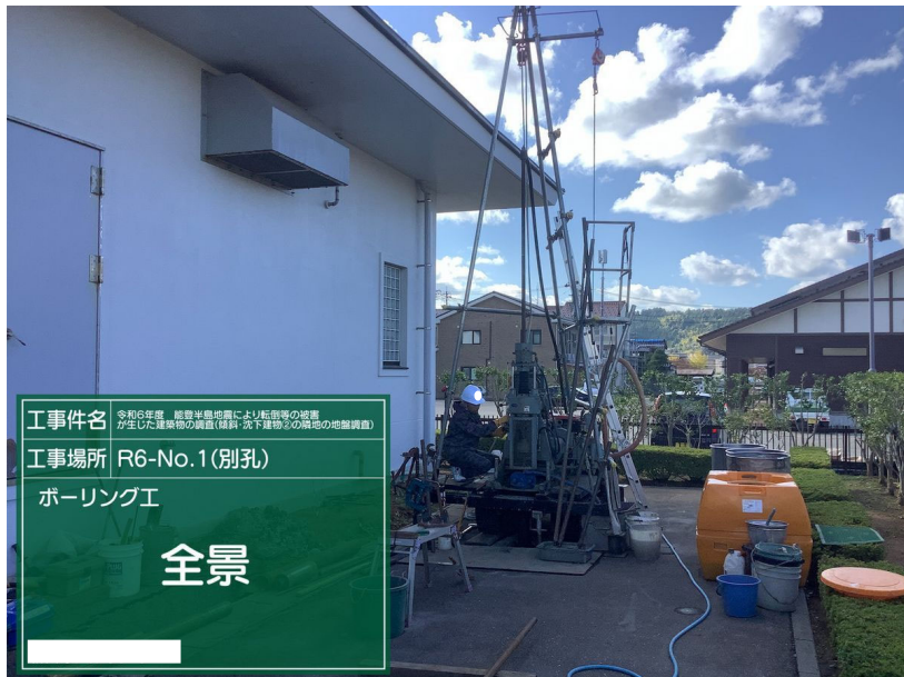
ボーリング工 R6-No.1(別孔) 全景
