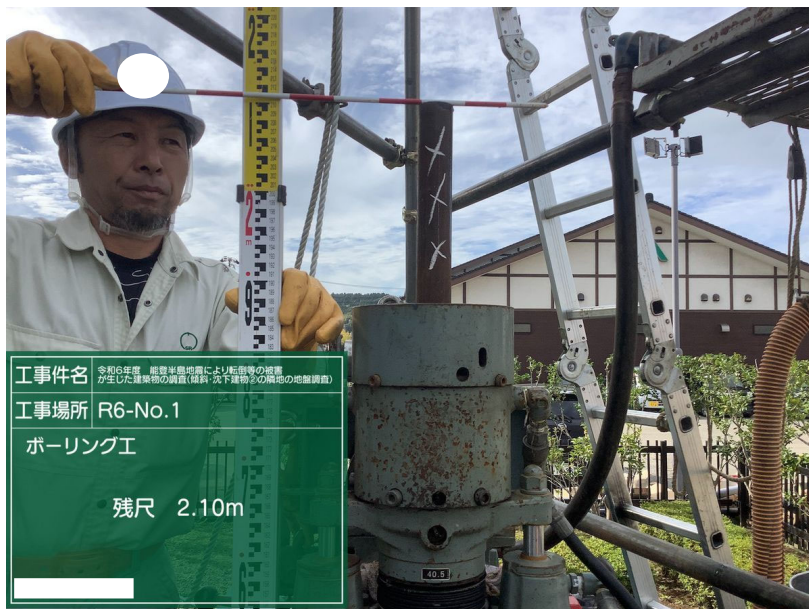
ボーリング工 R6-No.1 掘進長の確認 残尺 2.10m 近景上部
