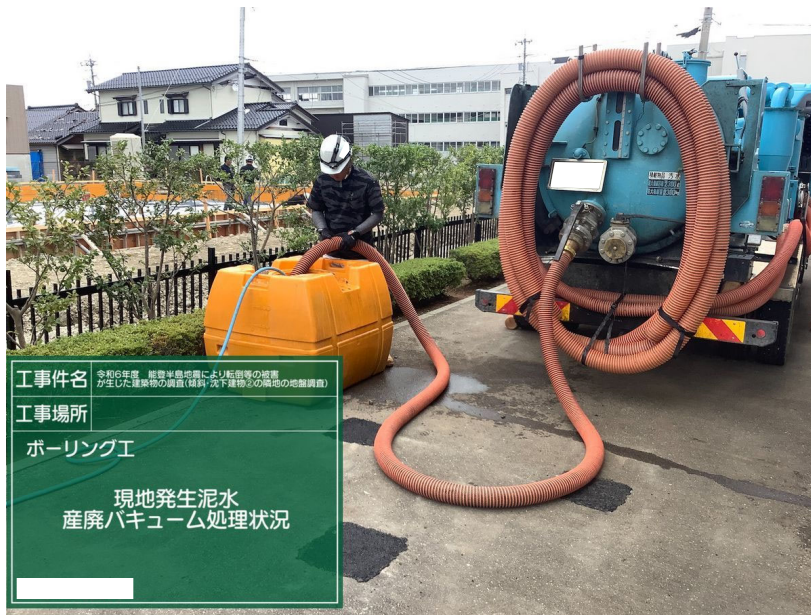
ボーリング工 現地発生泥水 バキューム搬出状況
