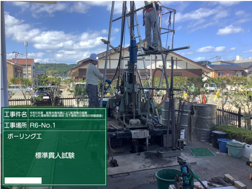
ボーリング工 R6-No.1 標準貫入試験
