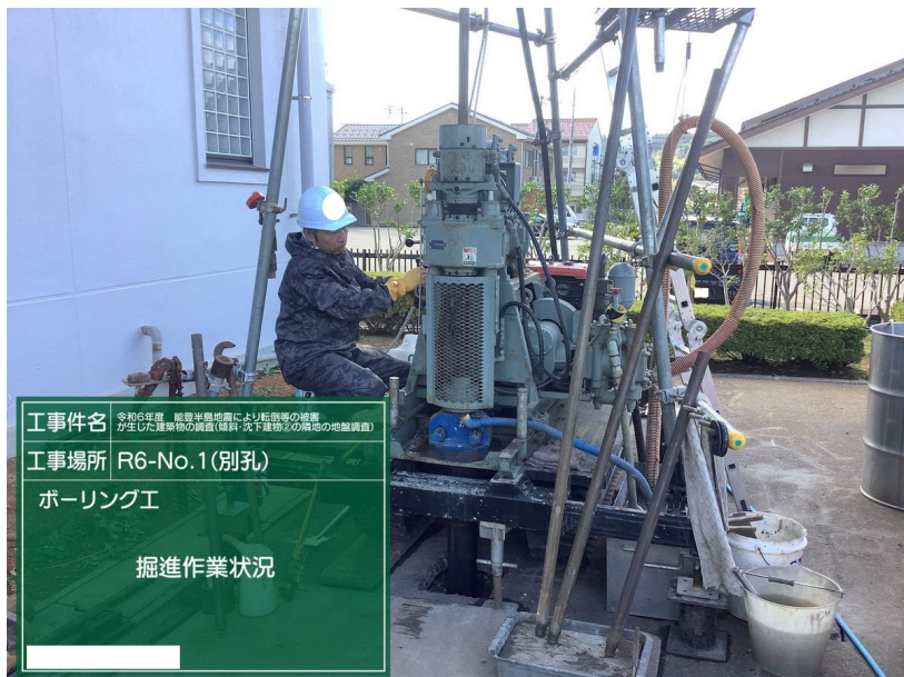
ボーリング工 R6-No.1(別孔) 掘進作業状況
