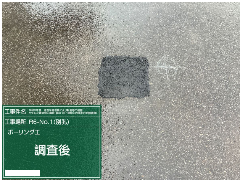
ボーリング工 R6-No.1(別孔) 調査後
