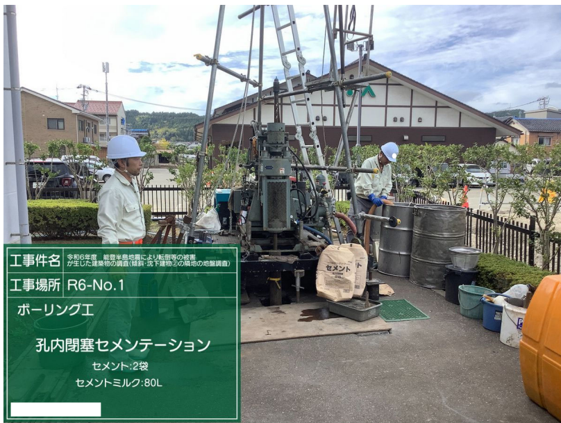
ボーリング工 R6-No.1 孔内閉塞セメンテーション
