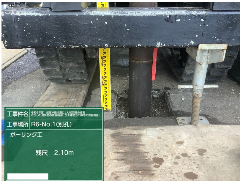
ボーリング工 R6-No.1(別孔) 掘進長の確認 残尺 2.10m 近景下部
