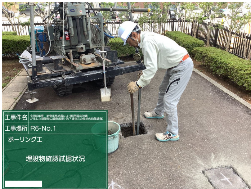
ボーリング工 R6-No.1 埋設物確認試掘状況
