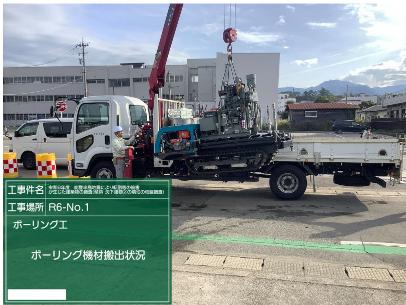
ボーリング工 R6-No.1(別孔) ボーリング機材搬出状況
