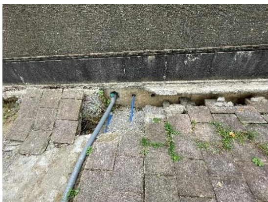
図 4.1.5 給水のバイパス（建築物 A）
