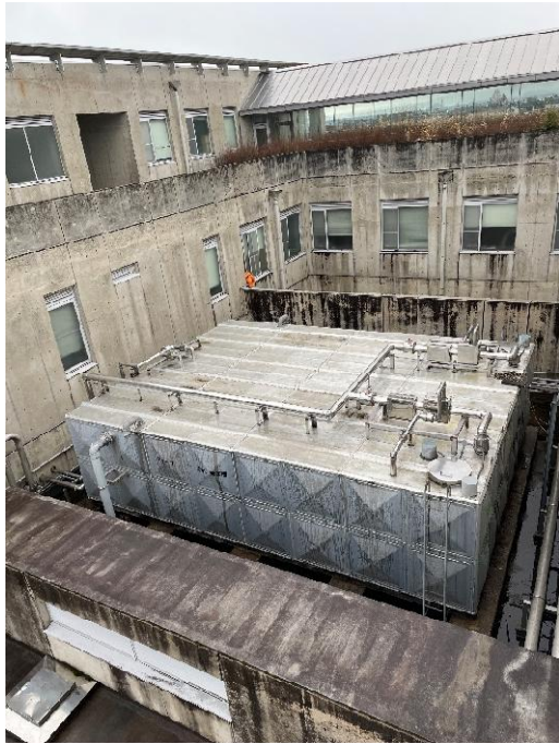
(a) 受水タンク設置全景
