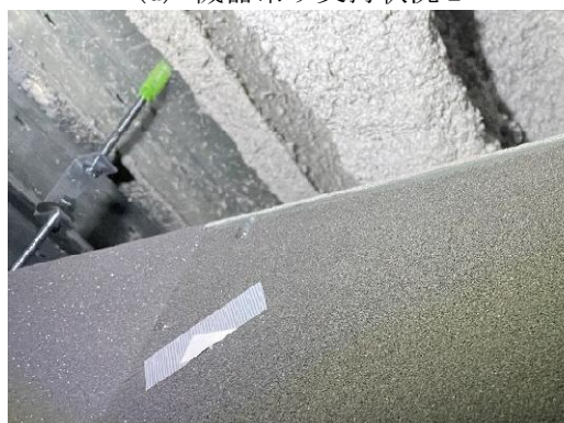
(f) 機器吊り支持状況 4
