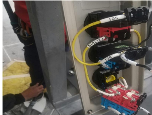
(b) 冷却塔現場操作箱の損傷
