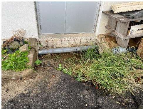
(d) 地中埋設配管の復旧状況
