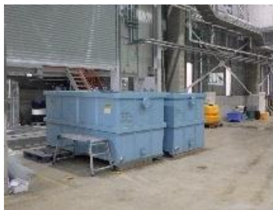
(b) プラント冷却用仮設タンク
