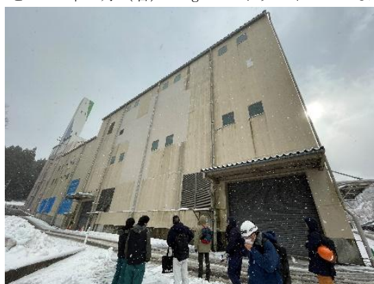
(c) RDF 棟（外壁復旧跡）
