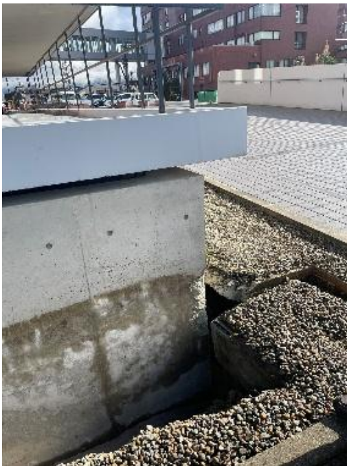
(b) 本館の基礎と周囲との段差
