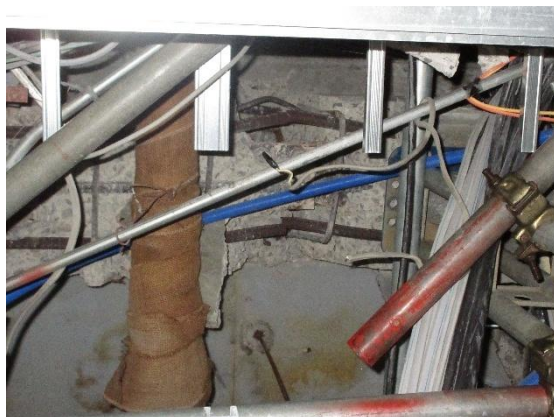
図 4.32.8 2 階梁の損傷
