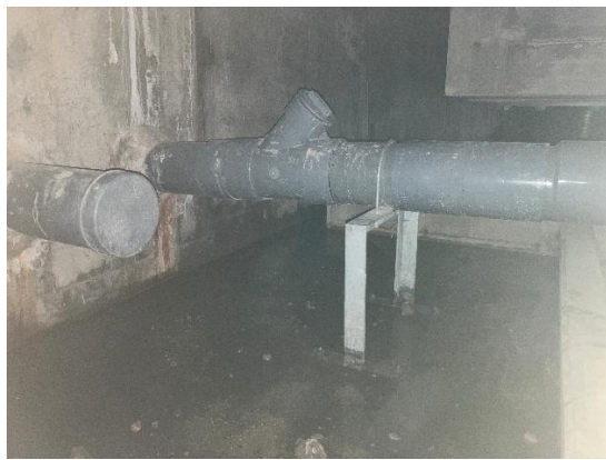
(a) 本館地下の免震層内の配管
