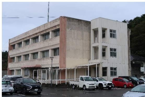
図 4.30.2 建築物外観（建築物 AD-2）
