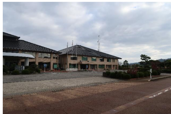
図 4.33.2 建築物外観（建築物 AG-2）
