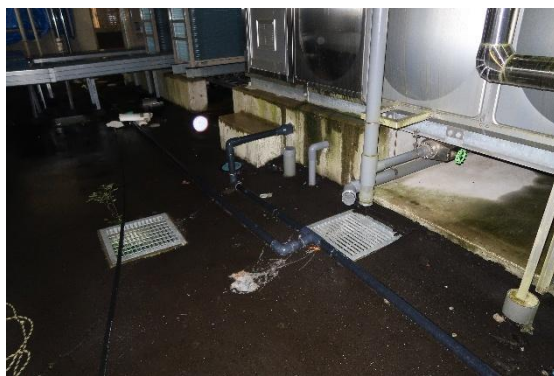
図 4.32.10 受水タンクの仮設配管
