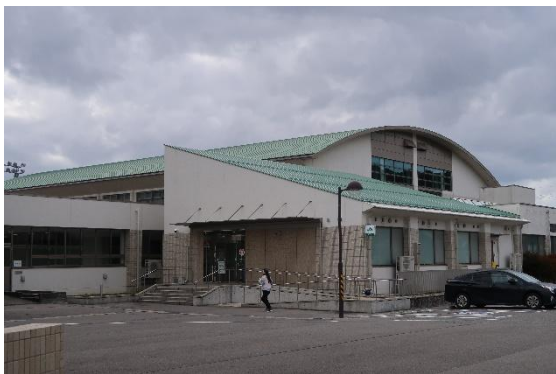
図 4.33.9 建築物外観（建築物 AG-5）
