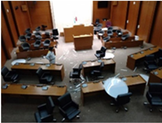
(a) 床に落下した照明器具
