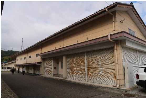
図 4.33.3 建築物外観（建築物 AG-3）
