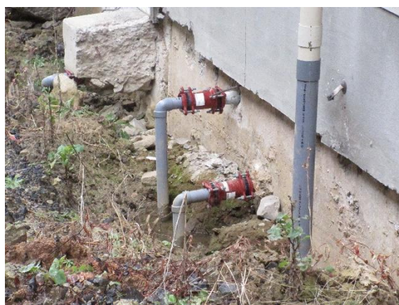
(d) 排水管の復旧状況
