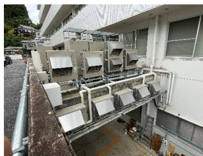
(a) 空調室外機設置状況 1
