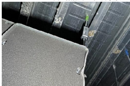
(d) 機器吊り支持状況 2
