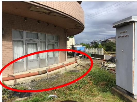
(b) 地下水汲み上げ配管敷設
