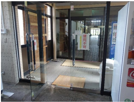
図 4.33.14 渡り廊下に面する出入口
