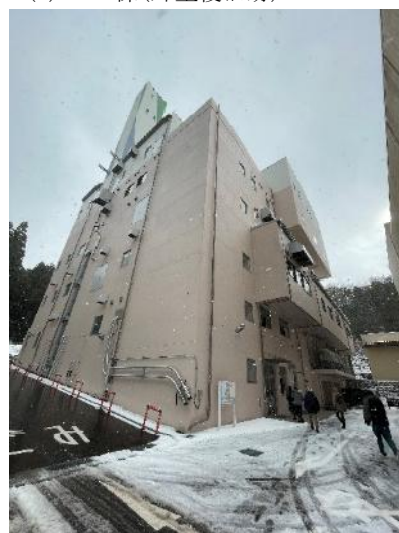
(e) クリーンセンター棟
