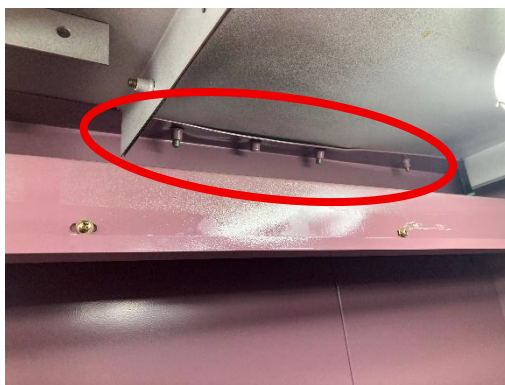
図 4.4.8 企画展示棟 2 エレベータ（天井プレート連結部損傷）
