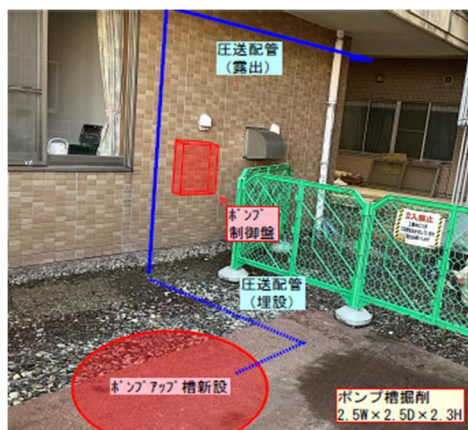
図 4.8.3 排水管の復旧計画
