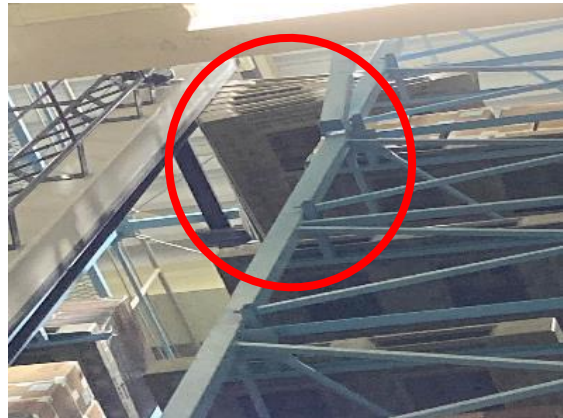
(b) 上部パレットの被害
