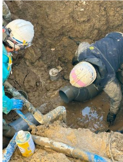
(b) 本館玄関前での埋設排水管の復旧工事状況（施設管理者より提供）
