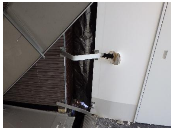
(c) 3号棟5病棟の間のエキスパンションジョイント（内側）（施設管理者より提供）
