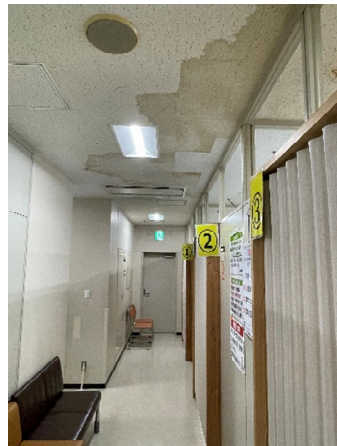
5 (a) 天井ボードの落下状況（施設管理者より提供） (b) 天井修復後の状況 図 4.17.4 天井内給水配管の漏水による天井ボードの落下状況と修復後の状況
