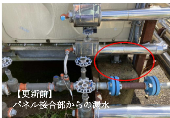
図 4.8.4 屋外受水タンクのパネル接合部からの漏水
