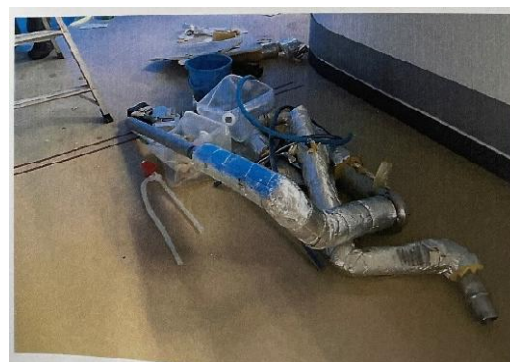
(b) 天井内配管撤去
