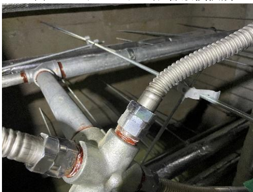
(c) 天井内配管施工状況
