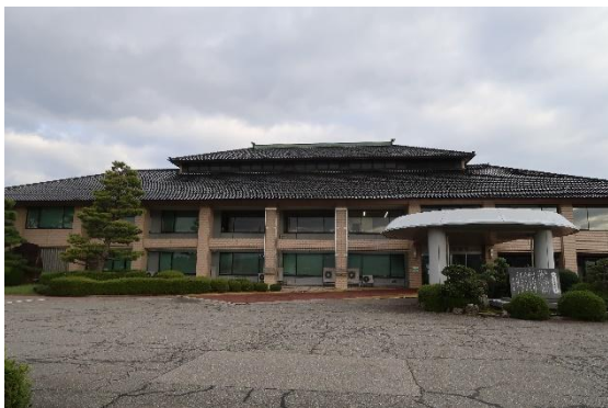
図 4.33.1 建築物外観（建築物 AG-1）
