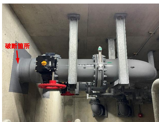
(d) 修復・補強後の循環ろ過配管
