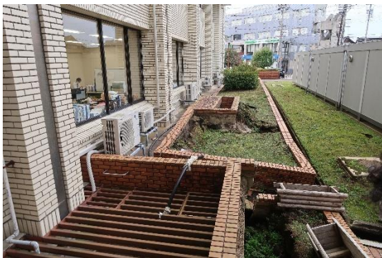
図 4.29.11 受水タンクに向かう仮設配管
