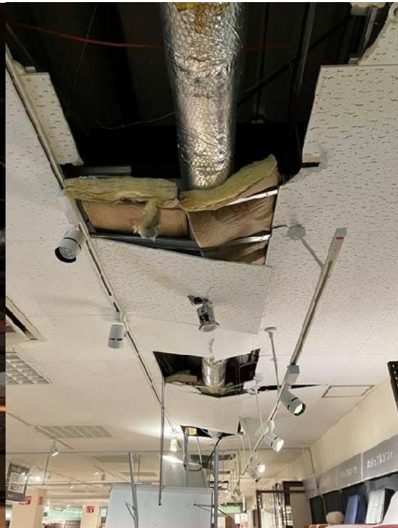
図 4.11.3 配管の脱落
