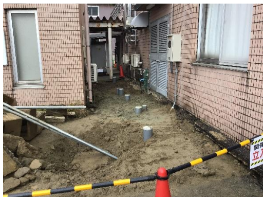
(a) 建築物周囲の排水管復旧状況
