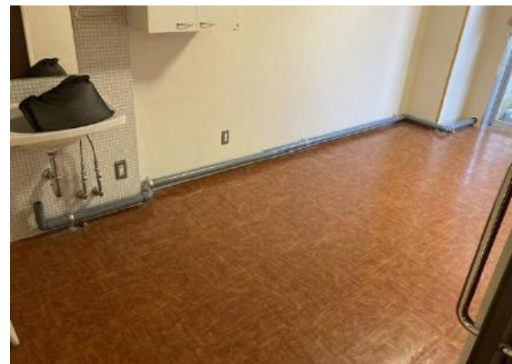
図 4.12.5 露出配管による排水の復旧状況
