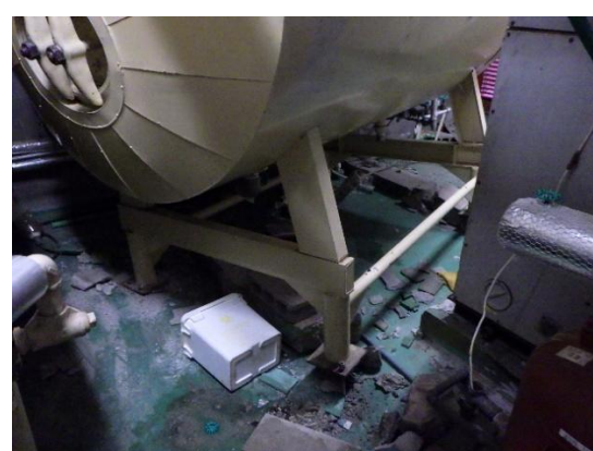
図 4. 21. 6 3 病棟屋上のストレージタンクの被害状況（施設管理者より提供）
