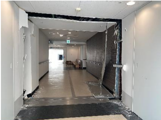
(c) 3号棟5病棟の間のエキスパンションジョイント（内側）（施設管理者より提供）
