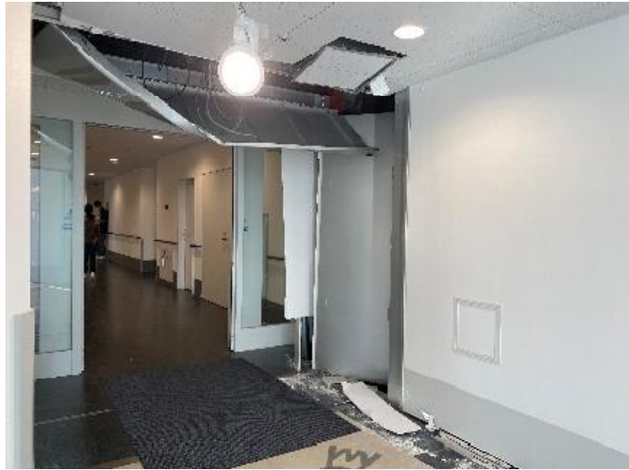
(b) 本館と3号棟の間のエキスパンションジョイント（内側）（施設管理者より提供）
