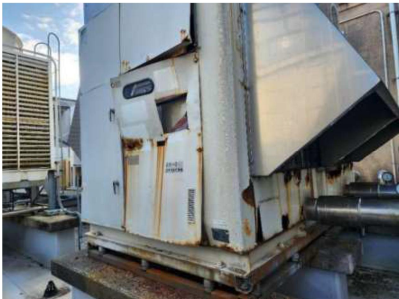
図 4.6.7 破損した冷却器（施設管理者より提供）
