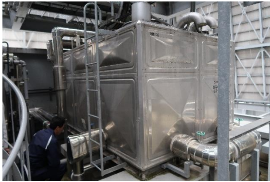
図 4. 27. 7 高置タンク（ステンレス製）
