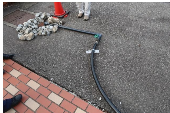
図 4.29.10 給水元に接続された仮設配管
