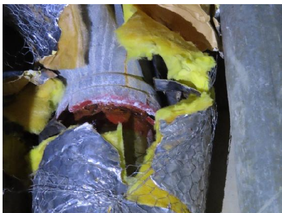
図 4.2.2 雑排水管の補修箇所
