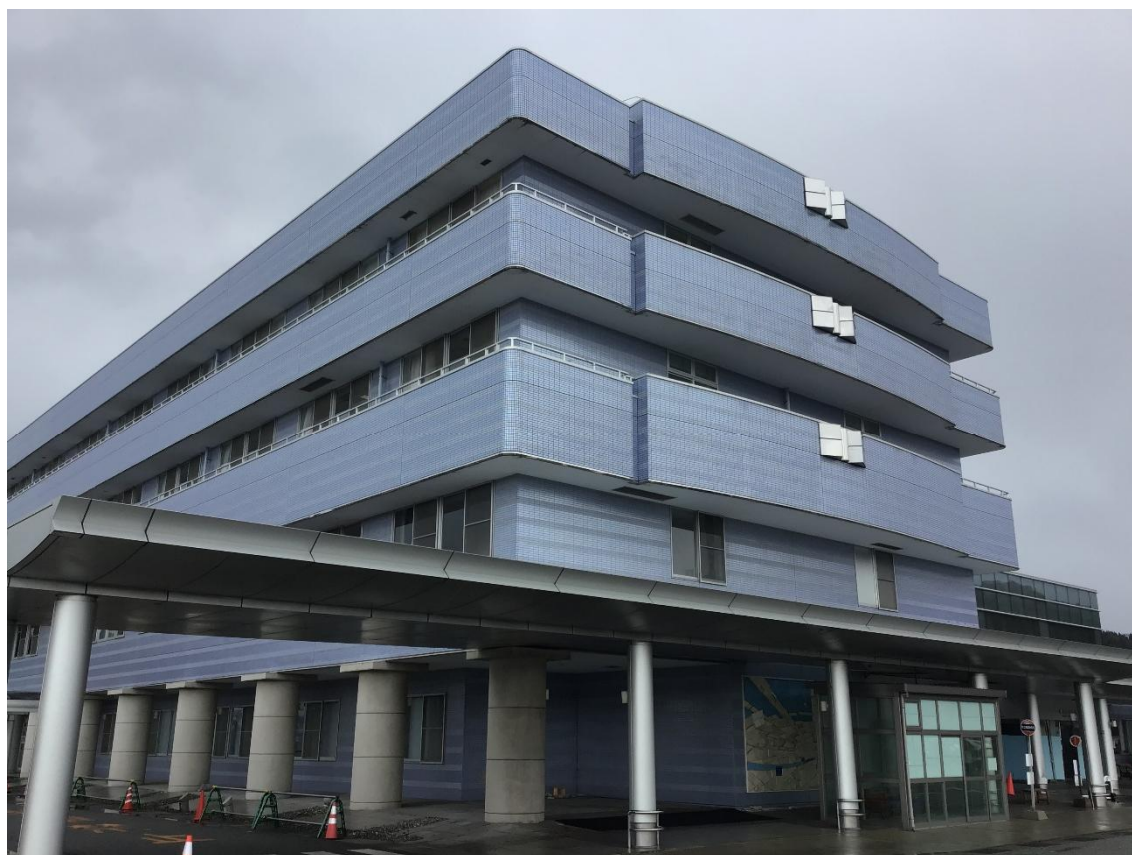
図 4.22.1 建築物外観（建築物Ⅴ）
