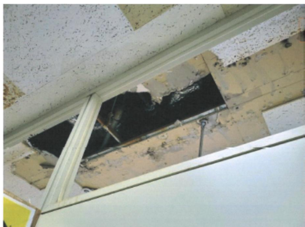
5 (a) 天井ボードの落下状況（施設管理者より提供） (b) 天井修復後の状況 図 4.17.4 天井内給水配管の漏水による天井ボードの落下状況と修復後の状況
