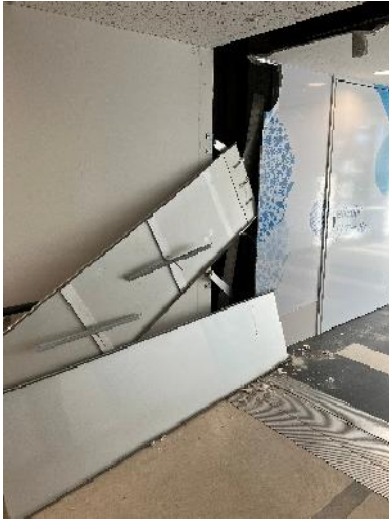
(b) 本館と3号棟の間のエキスパンションジョイント（内側）（施設管理者より提供）
