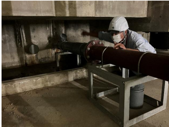
(a) 本館地下の免震層内の配管
