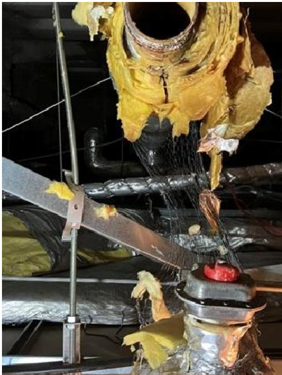
図 4.11.2 配管の破断
