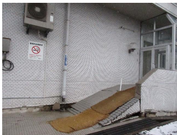
(b) 出入口スロープ
