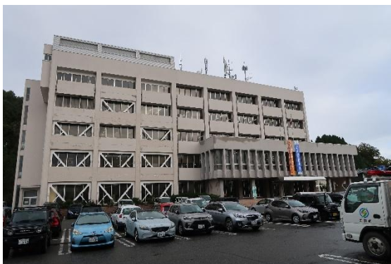
図 4.30.1 建築物外観（建築物 AD-1）
