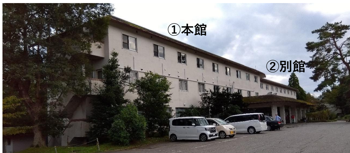
図 4.18.1 建築物外観（建築物 R ①本館、②別館）
