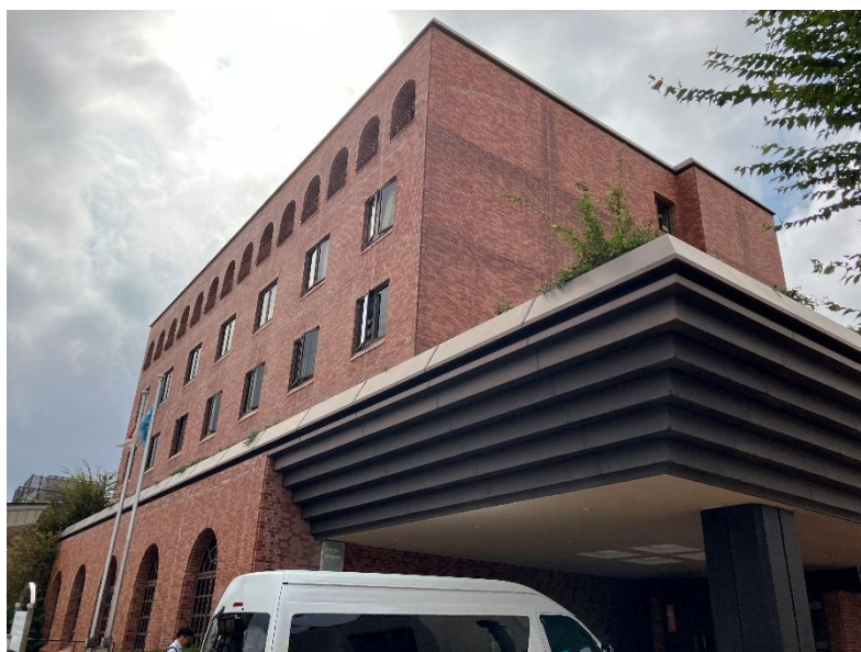
図 4.2.1 建築物外観（東側）（建築物 B）
