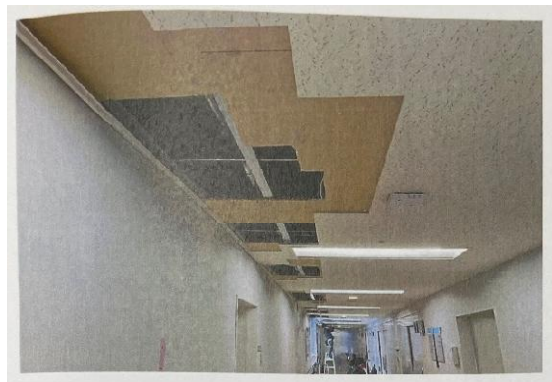
(b) 天井解体状況
