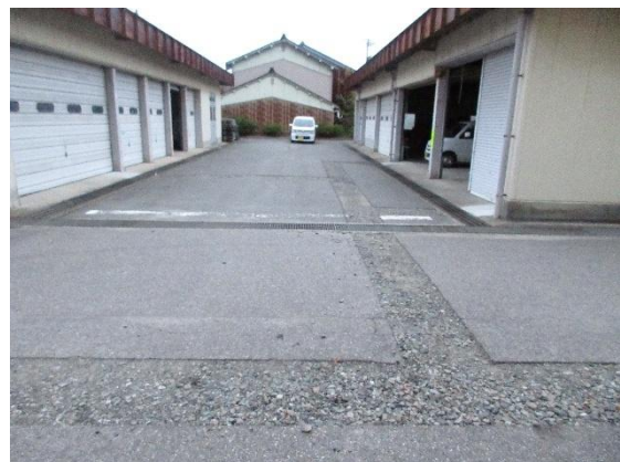
図 4.29.12 東側車庫周辺の配管補修
