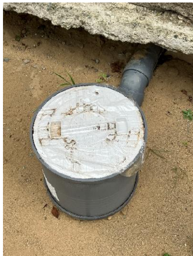
図 4.1.3 仮設マンホール（建築物 A）
