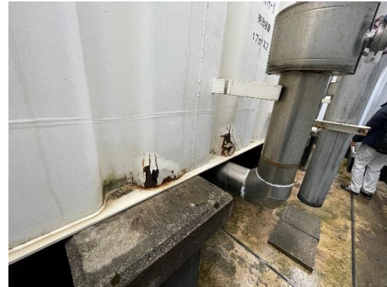
(b) 高置タンクずれとアンカーボルト破断
