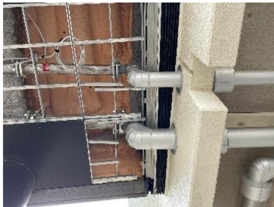
図 4.15.4 渡り廊下エキスパンションジョイント部の消火設備配管復旧状況
