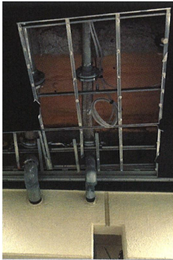
図 4.15.3 断裂し漏水した渡り廊下エキスパンションジョイント部の消火設備配管 (施設管理者より提供)
