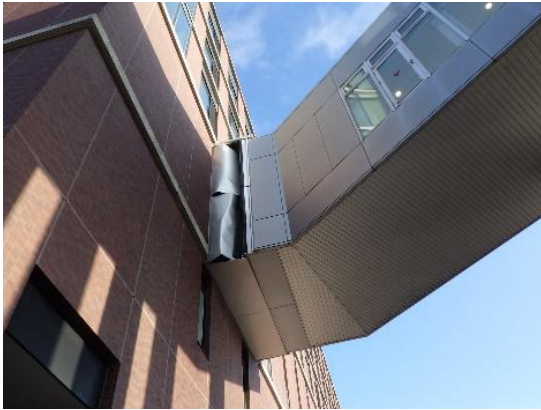
5 (a) 本館と3号棟の間のエキスパンションジョイント（外側）（右は施設管理者より提供）
