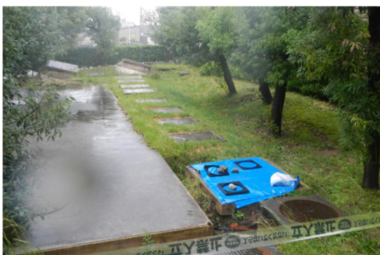
(a) 浄化槽廻り全景
