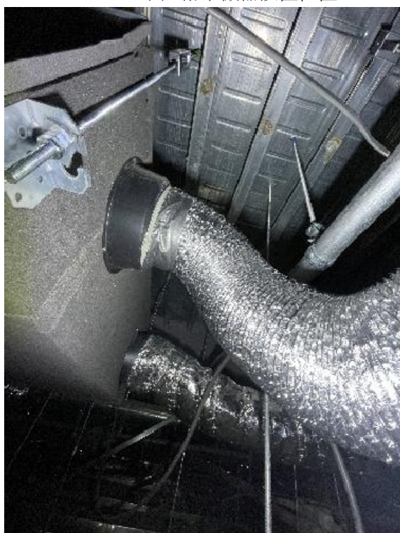
(e) 機器吊り支持状況 3
