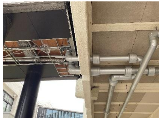
図 4.15.4 渡り廊下エキスパンションジョイント部の消火設備配管復旧状況
