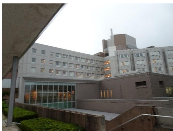
(a) 総合病院棟（東側）
