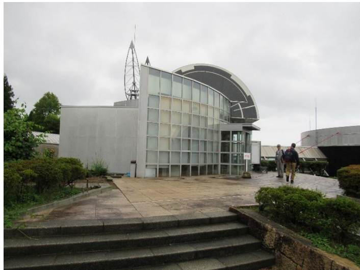
図 4.4.1 建築物外観（南側）（建築物 D 管理棟）
