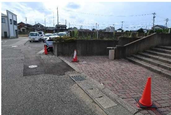
図 4.28.7 建築物 AB 東側の地盤変状
