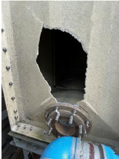
5 図 4. 21. 4 穴が開いて使えなくなった上水用高置タンク（左）と井水用高置タンク（右）
