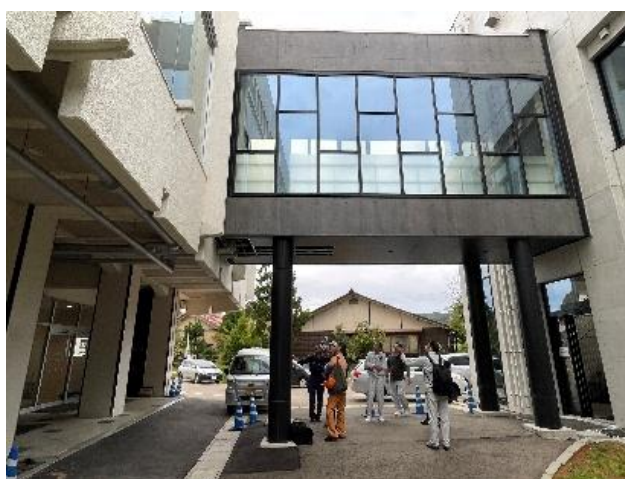
図 4.15.2 消火設備配管が断裂し漏水した渡り廊下
