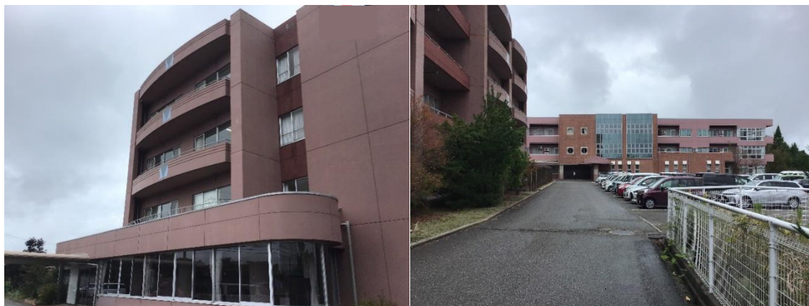
図 4.19.1 建築物外観（建築物 S）
