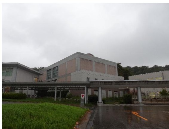
(d) 体育館棟（東側）
