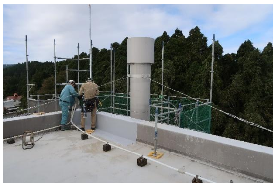
図 4.30.12 煙突の新設（建築物 AD-1）
