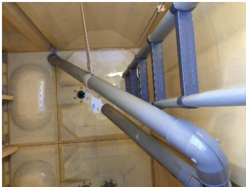
図 4.21.8 タンク内部配管の破断状況（施設管理者より提供）
