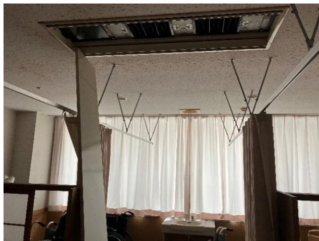
図 4. 26. 5 ファンコイルユニットカバーの落下（建築物 Z）
