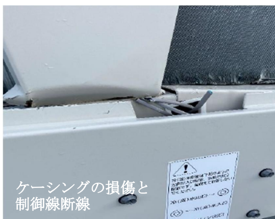
図 4.8.5 屋上空冷ヒートポンプチラーの損傷
