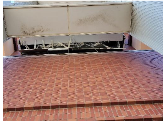
5 (a) 本館と3号棟の間のエキスパンションジョイント（外側）（右は施設管理者より提供）
