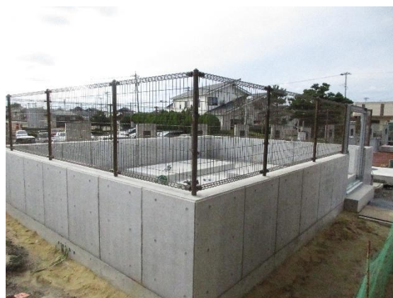
図 4.28.4 屋外に建設中の自家発電設備
