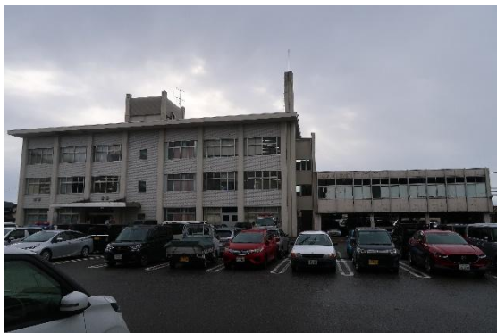
図 4.30.3 建築物外観（建築物 AD-3）
