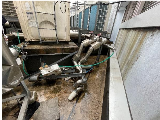
(a) 屋上にて破損した配管
