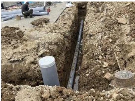
図 4.12.4 メイン排水管の復旧工事の状況
