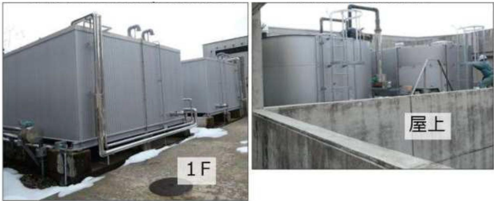
(a) 受水タンク (b) 高置タンク
