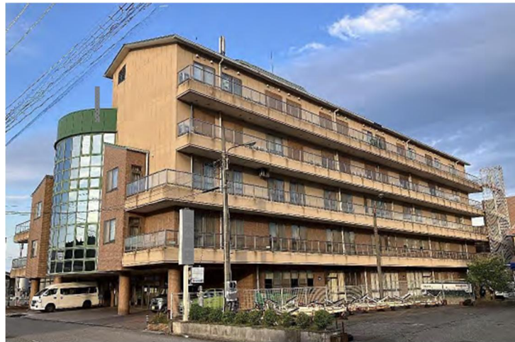
図 4.8.1 建築物外観（建築物 H）
