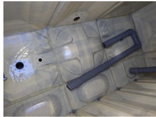
図 4.21.8 タンク内部配管の破断状況（施設管理者より提供）
