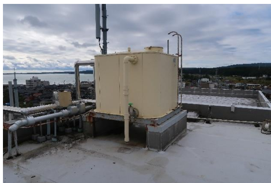
図 4.30.6 高置タンク（建築物 AD-1）
