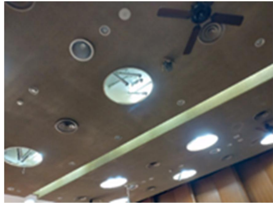
(b) 破損した照明器具
