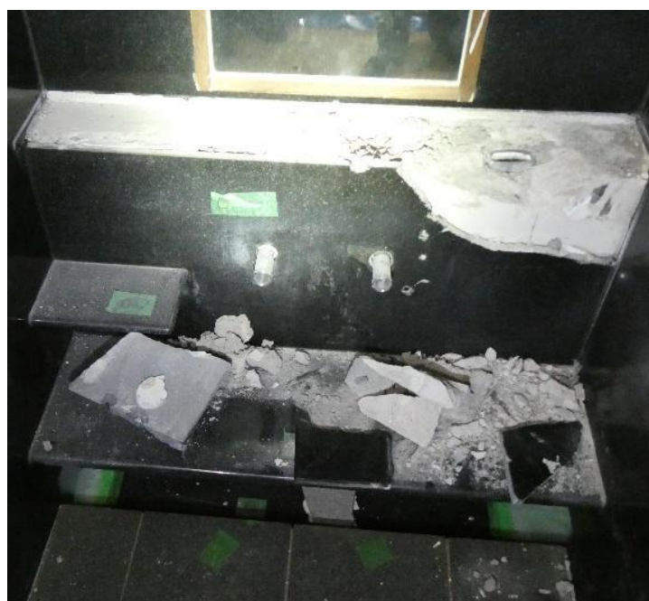
図 4. 9. 6 洗い場の埋設配管（給水・給湯）
