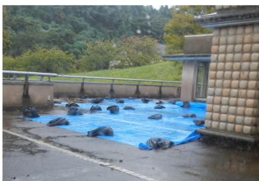
(a) 防水損傷対策
