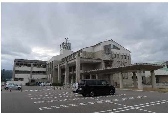
図 4.33.7 建築物外観（建築物 AG-4）
