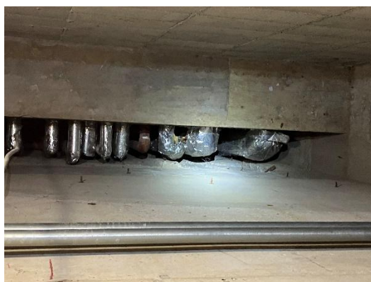
図 4.2.4 地階から見上げたシャフト
