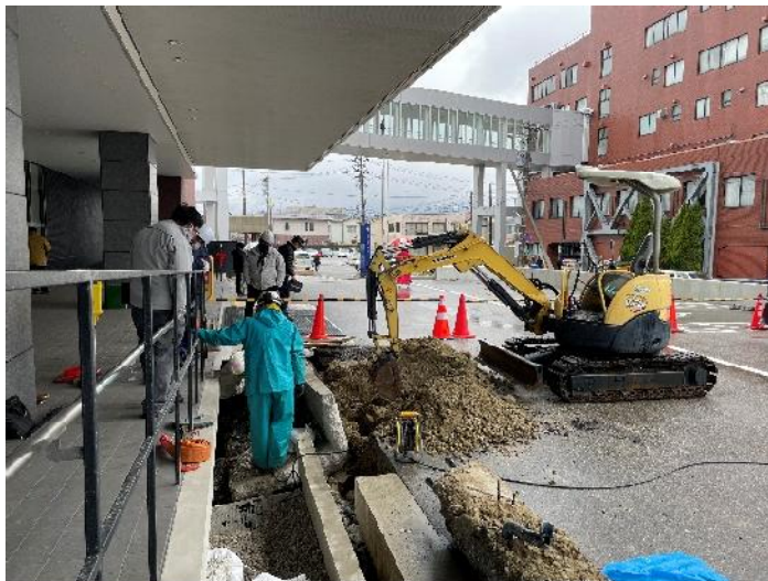
(b) 本館玄関前での埋設排水管の復旧工事状況（施設管理者より提供）
