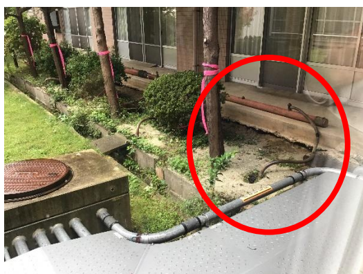
(a) 地下水汲み上げ工事状況
