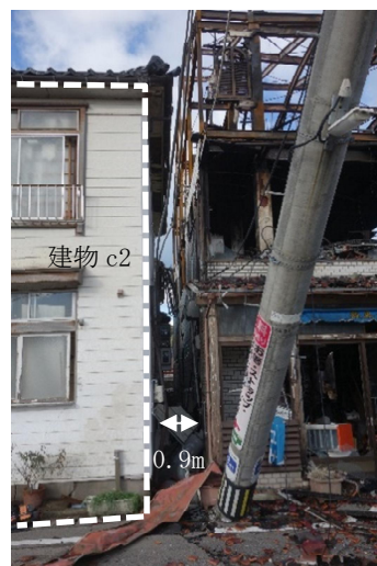
(イ) 建物 c2 の東側から北面を見た様子
