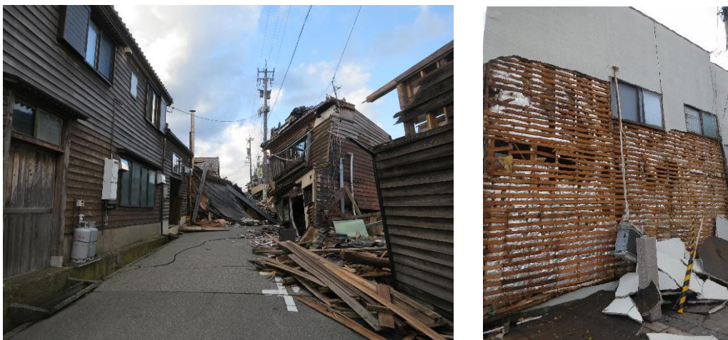
写真 2-1 焼失した区域周辺の市街地の様子
