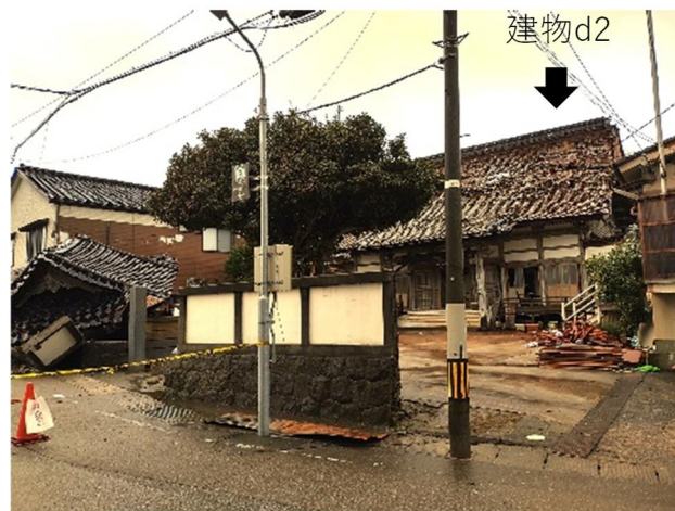
写真 2. 2-8 建物 d2 北側道路前の樹木の状況
