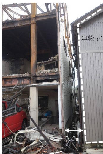
(ア) 建物 c1 の西側から北面を見た様子
