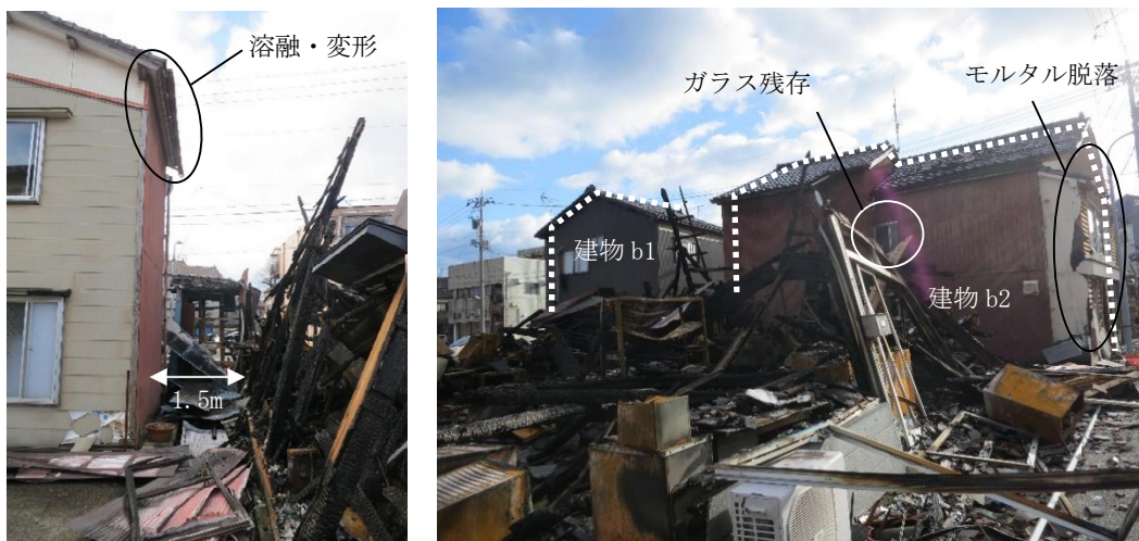
(ア) 北側から西面を見た様子
