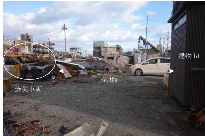
写真 2.2-3 建物 b1 の外周の状況：西面（外壁面と焼けた車両）
