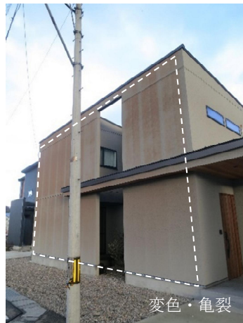
(ア) 南東側から見た建物全景
