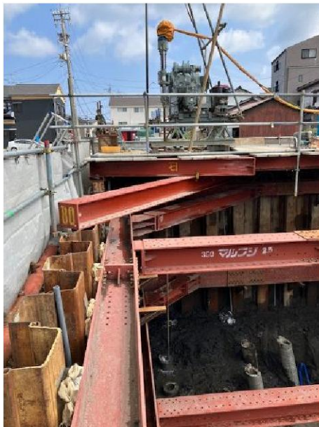
写真 3.1.4-1 杭中空部の土砂排出状況
