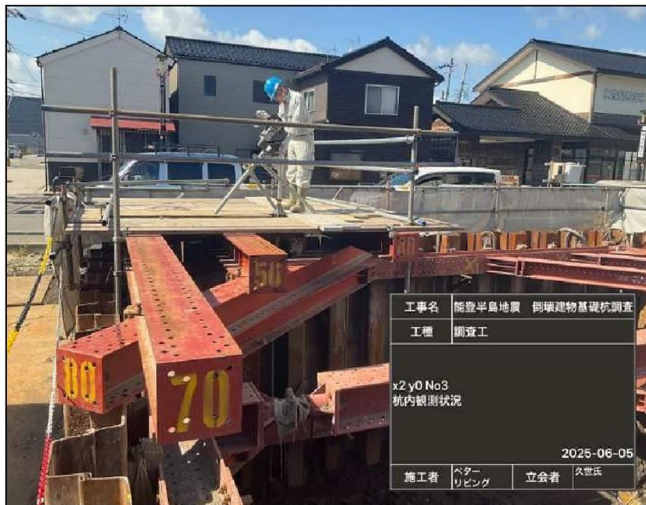
写真 3.1.4-4 ボアホールカメラの設置状況
