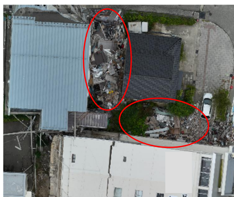
図 2. 2. 1-47 瓦礫堆積箇所
