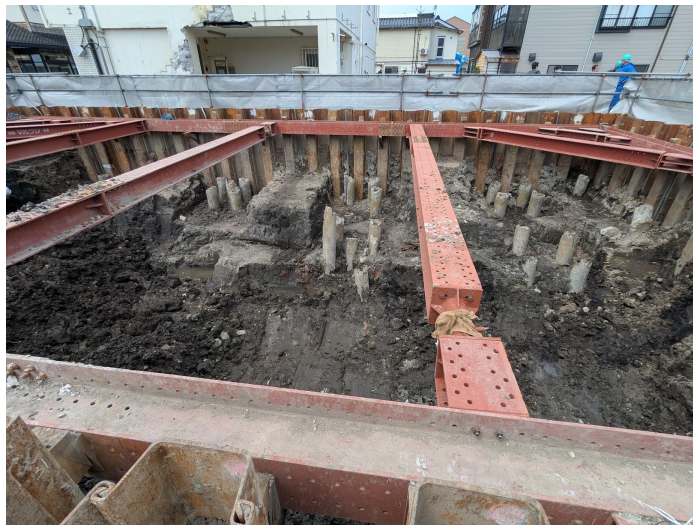
(a) 掘削（深さ約4 m～一部6 m）
