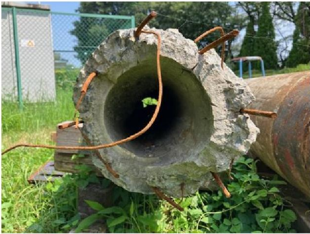
写真 3.1.3-1 採取した杭体
