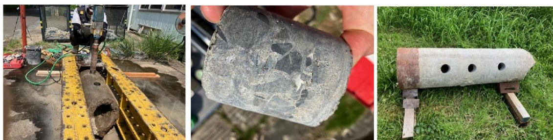
a) コアボーリング実施状況 b) 採取した供試体 c) 供試体採取後の杭
