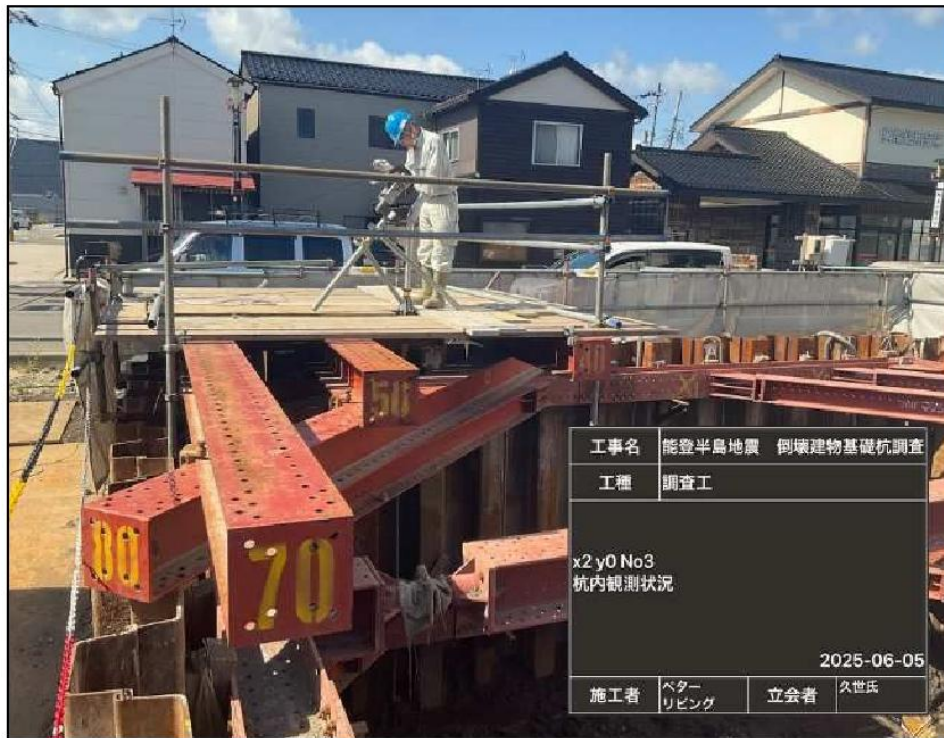
写真 3.1.4-4 ボアホールカメラの設置状況
