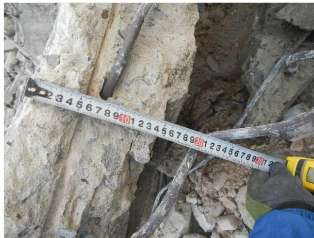
写真 1113-4 解体部材 EV 壁・壁厚 150mm 程度 仕上げモルタル 30mm 程度
