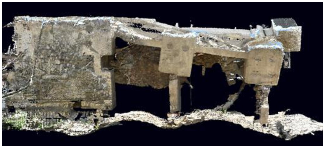
図 1.2.1-1 上部構造の調査状況
