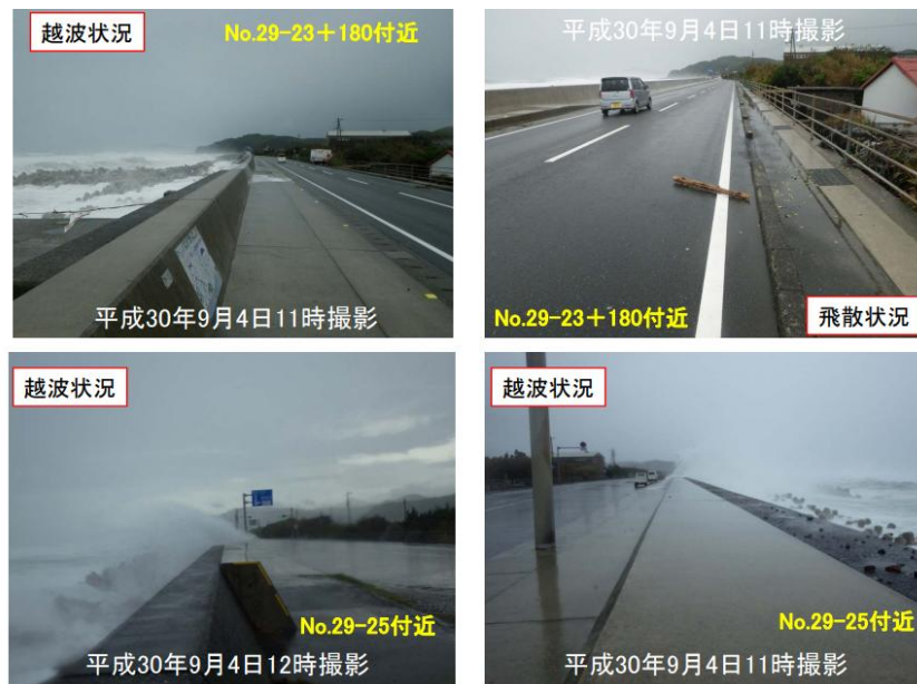
写真-3. 2. 2. 7 2018 年台風第 21 号での越波状況（四国地整提供）
