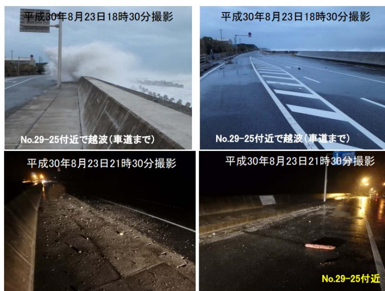
写真-3.2.2.6 2018 年台風第 19・20 号での越波状況（四国地整提供）
