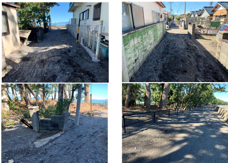
写真-3. 2. 1. 2 2019 年台風第 19 号での清水海岸における越波被害（静岡県提供）
