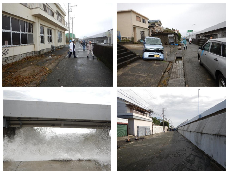
写真-3.2.1.3 越波状況及び越波による被害状況（神奈川県提供）
