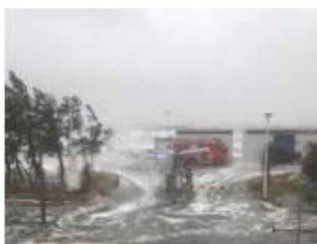
写真-3. 2. 1. 5 南芦屋浜における浸水状況 (大阪湾港湾等における高潮検討委員会資料 (2018))
