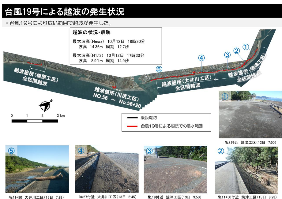
図-3.2.2.15 2019 年台風第 19 号による駿河海岸での越波被害状況（中部地整提供）
