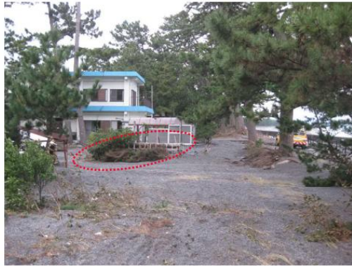
写真-3. 2. 1. 1 2017 年台風第 21 号での清水海岸における越波被害（静岡県提供）
