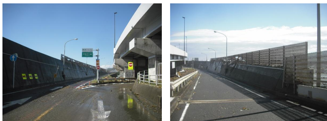
写真-3.2.2.8 越波による被害状況 (神奈川県提供)
