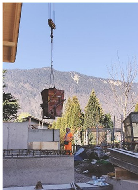
事例 1：クレーン作業_バケットで埋戻し土砂を運搬
