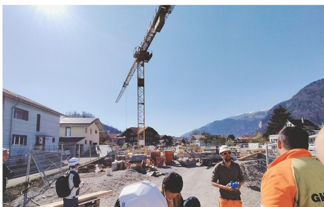
事例 2：現場全景
