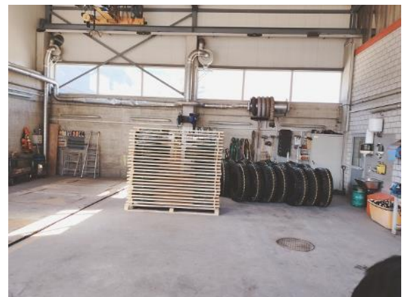
車両・重機整備場：作業ピット（左）
