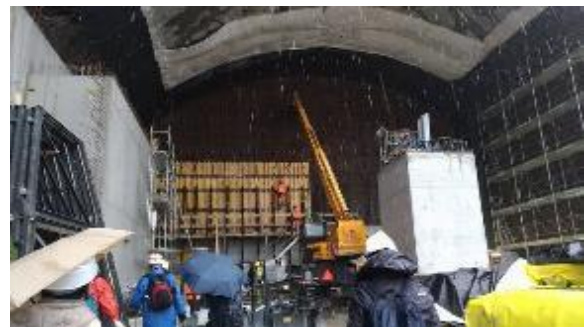
トンネル工事: 端部壁面の躯体工事
