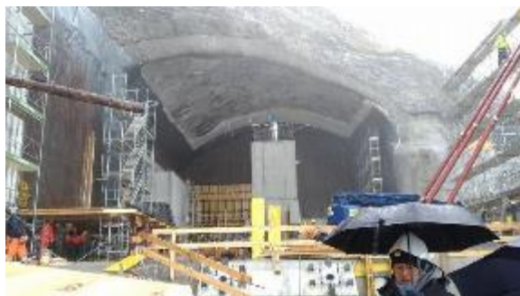
トンネル全景
