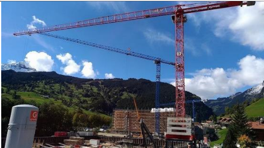
2 台のクレーンの設置状況
