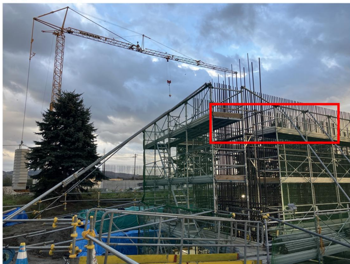
図 7-1 フーチングから鉛直方向に張り出した鉄筋を足場に固定する様子
