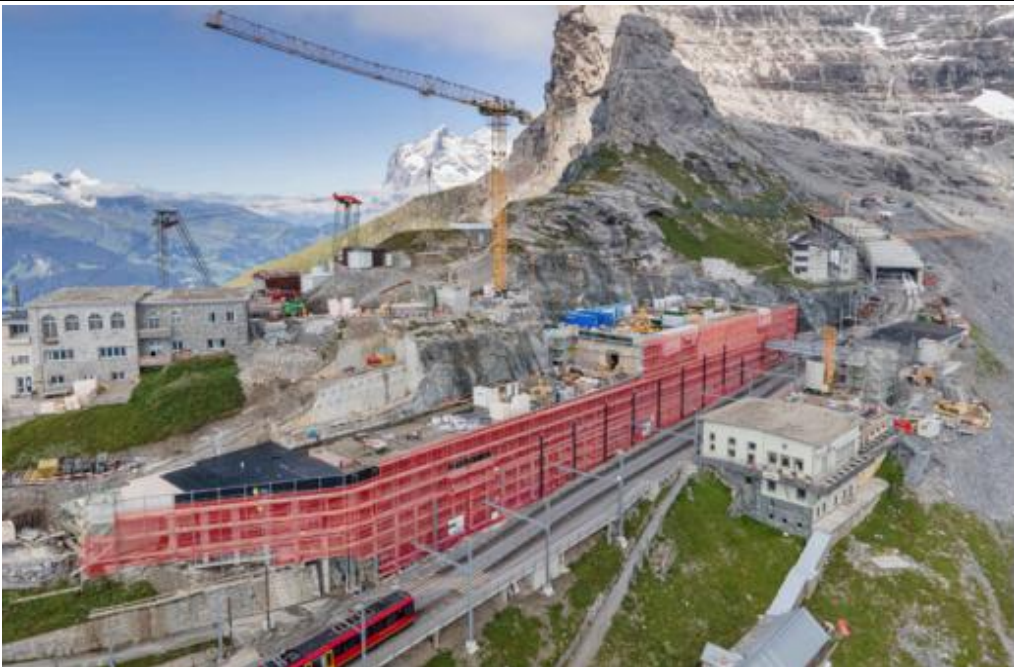
工事全景 < https://ghelma.ch/cmsfiles/2021_6435_neubau_v-bahn_grindelwald_%C3%BCbergeordnet.pdf >
