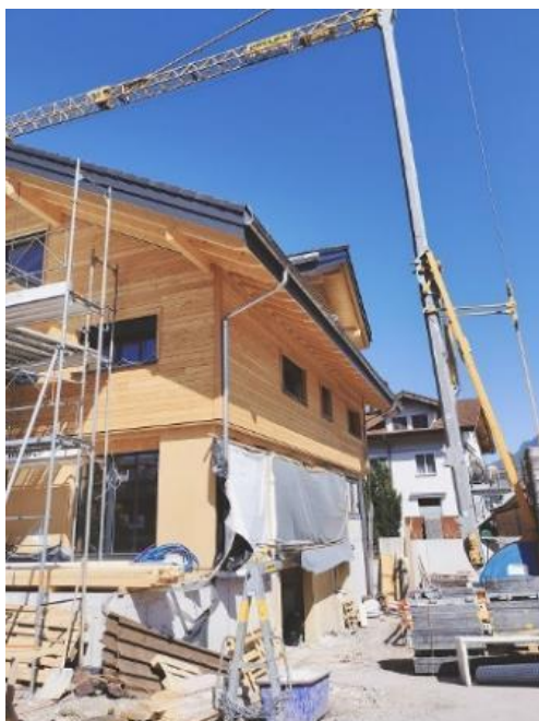
事例 1：現場全景
