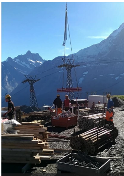
作業員付近でのクレーンによる運搬
