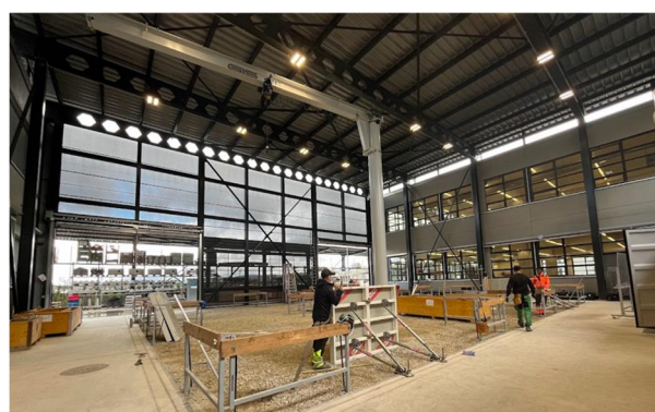
Sursee 建設教育・研修・訓練センター： 訓練風景(システム型枠。2024.10)
