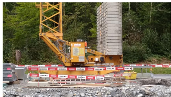
クレーン設置部分
