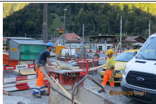
橋梁部分: 在来工法による曲面型枠
