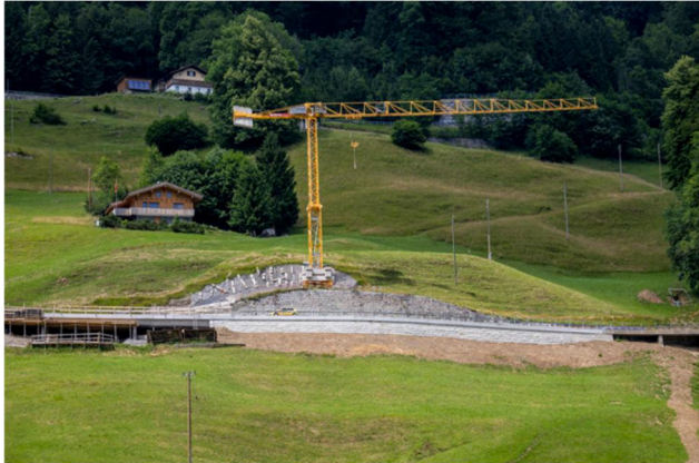
現場全景（1号機）
