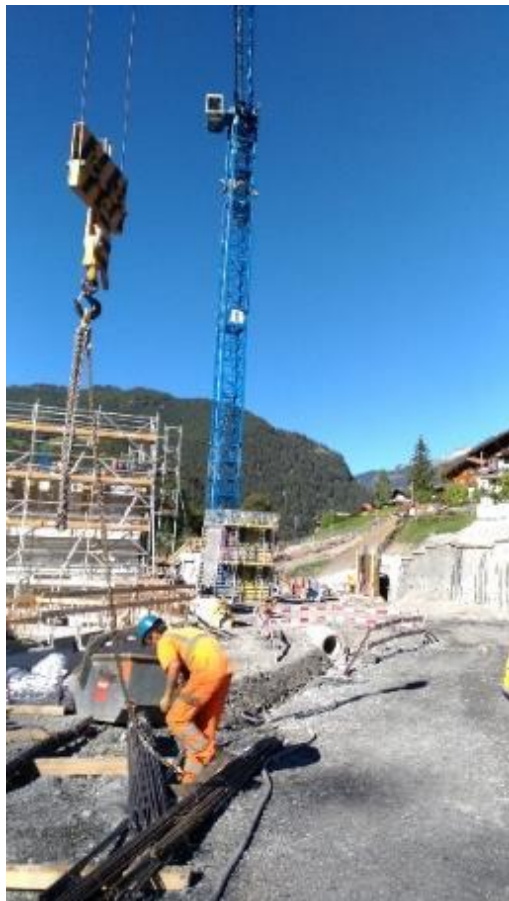
鉄筋束の玉掛け状況
