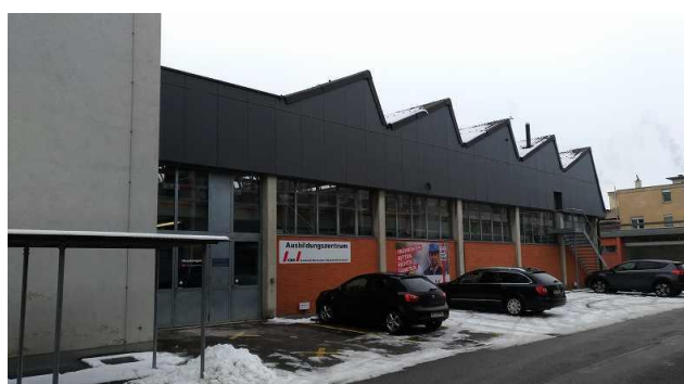
Thun 建設教育・研修・訓練センター：研修棟
