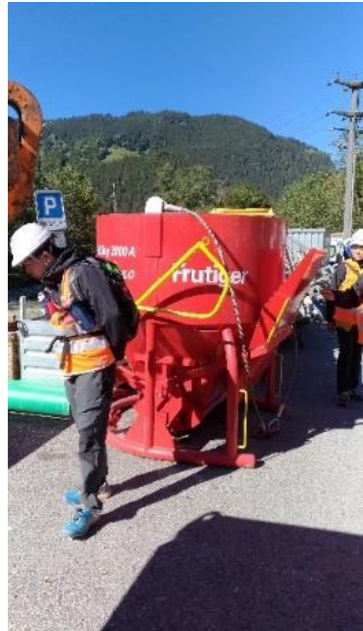
コンクリートバケット
