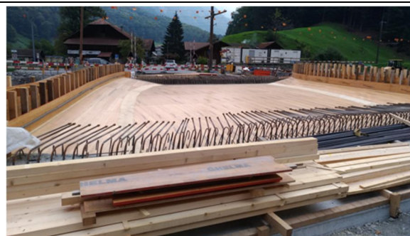
橋梁部分: 在来工法による曲面型枠
