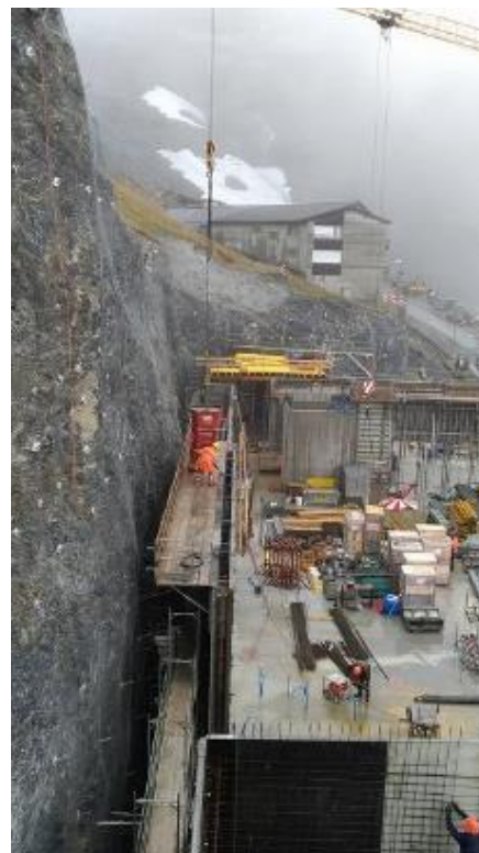
バケットによる建屋のコンクリート打設
