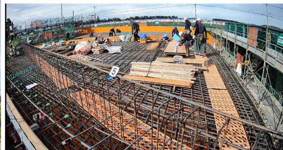
頂部施工状況
