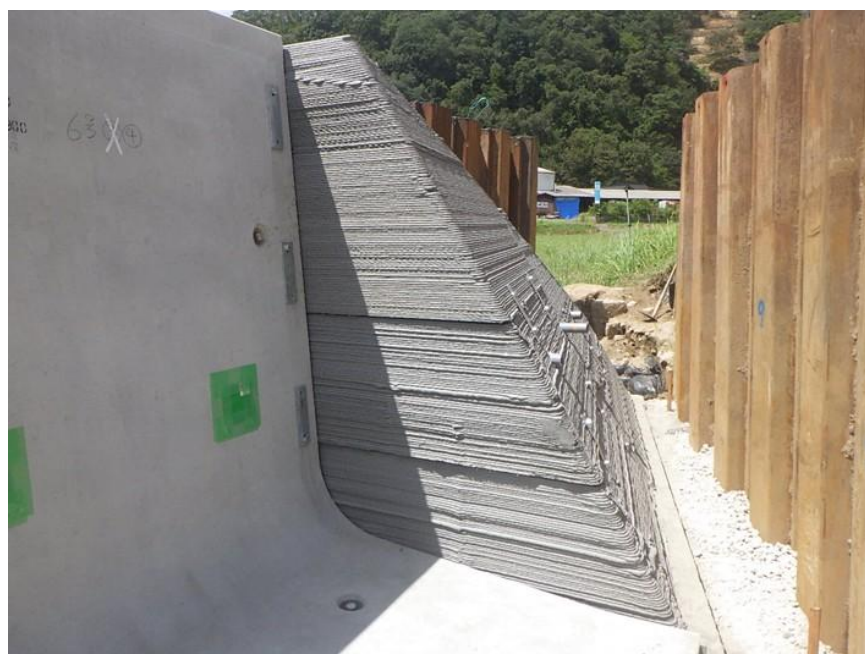
図 4-41 造形物の設置完了の状況（埋め戻し前）（加藤組提供資料）
