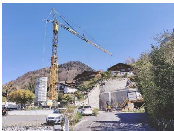
事例 3：現場全景
