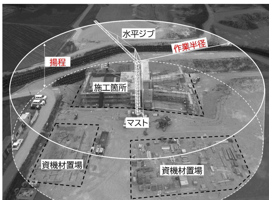
図 4-23 作業半径と揚程で構築される円筒空間の例
