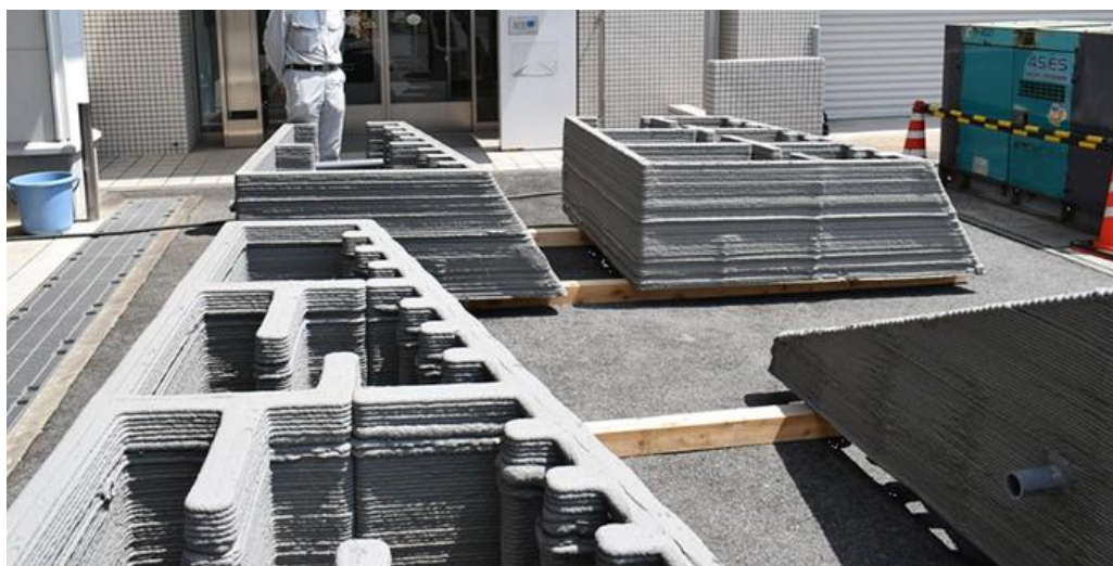
図 4-40 建設用 3D プリンタによる造形物 4.15)
