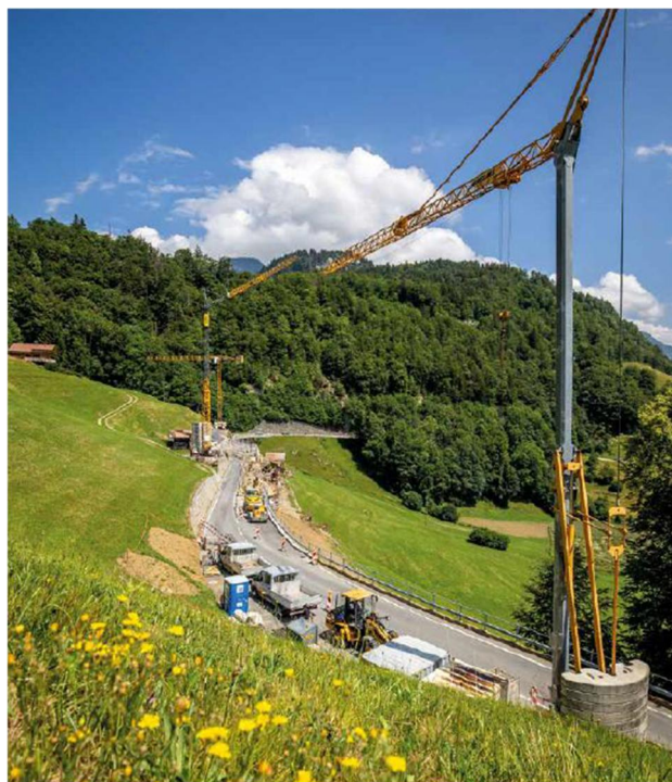
現場全景（フェーズ 2。手前より 3 号機、2 号機、1 号機）
