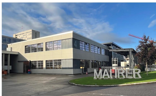
Sursee 建設教育・研修・訓練センター：外観(2024.10)
