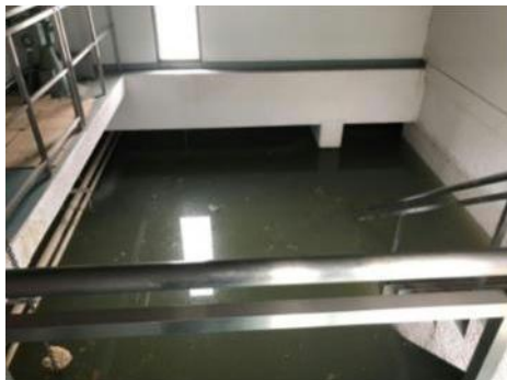
写真1-1-1 流入処理棟昇降階段
