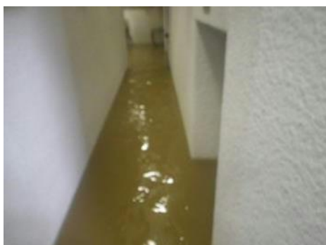
写真1-1-3 流入処理棟地下通路
