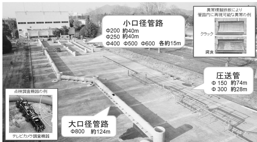
図 6 下水道管路模擬施設の外観
