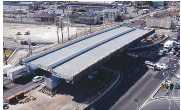
図-2-5-7-3 中央径間架設完了時
