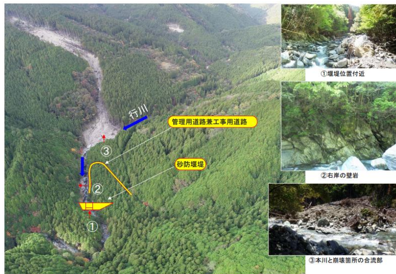
図-2-5-19-2 現地状況写真
