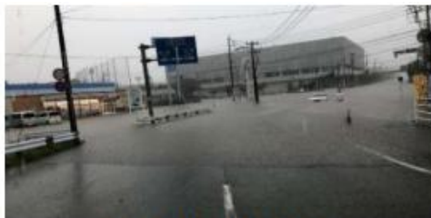
令和元年7月豪雨による浸水被害
