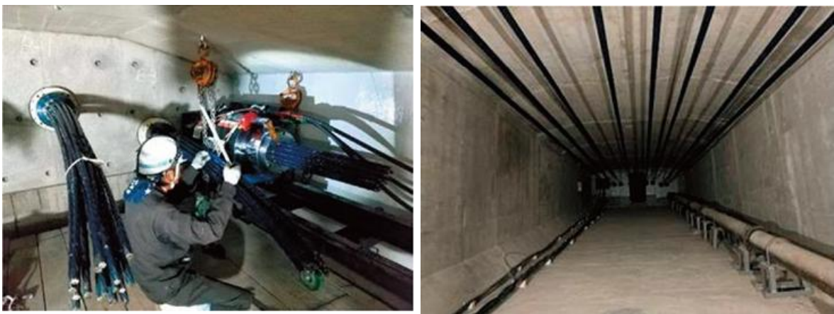
図-2-5-6-3 (左)外ケーブル施工状況 (右)外ケーブルによる補強状況
