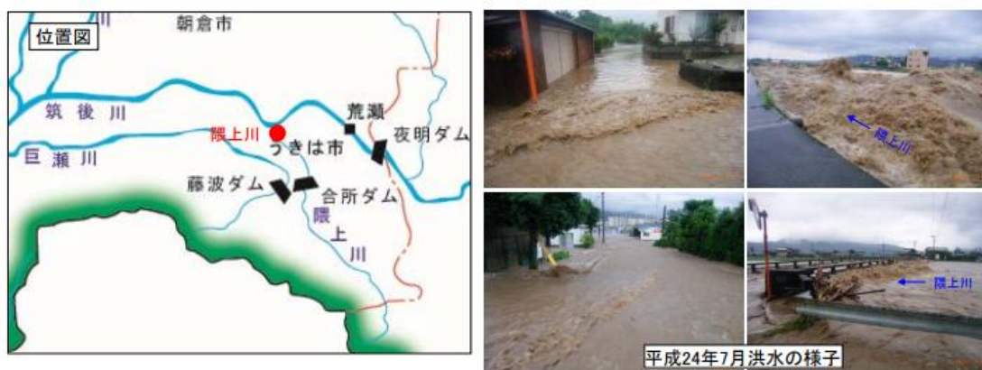
図-2-5-14-1 工事位置および改修前被害状況
