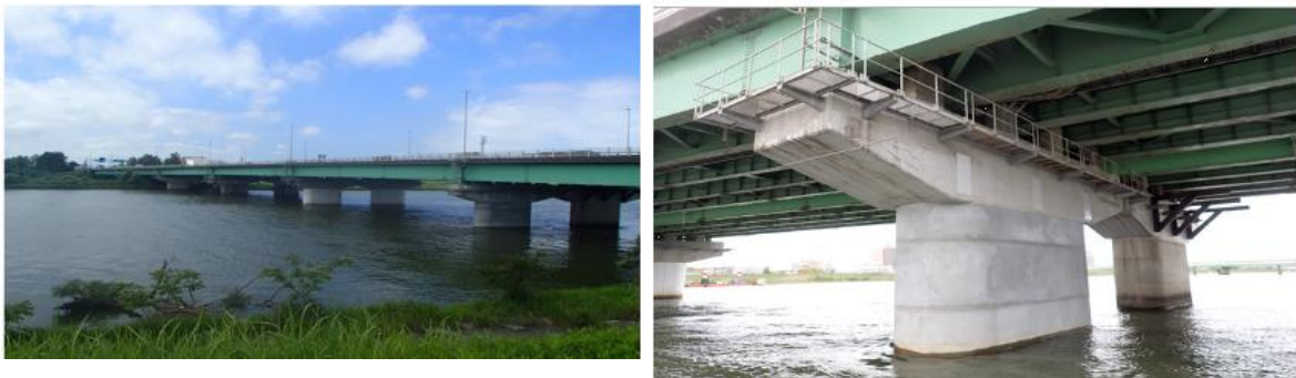
図-2-5-5-1 左:全景、右:下部工(耐震補強完了)
