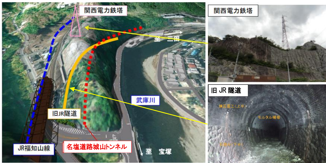
図-2-5-11-1 城山トンネル周辺状況
