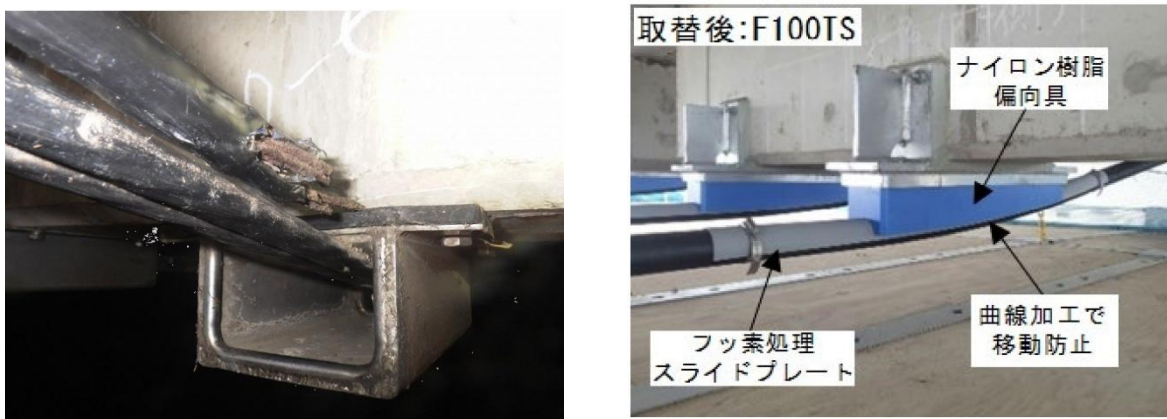
図-2-5-4-3 ケーブル取付状況(左:取替前、右:取替後)
