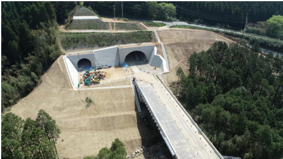
図-2-5-10-1 施工状況(坑口)
