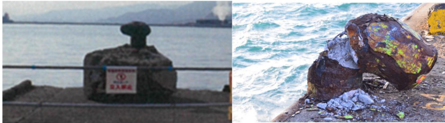
起重機船による係船柱の引抜き事例
