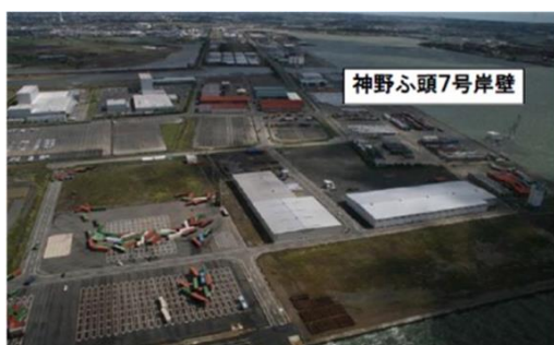
写真-A.2.1 被災状況写真 1) （三河港神野ふ頭7号及び8号岸壁）
