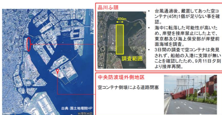
写真-A.2.10 被災状況写真 8) (東京港：中央防波堤外側地区・品川ふ頭)
