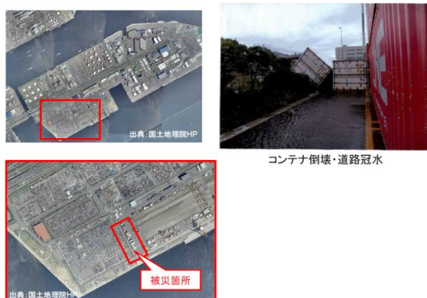
写真-A.2.9 被災状況写真 7) (川崎港・東扇島地区)
