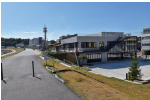
写真10 二階から堤防天端へ移動でき、左手には、川沿いに降りられる階段が設けられている。
