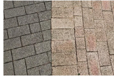
写真-3 透水・保水性舗装の例
