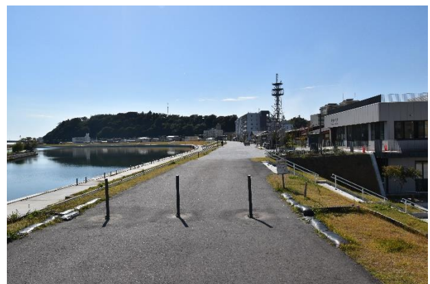
図-1 今回調査した事例の一つ。右手の商業施設は、景観ガイドラインに沿った色が採用されていると思われる（石巻かわまちづくり（宮城県石巻市））。
