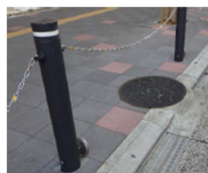
写真-2 着脱可能なチェーン付きボラード
