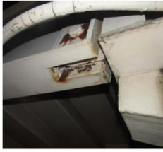
図-2(a) フック構造の例
