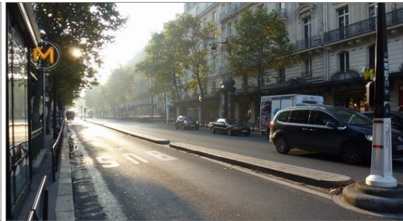
⑬一方通行道路のバスレーンと一般車線を区分する分離帯の設置 (パリ市内, フランス)
