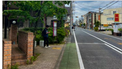
⑳歩道の無い路線で沿道敷地内に空間を確保した例 (江戸川区：松本弁天バス停)
