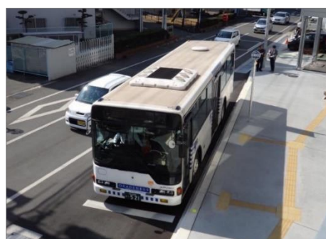
③三角形切り込み型バス停 (バリアレス縁石設置) (岡山市中区役所)
