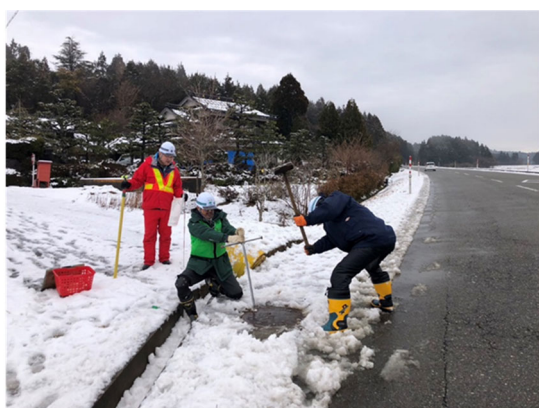
写真-10.3 マンホールの蓋を開く作業
