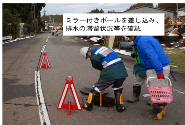
写真-10.4 排水路内の点検作業
