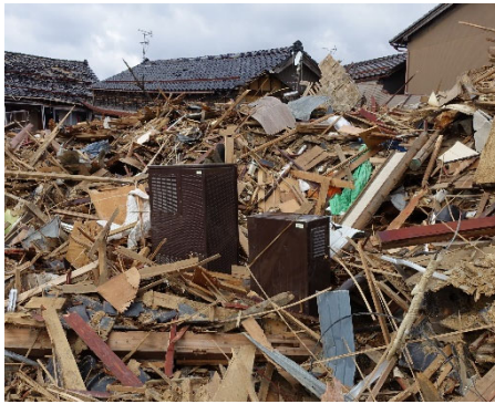
写真-9.5.9 倒壊した家屋に近接する 地上機器 穴水町大町 県道1号
