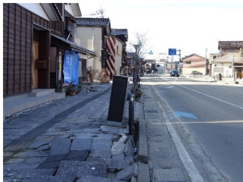
写真-9.5.1 地上機器の傾斜状況 輪島市河井町 県道1号
