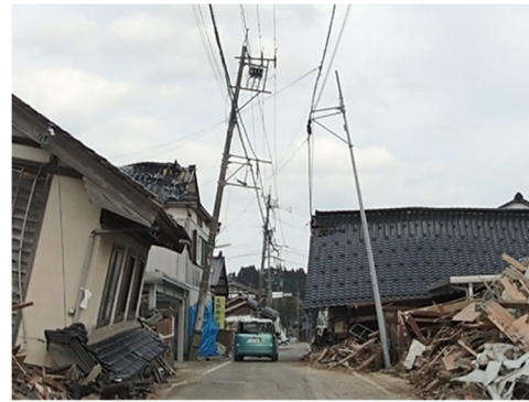
写真-9.5.10 倒壊した家屋に近接する 電柱 珠洲市上戸町内
