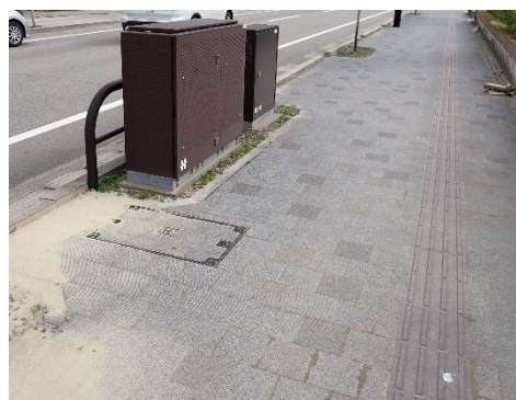
写真-9.5.8 舗装の破損がない無電柱化路線（液状化の痕跡を確認） 七尾市和倉町 県道248号
