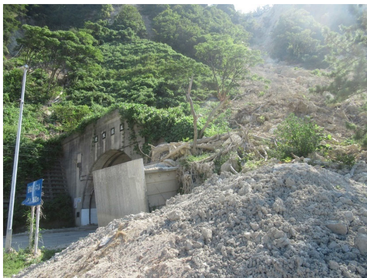
(a) 斜面の崩落の状況
