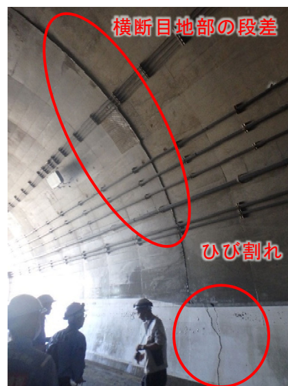
(b) トンネル内部の状況
