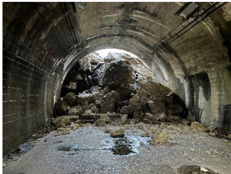
写真-9.4.19 宇出津第3隧道の坑口部の状況
