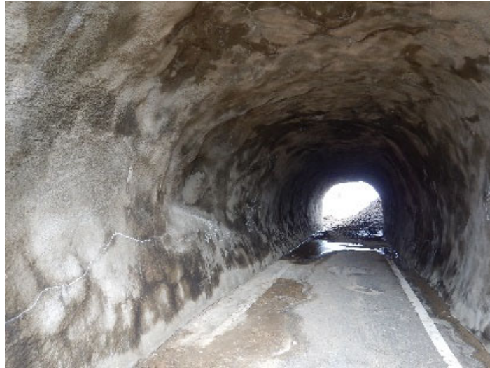
写真-9.4.17 木の葉トンネルの状況
