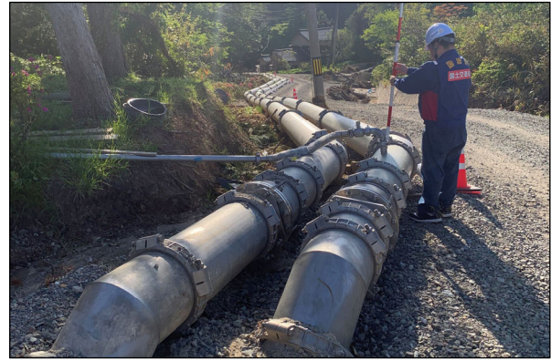
写真-1.3 能登上下水道復興支援室による露出配管（送水管・配水管、下水管）の応急復旧状況調査
