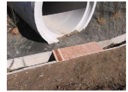
坑口前面の蓋の設置状況→
