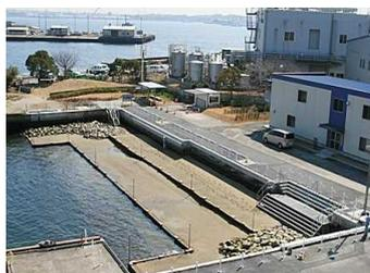
\*\*老朽化した岸壁を改修する際に、用途を変更し、耐震性を向上させると共に生物の生息場を造った例
