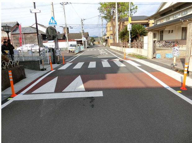
追加設置したスムーズ横断歩道（単路部）
