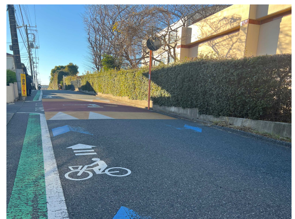
路側帯のカラー化、自転車通行空間整備
