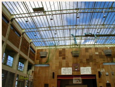
金属屋根(平成15年台風第14号)
