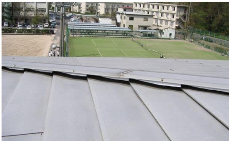
解図3.2.3 ドリルねじの緩みや外れによって下り棟部材が浮いた状況の例
