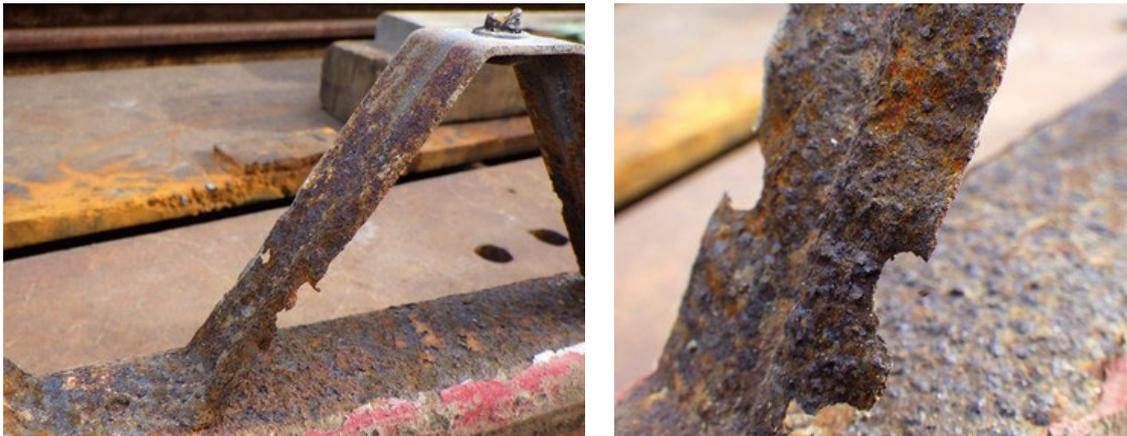
解図 3.2.4 タイトフレームの断面欠損の状況の例
