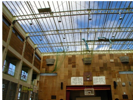
(b) 金属屋根（平成 15 年台風第 14 号）
