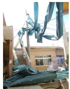
(b) 金属屋根（平成 15 年台風第 14 号）
