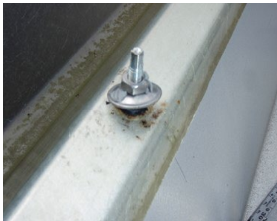
(b) ボルト・ナットの緩み
