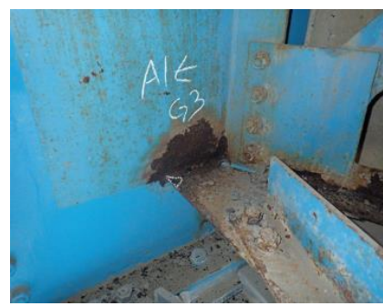
主桁、下横構ガセットの腐食
