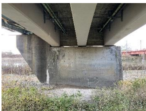
周辺地盤の外観
