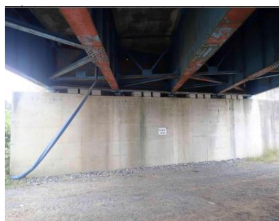
A2橋台の外観
