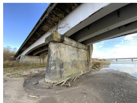
周辺地盤の外観
