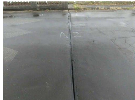
伸縮装置の外観
