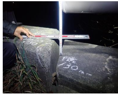
沈下・移動・傾斜
