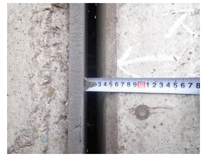
沈下・移動・傾斜
