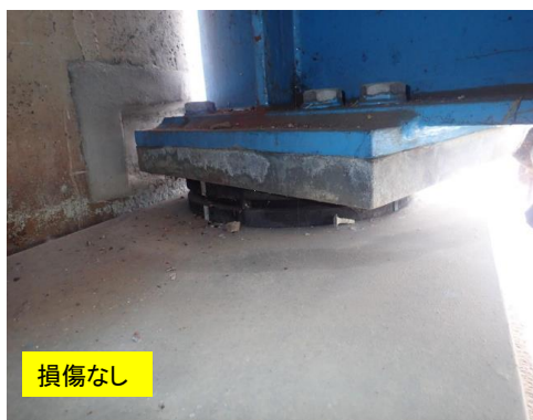
A1橋台支承
