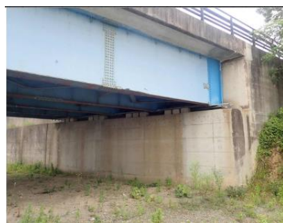
A1橋台の外観
