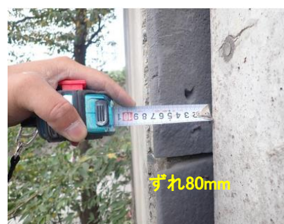
A2橋台ウイングと背面のボックスカルバートとの段差、ずれ
