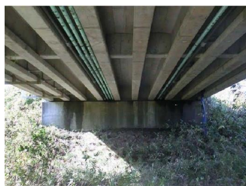
橋台・周辺地盤の外観
