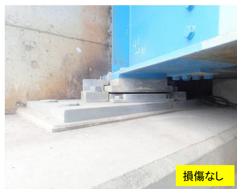
A2橋台支承
