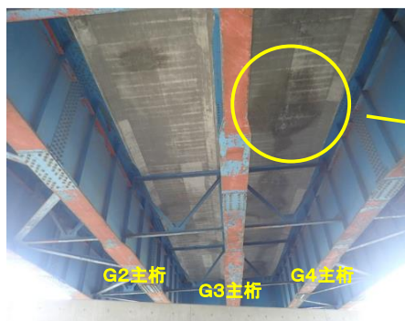
床版ひびわれ、漏水・遊離石灰
