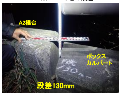
A2橋台ウイングと背面のボックスカルバートとの段差、ずれ
