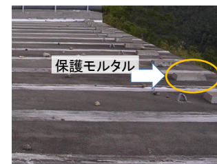
PC製シェッドの頂版上面 (主梁-柱接合用のPC鋼材上端)
