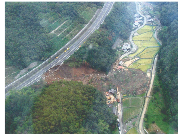
平成17年9月7日 山陽道盛土崩壊
