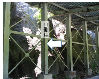
鋼製シェッドの山側柱(H形鋼)
