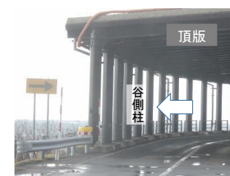
鋼製シェッドの谷側柱(鋼管)
