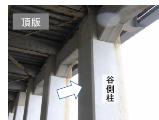
鋼製シェッドの谷側柱 (RC製ラーメン)
