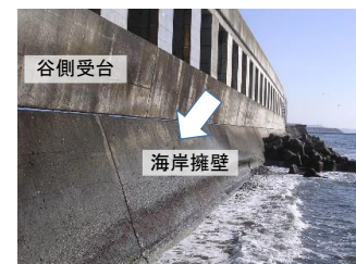
谷側基礎部が海岸擁壁の例
