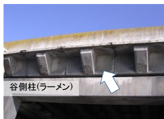
PC製シェッドの主梁谷側端部
