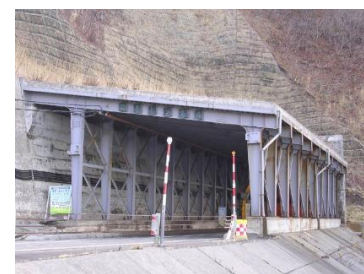
鋼製スノーシェッドの例
