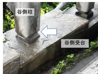
PC製シェッドの谷側柱基部
