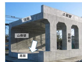
RC製箱形式ロックシェッド底版 (衝撃実験用供試体の全景)
