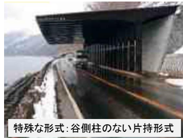
鋼製片持形式スノーシェッドの例
