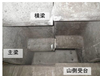
PC製シェッドの山側受台支承部
