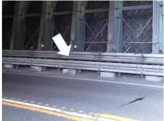
車両用防護柵(山側)
