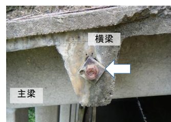
PC製シェッドの主梁横締め箇所
