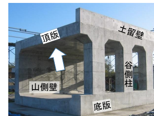
RC製箱形式ロックシェッド頂版 (衝撃実験用供試体の全景)
