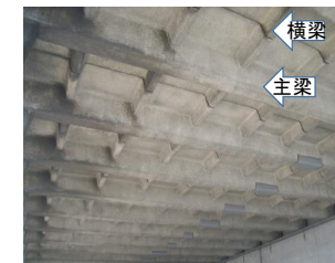
PC製ロックシェッドの頂版下面 (主梁+横梁)
