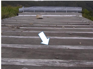
PC製スノーシェットの 頂版上面の主梁間防水シート
