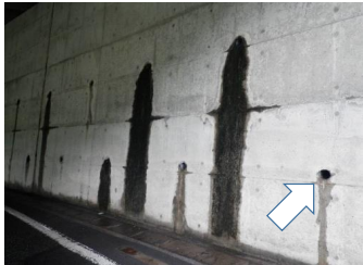
山側壁の排水孔
