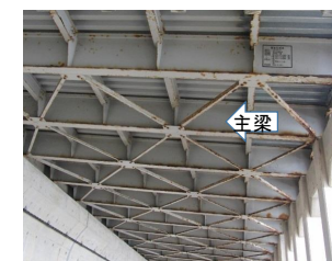
鋼製ロックシェッドの頂版下面 (デッキプレート+主梁・横梁・ブレース)
