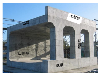
RC製箱形式ロックシェッド土留壁 (衝撃実験用供試体の全景)
