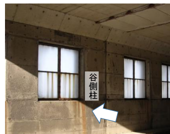
RC製シェッドの谷側柱(窓タイプ)
