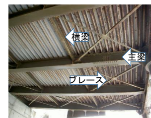
鋼製スノーシェッドの頂版下面 (デッキプレート+主梁・横梁・ブレース)
