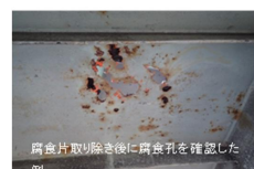
腐食片を取り除いた状態の例(床版)
