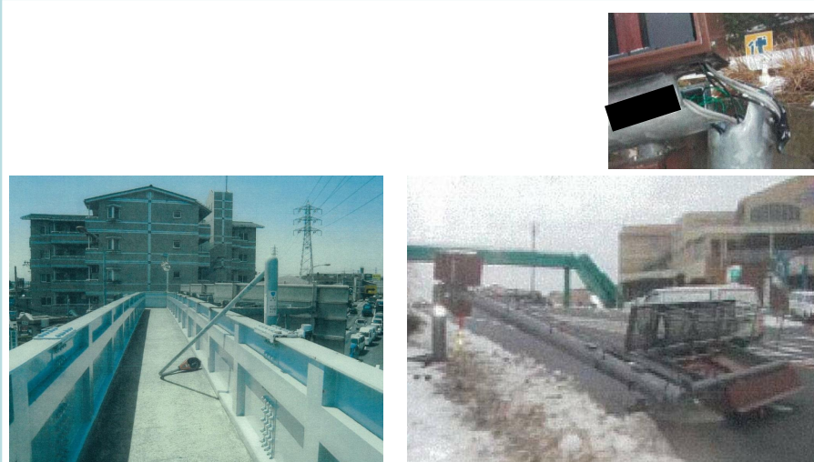
照明柱の倒壊
