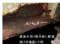
腐食片を取り除いた状態の例(主桁)
