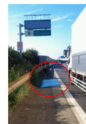
識板補修用の重ね貼り シートの落下事例
