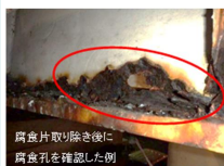
腐食片を取り除いた状態の例(主桁)
