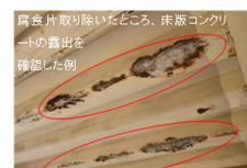
腐食片を取り除いた状態の例(床版)
