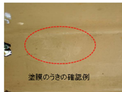
塗装片を取り除いた状態の例(床版)
