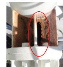
固着した腐食片を取り除いた状態の例
