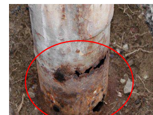
腐食片や塗装片を取り除いた状態の例
