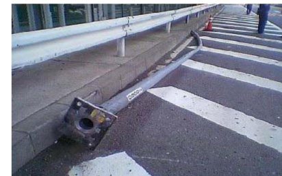
車両の衝突により照明柱基部のアンカーボルトが破断し、倒壊した例
