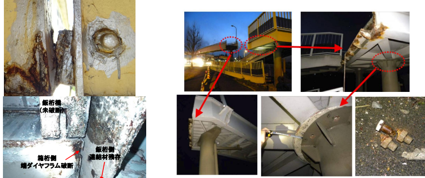
地震により上部構造と下部構造を接続していたボルトが破断し、ズレや桁が落下。
