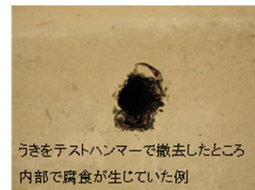
塗装片を取り除いた状態の例(床版)
