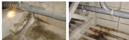
導排水管路からの漏水によって、特定の場所に対象の滞水が生じて、他部材の損傷につながることもある。
