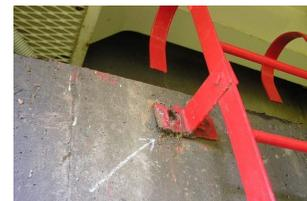
取り付け部のボルト脱落
