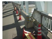
防護柵に著しい変形・欠損が生じ、緊急対応した例。防護柵の損傷や欠落に対しては、交通安全の観点から速やかに機能を回復させる必要がある。
