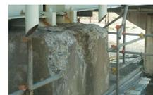
排水管からの水の影響によると考えられるコンクリート欠損
