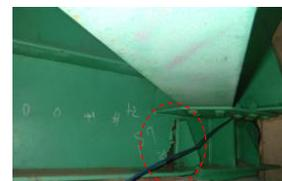
塗装の剥がれが見られ、他の損傷もあることが疑われる例
