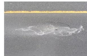
遊離石灰を伴う舗装の陥没
