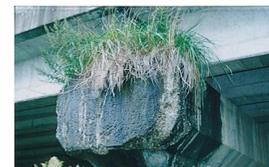
橋座面に土砂が堆積
