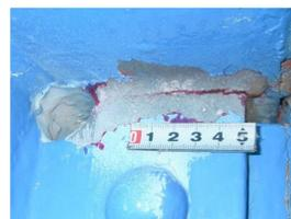
・近接目視だけでは、塗膜われと亀裂の区別がつかず、正確な状況が把握できない場合がある。
