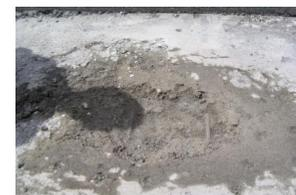
床版上面の土砂化
