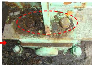
ボルトの破断(震災後)
