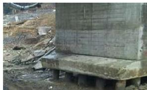
津波後に発見された損傷
