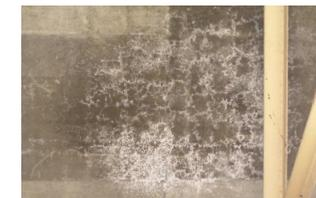
床版下面のひびわれと遊離石灰の滲出
