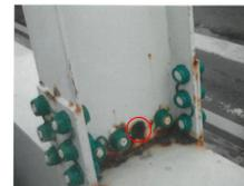
高力ボルトが抜け落ちている例
