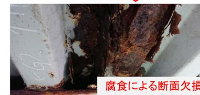
腐食による断面欠損
