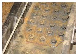
箱桁内部などの部材内部に、滞水が生じている状態
