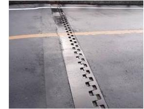
鋼製ジョイントの例(荷重支持型)
