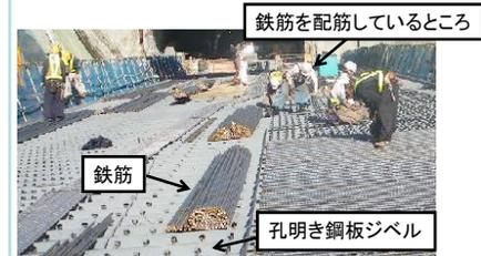
孔明き鋼板ジベルを用いた合成床版の例(配筋中)
