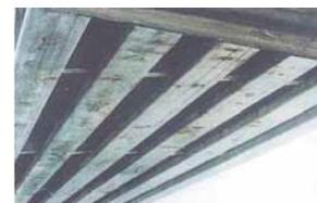
主桁下面にひびわれ、錆汁発生: 1980年(15年経過)
