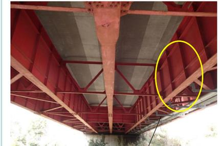
➢「補剛材」で板がはらむのを防止するとともに、板を細かく分割することで、座屈しにくく、また座屈しても区切られた範囲だけでとどまるようにしている。
