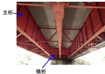
→計算上は上げたとして棒でモデル化し、ひとつひとつの補剛材はモデル化しない
