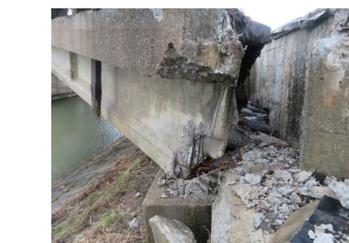
コンクリート橋の桁端部が地震によって損傷した例
