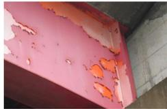
塗装の一部に劣化が見られ、今後、着実に防食機能の劣化が進展する可能性は高いと考えられ、鋼桁が腐食に至る可能性がある。
