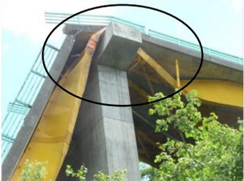
主桁が鉛直荷重に抵抗できずに中間支点部で横倒れ座屈が生じた。
