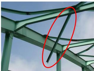
水平荷重の作用する向きや、横構の配置によって、各横構に作用する軸力は引張り力または圧縮力のどちらも作用する可能性がある。そのため、引張り力による破断も、圧縮力による座屈も生じる可能性がある。
