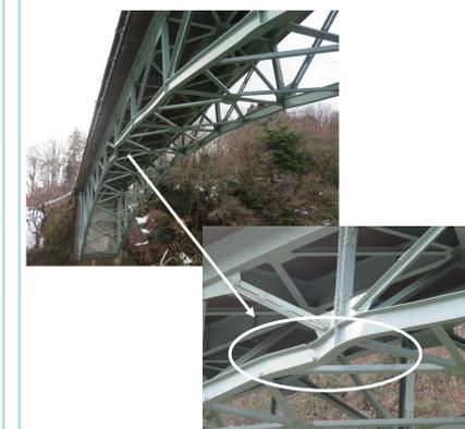
トラス構造やアーチ構造は、個々の部材が協働して荷重を伝達する構造である。性能の推定を行う際には、個々の部材に対して性能を評価するだけでなく、構造の全体系としての評価を行う必要がある。
