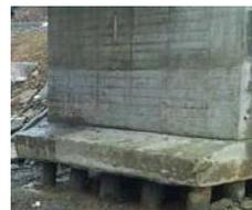
基礎周辺地盤が洗掘されると、基礎の鉛直・水平支持力が低下する
