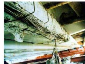
主桁PC鋼材の破断: 1991年(26年経過)
