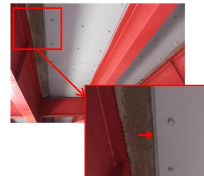
鋼板接着補強は、**鋼板端部でシール材処理**がされている
