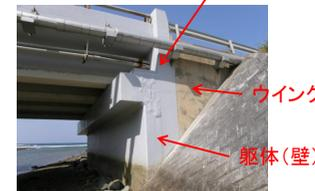
橋梁の端部に配置されるもので、上部構造からの荷重の基礎への伝達する。背面土の土留めとしても働く。
