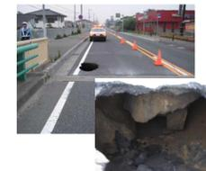
護岸又は基礎洗掘部から橋台背面土が吸い出されると、橋台アプローチ部の踏み抜き、橋台の沈下、傾斜が懸念される
