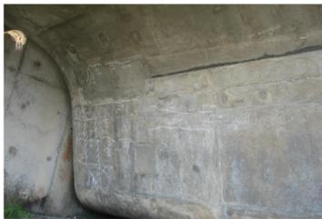
PC鋼材の定着部付近には、引張応力が生じており、集中荷重に対する補強が十分でない場合にひび割れが生じる場合がある。
