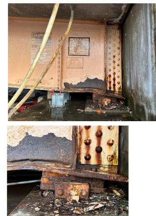
支承に荷重を伝える桁端部が著しく腐食している事例
