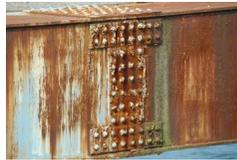
鋼桁の広い範囲で腐食が見られ、既に防食機能のほとんどが喪失している状態である。
