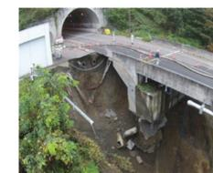
深礎基礎の周辺地盤が喪失し、鉛直・水平外力に対して基礎が不安定化することが懸念される
