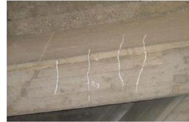
鉛直荷重による曲げモーメントに対して、支間中央部で、橋軸直角方向のひびわれが生じた事例。
