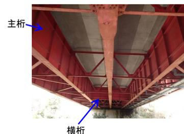
→計算上は、自動車荷重に対して、主桁や横桁が抵抗すると仮定する場合も多いが。。。
