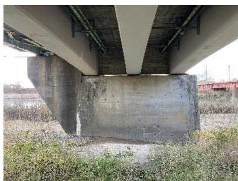
周辺地盤の外観
