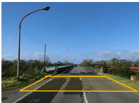
橋台背面アプローチ部の外観
