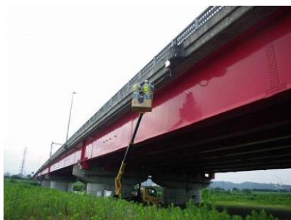
高所作業車による定期点検
