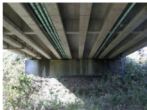
橋台・周辺地盤の外観
