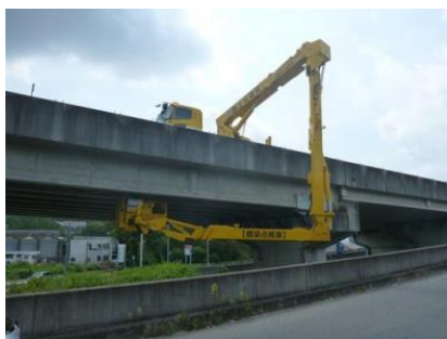
橋梁点検車による定期点検
