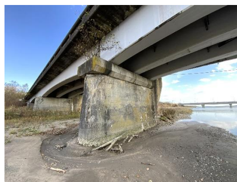
周辺地盤の外観
