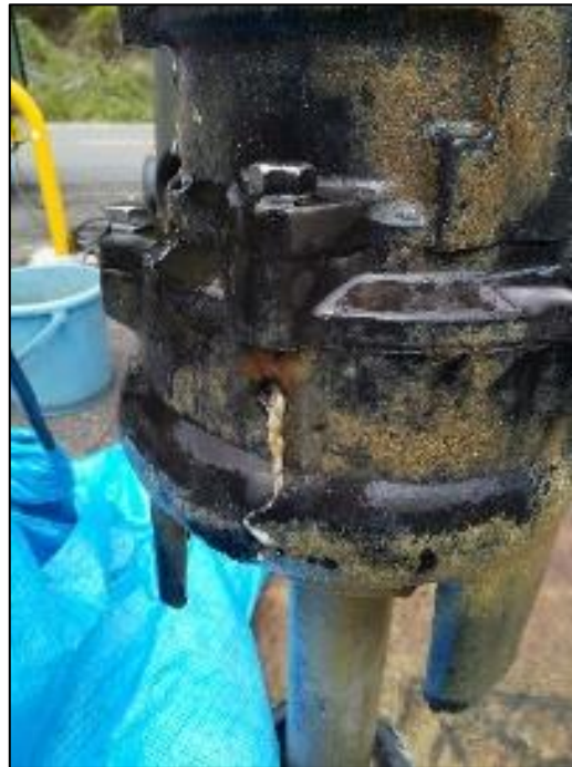
エアロック※：空気孔のし渣詰まり
