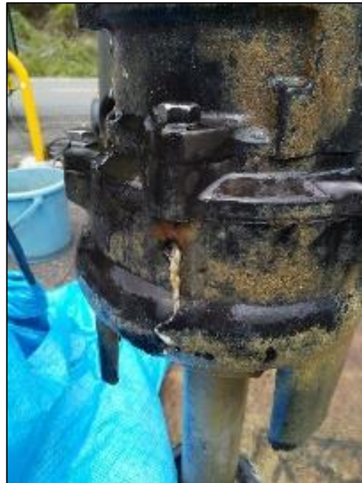
エアロック※：空気孔のし渣詰まり
