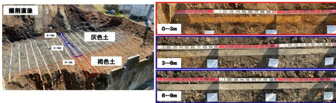
図- 2.3.10.13 現場調査測点(左)、補強材腐食状況(右)
