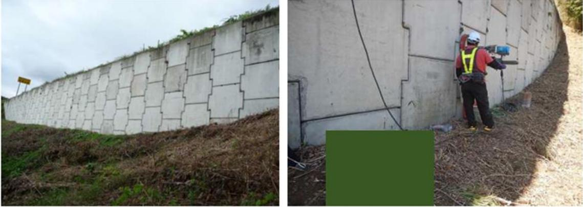
図-2.3.10.3 調査した補強土壁の一例（山梨、竣工後49年経過）
