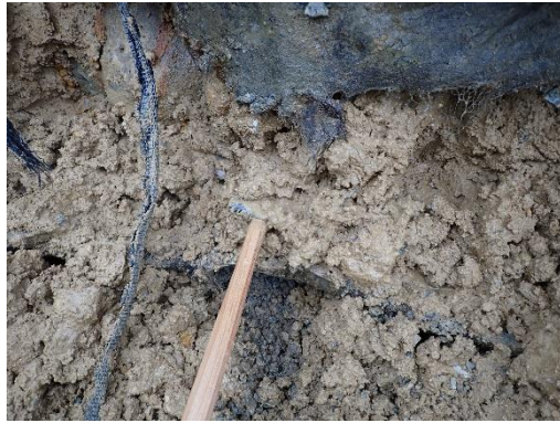
図- 2.3.1.38 下部の盛土材の状態
