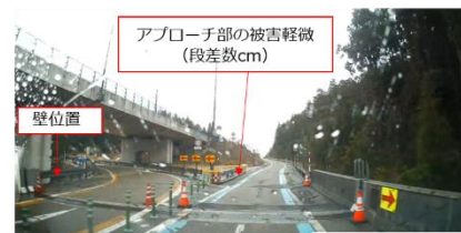
方向① 橋台部路面
