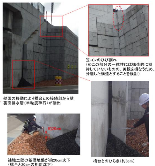
図-2.3.1.25 事例：ジ6の変状概要図
