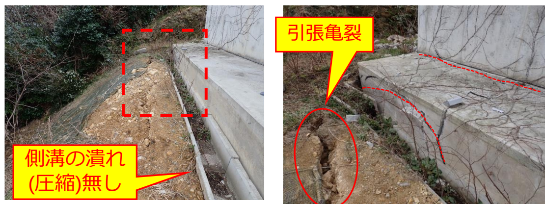
(a) A1 橋台前面の状況（遠景）
