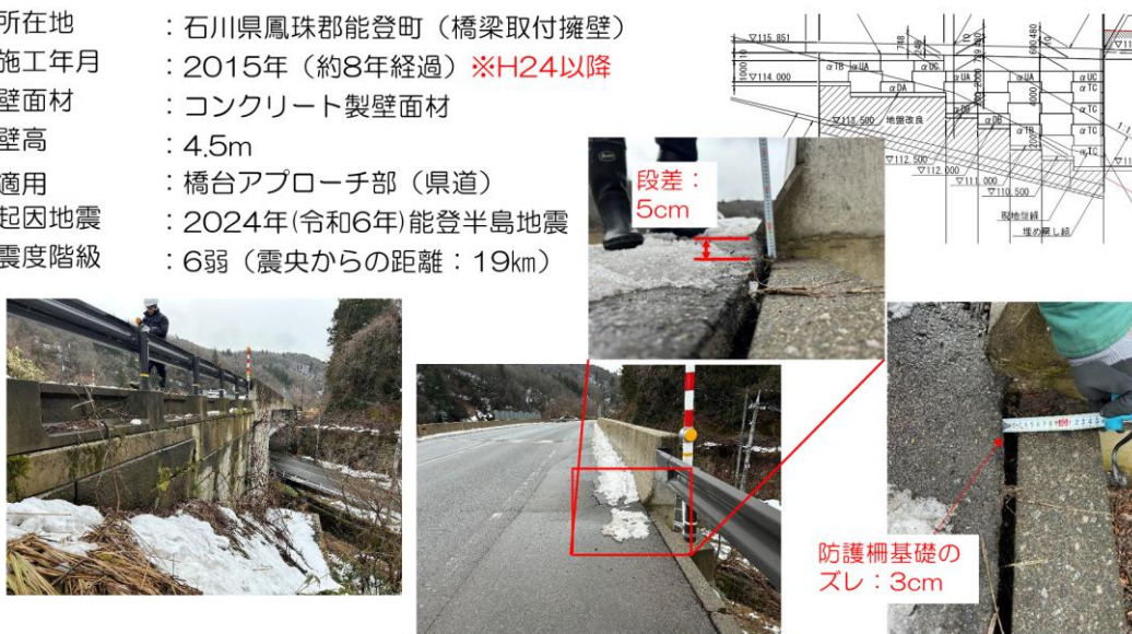
図- 2.3.1.17 事例：タ 6 の変状概要図
