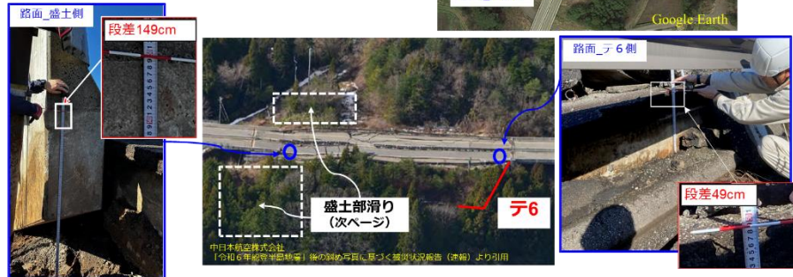
図-2.3.1.11 事例：テ6の段差発生状況
