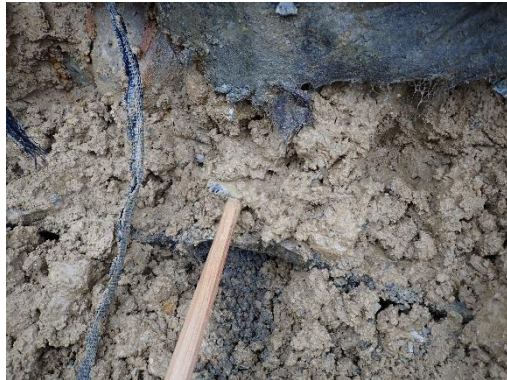
図- 2.3.1.38 下部の盛土材の状態
