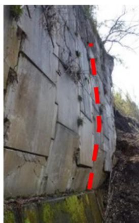
(a)撤去・再構築の事例 (平成28年熊本地震)
