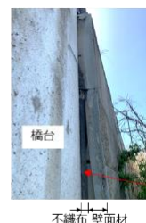
図-2.3.1.15 事例：タ 4 の変状概要図
