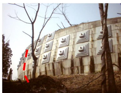
壁高:約 8\text{ m} 水平変位: 約 1\text{ m}
