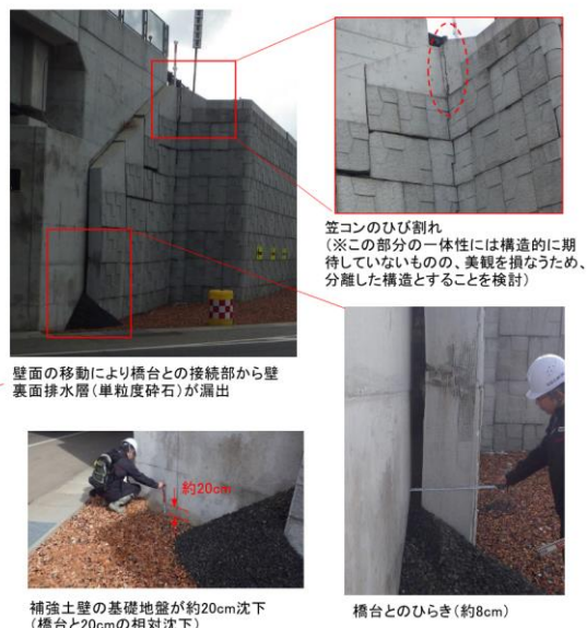
図-2.3.1.25 事例：ジ6の変状概要図
