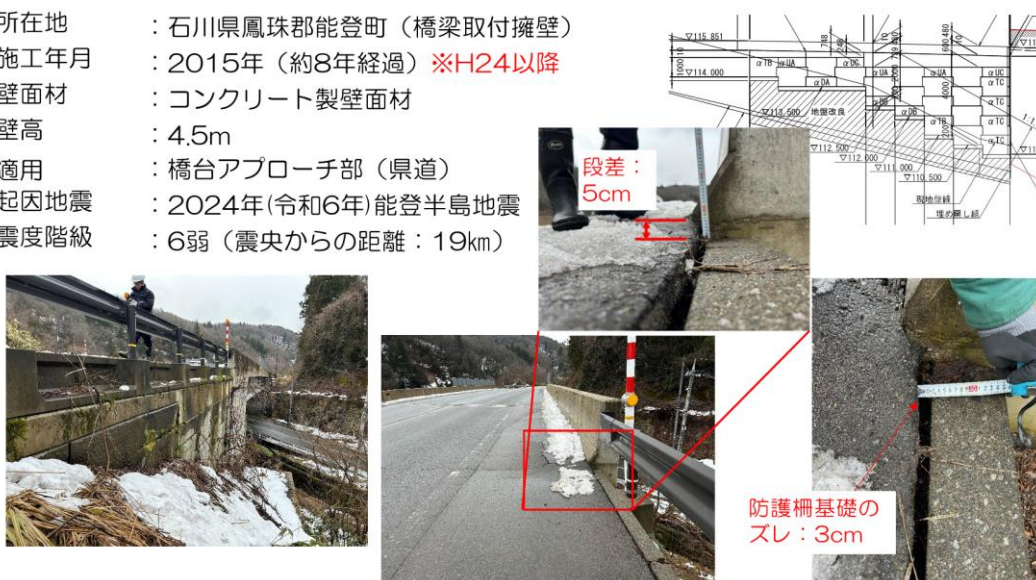
図- 2.3.1.17 事例：タ 6 の変状概要図
