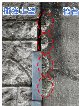
(a) 橋台端部端部の Co の欠損
