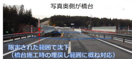
▽アプローチ部の施工順序 (google ストリートビュー) 2017.8 2021.7 盛土部先行で施工
