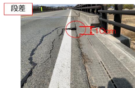
図-2.3.1.13 事例：タ2の変状概要図
