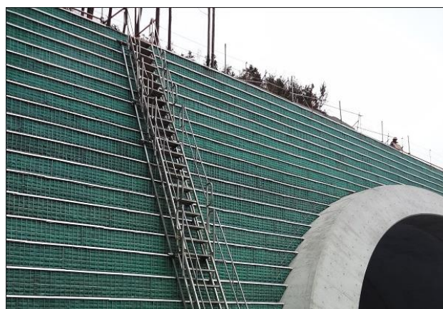
参写真-2 壁面に点検用階段を設置した事例
