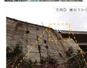
方向③ 橋台部拡大 橋台に損傷はないが、 差しい沈下は生じていない
