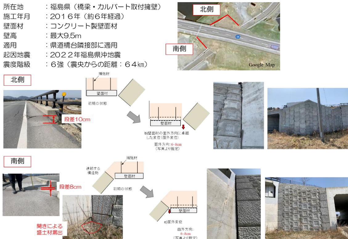
図- 2.3.1.14 事例：タ 3 の変状概要図
