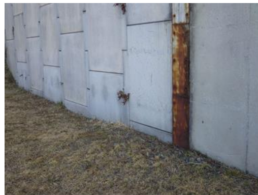
(b) 下部のクローズアップ（漏出無し）
