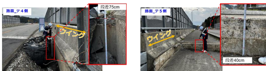
図- 2.3.1.9 事例：テ4、テ5 の段差発生状況
