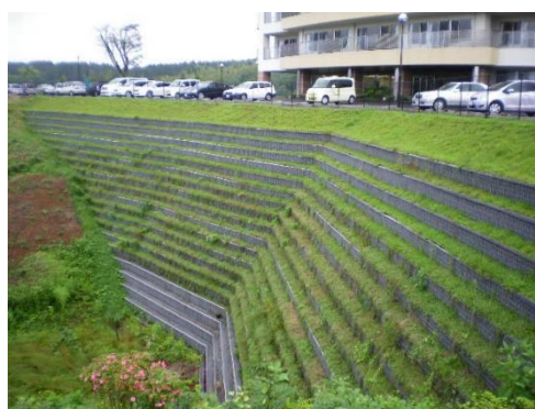
参写真-1 壁面に小段を設置した例
