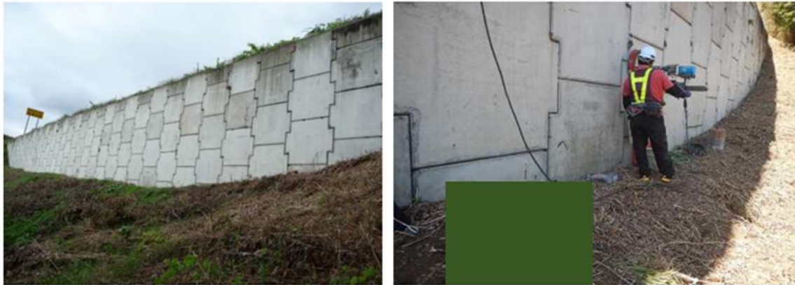
図-2.3.10.3 調査した補強土壁の一例（山梨、竣工後 49 年経過）
