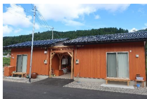
木造・ふるさと回帰型（穴水町内）
