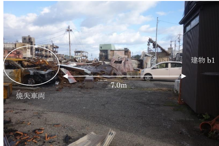
写真 6.2.2-3 建物 b1 の外周の状況：西面（外壁面と焼けた車両）
