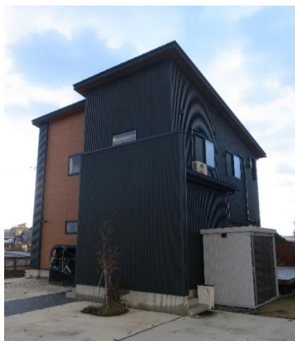
(ア) 南東側から見た建物全景
