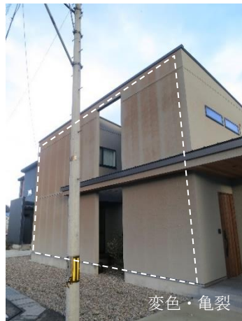
(ア) 南東側から見た建物全景
