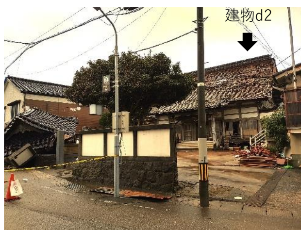
写真 6.2.2-8 建物 d2 北側道路前の樹木の状況
