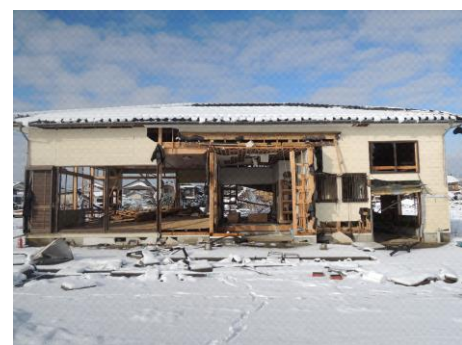
写真 5.7-16 津波による前面の被害
