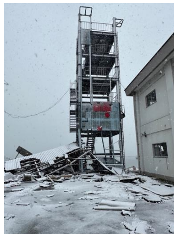
写真 5.7-21 津波避難施設の外觀(陸側からの撮影)
