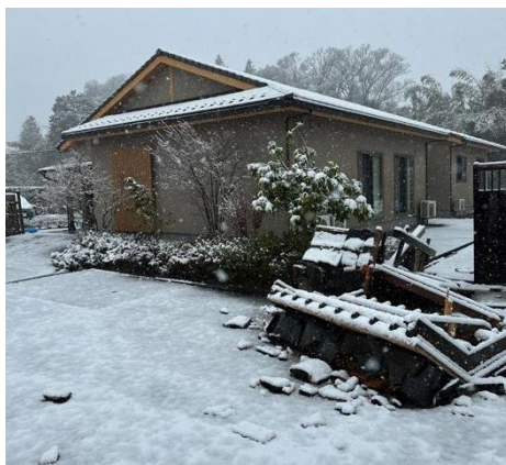
写真 5.7-39 住宅に隣接した門の倒壊
