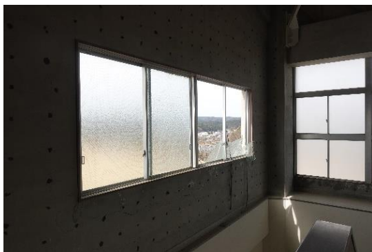
写真 5.6.2(4)-1 屋内運動場 引き違い窓のガラスの破損 (AN-102：穴水町、教育施設)
