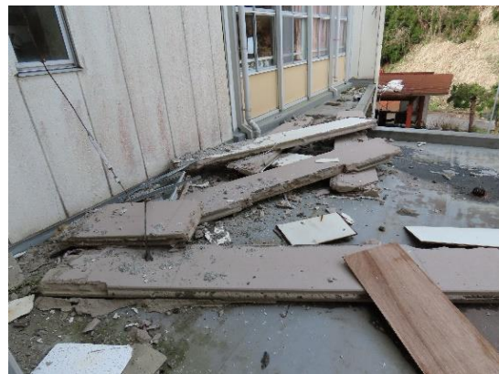
写真 5.6.2.(3)-2 左写真の外壁から落下した ALC パネル (WA-111：輪島市、教育施設)
