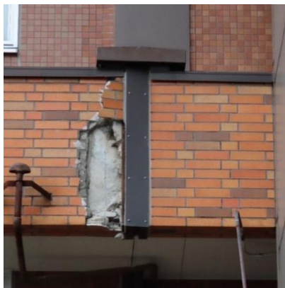
写真 5.6.2.(5)-1 Exp.J 近傍の外装材の剥離および落下 (建築物 A：金沢市、行政庁舎)
