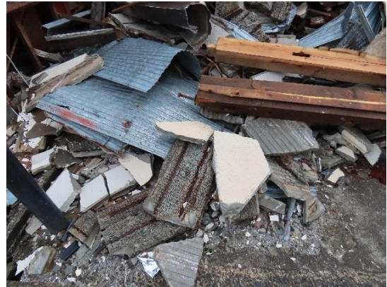
写真 5.6.2. (3)-16 左写真の施設から脱落した外壁 (AN-01: 穴水町、店舗兼事務所。写真 5.5-112 を再掲)
