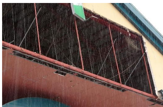
写真 5.6.2.(3)-7 ALC パネルによる外壁の脱落 (WA-14：輪島市、商業施設)
