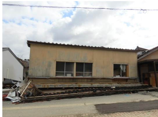
写真 5.5-16 1 階の層崩壊
