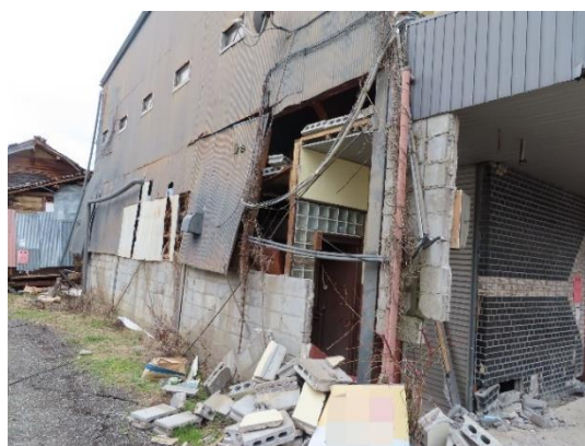
写真 5.5-34 建築物全体の大きな変形及び外壁脱落
