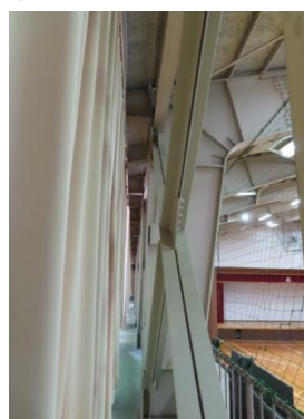
写真 5.5-140 第一体育館 山形鋼ブレース （2 丁合わせ）の面外たわみ
