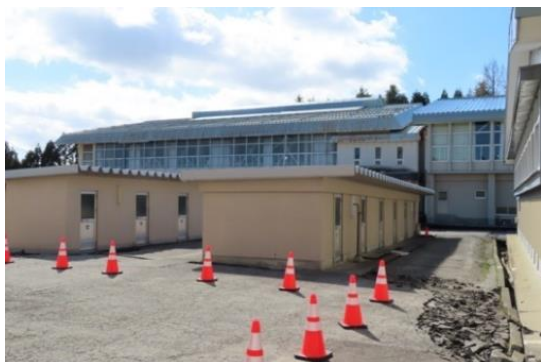
写真 5. 5-143 第二体育館 外観
