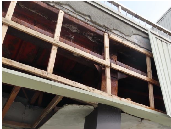
写真 5.5-13 2 階柱頭部の梁端部接合部
