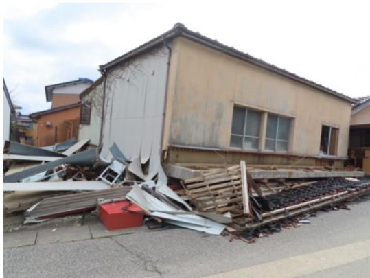
写真 5.5-15 1 階の層崩壊
