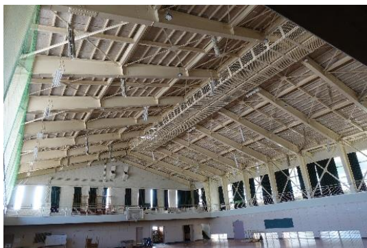
写真 5. 5-144 第二体育館 内観
