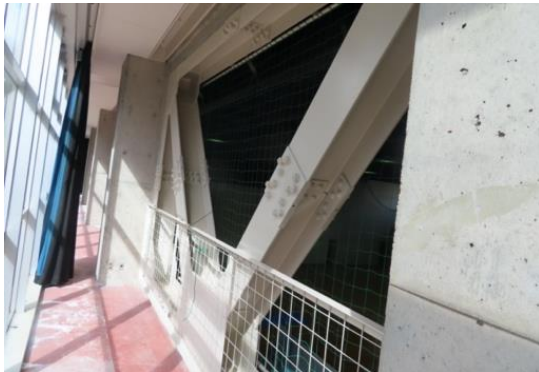
写真 5.5-119 枠付き H 形鋼ブレースフレームによる耐震補強
