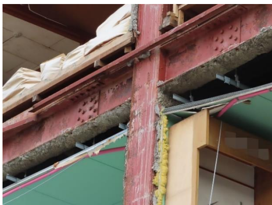
写真 5.5-104 日の字断面柱梁接合部
