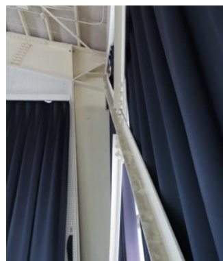
写真 5. 5-148 第二体育館 山形鋼ブレ ース (1 丁)
