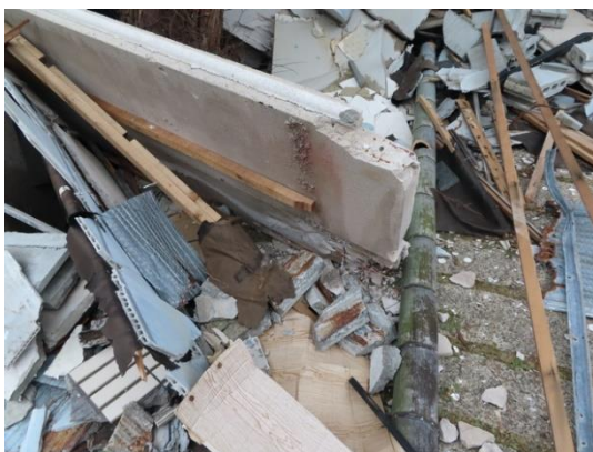
写真 5.5-105 ALC 外壁の脱落
