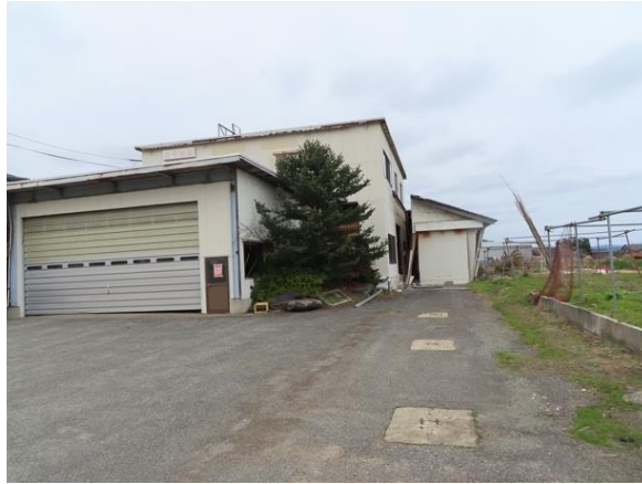
写真 5.5-69 外観（木造下屋部分の分離）
