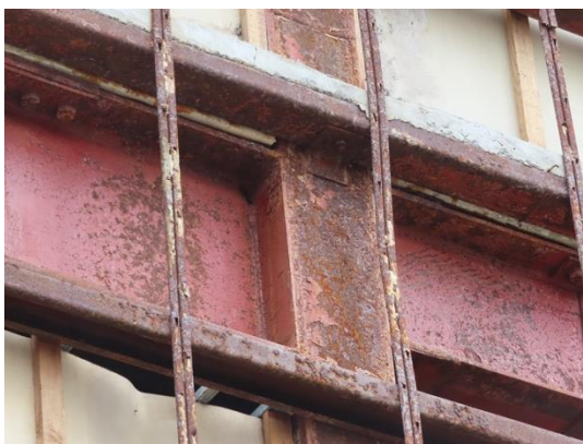
写真 5.5-116 柱梁接合部の部材等
