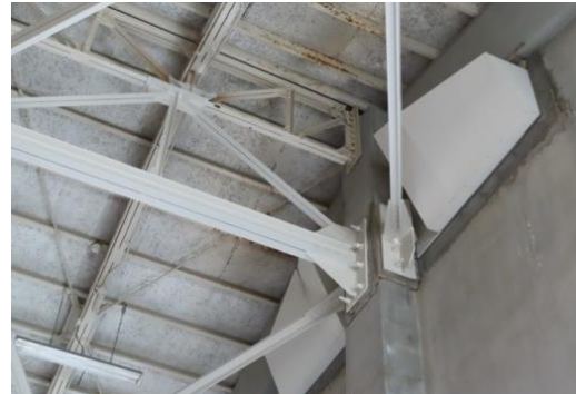
写真 5.5-135 妻壁（反対側）とトラス屋根接続部では損傷無し
