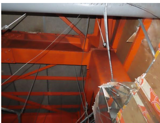
写真 5.5-99 柱、梁部材に明確な損傷無し
