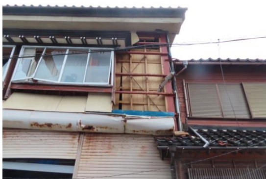
写真 5.5-22 ターンバックルブレースの状況
