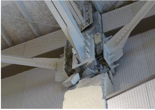
写真 5.5-130 RC 造柱のコンクリートの破壊、脱落、アンカーボルトの抜け出し
