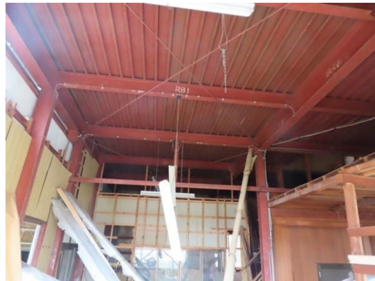
写真 5.5-71 柱梁接合部の状況
