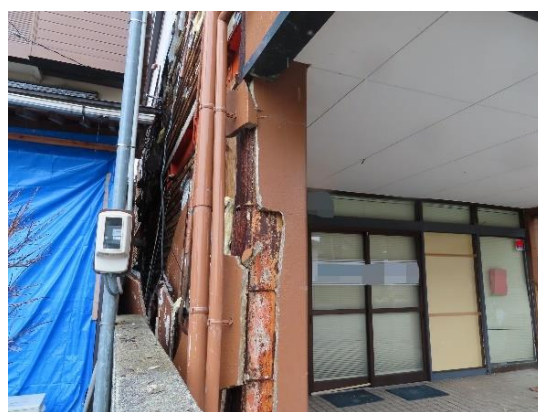
写真 5.5-48 柱は日の字断面
