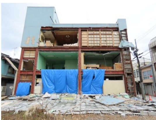
写真 5.5-103 外壁（ALC パネル、コンクリートブロック壁）の広範囲での脱落・転倒
