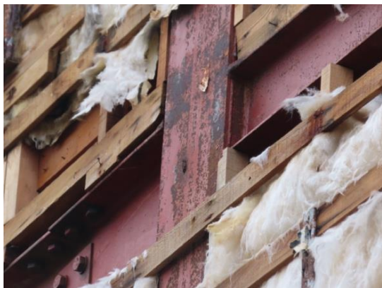
写真 5. 5-80 日の字断面柱の柱梁接合部
