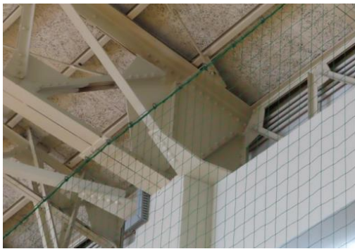
写真 5.5-134 平側の RC 造柱の柱頭とトラス梁の接続部（支承部）ではほとんど損傷無し
