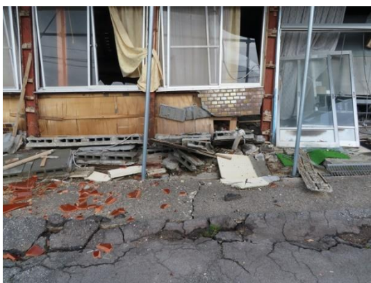
写真 5.5-32 外壁や地盤の状況
