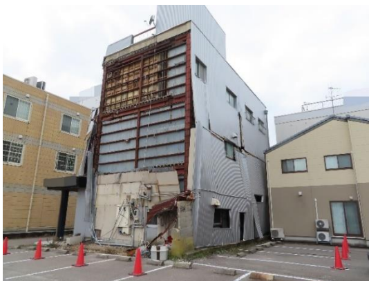
写真 5.5-101 外壁の脱落
