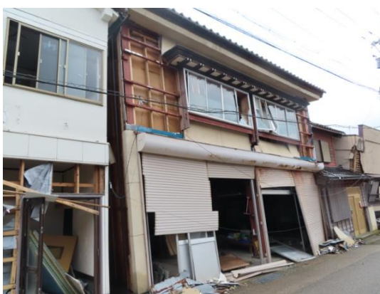
写真 5.5-23 建築物前面の外壁の脱落、シャッター破損、窓ガラス、窓枠の破損
