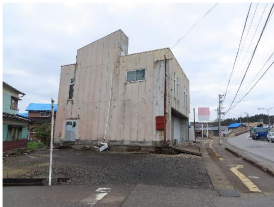
写真 5.5-72 建築物外観（側面）
