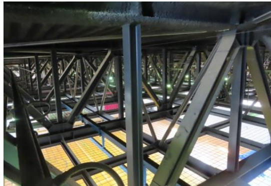
写真 5.5-120 鉄骨立体トラス梁の屋根
