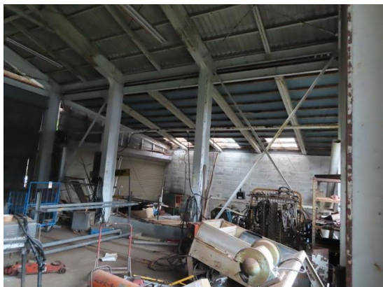
写真 5.5-94 山形ラーメンの柱梁及び山形鋼ブレースには大きな損傷は無い
