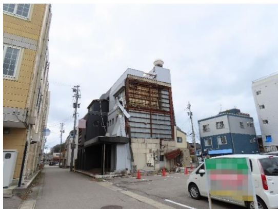
写真 5.5-100 外壁の脱落
