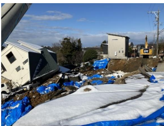
写真 5.4.2-2 崩壊した斜面の状況②
