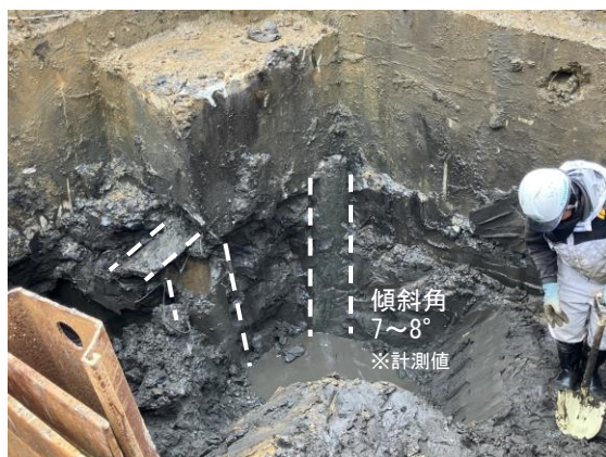
a) X2-Y3 の杭頭部（北東側①から撮影）
