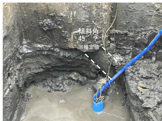
b) X2-Y4 の杭頭部（南側②から撮影）
