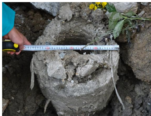
b) 杭の寸法形状の確認状況
