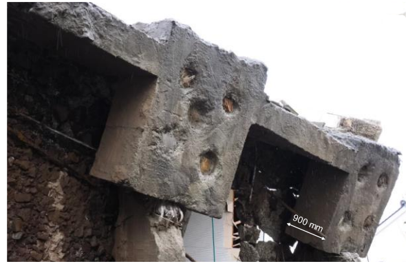
写真 5.4.2-14 パイルキャップ
