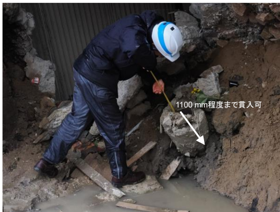
写真 5.4.2-15 露出した杭頭
