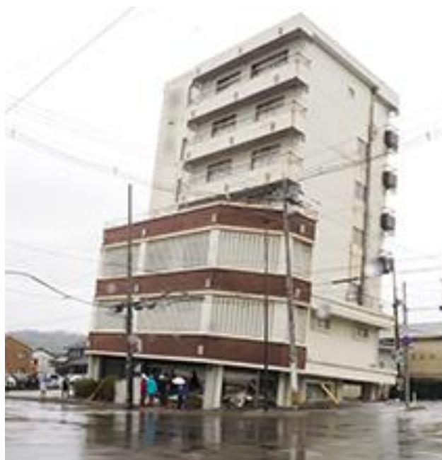
写真 5. 4. 2-20 建物全景 (南東側から撮影)
