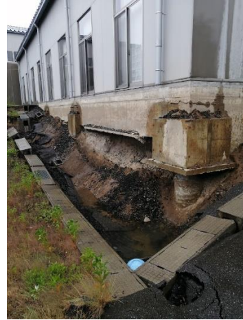
写真 5. 4. 2-44 E 中学校体育施設周囲地盤の変状に伴う被害
