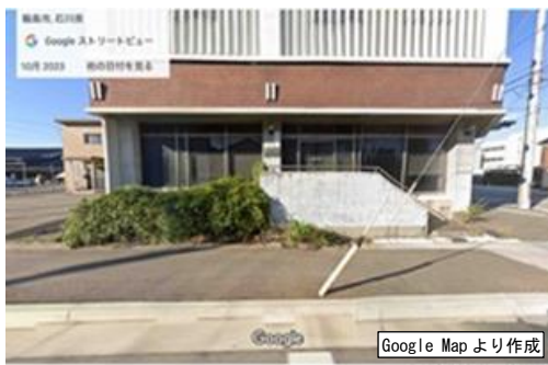
写真 5. 4. 2-23 地震前（2023 年 10 月） 5.4-6)より作成 の建物入口（南面）
