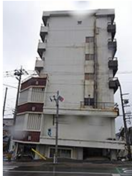
写真 5. 4. 2-22 建物全景（東側から撮影）
