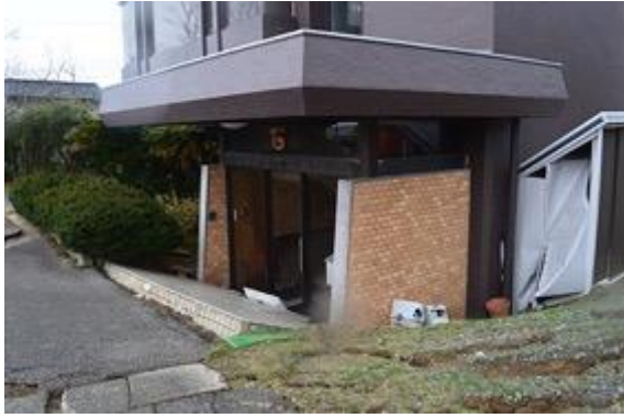
写真 5.4.2-9 正面入口付近の状況（沈下）
