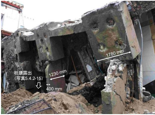
写真 5.4.2-13 引抜き側のパイルキャップと基礎梁
