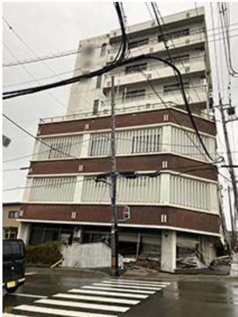
写真 5. 4. 2-21 建物全景（南側から撮影）
