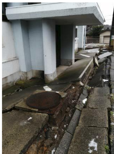
写真 5. 4. 2-46 G住宅の地盤被害の状況
