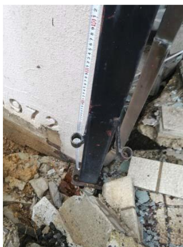
写真 5. 4. 2-47 Hホテルの地盤被害の状況
