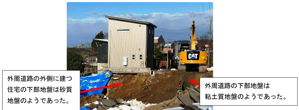
写真 5.4.2-5 斜面崩壊エリアの地表付近の状況（写真 5.4.2-2 のアップ）
