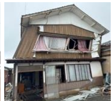
写真5. 2. 2-37 安全限界変形を超える残留変形がある家屋（珠洲市宝立町鵜飼）
