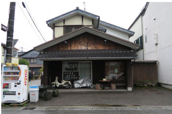
写真5. 2. 2-83 外観上無被害の木造店舗併用住宅
