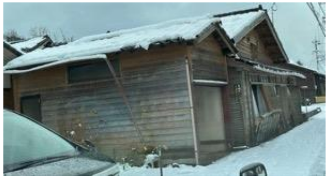
写真5. 2. 2-26 一部は安全限界変形を超えるような大きな残留変形がある家屋（門前町黒島）
