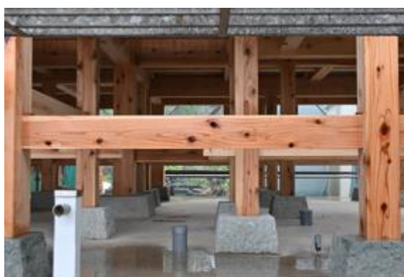
写真5.2.2-77 写真 5.2.2-76 の束と礎石部分
