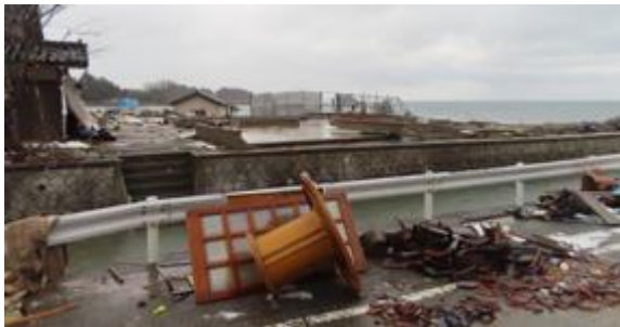
写真5. 2. 2-72 津波により流失した木造住宅 2
