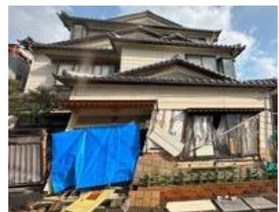
写真5. 2. 2-9 一部は安全限界変形を超えるような大きな残留変形のある住宅（鳳至町）
