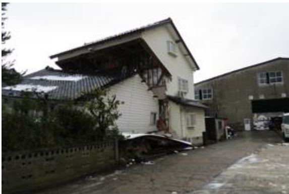
写真5. 2. 2-64 1層が崩壊した3階建て木造住宅
