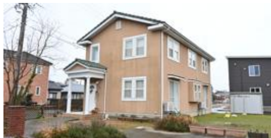
写真5.2.2-87 七尾市の2階建枠組壁工法住宅(2000年竣工)
