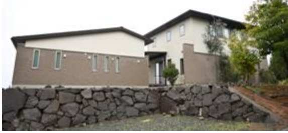
写真5. 2. 2-78 外観上無被害の木造住宅
