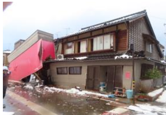
写真5. 2. 2-65 倒壊した木造店舗併用住宅
