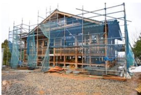
写真5.2.2-76 建設中の石場建て木造住宅
