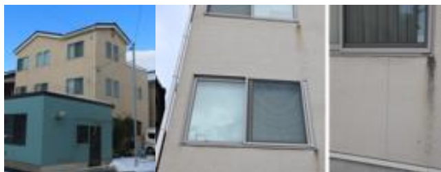
写真5.2.2-84 珠洲市野々江町の3階建枠組壁工法住宅の開口周囲のひび割れ (2004年竣工)
