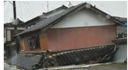
写真5. 2. 2-33 珠洲市正院町正院で倒壊した木造家屋
