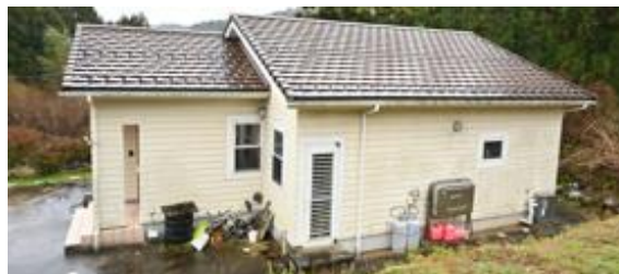
写真5.2.2-85 七尾市能登島曲町の平家の枠組壁工法住宅(2003年竣工)
