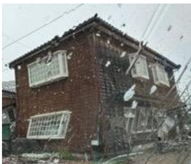
写真5. 2. 2-37 安全限界変形を超える残留変形がある家屋（珠洲市宝立町鵜飼）
