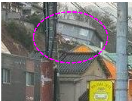
写真5. 2. 2-5 斜面崩壊による被害の可能性がある家屋
