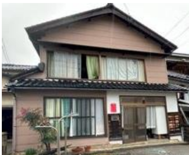
写真5.2.2-59 残留変形がある家屋（穴水町大町）
