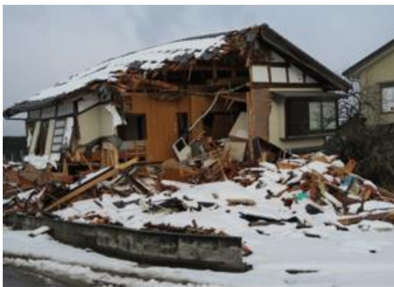
写真5.2.2-44 倒壊した木造住宅
