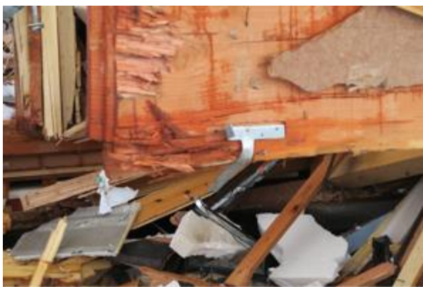
写真5.2.2-47 写真5.2.2-44のかど金物（T型）
