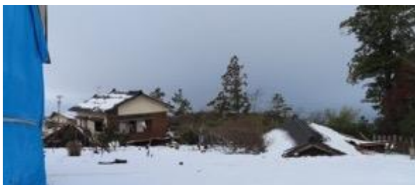
写真5.2.2-49 1層が崩壊した木造住宅と倉庫
