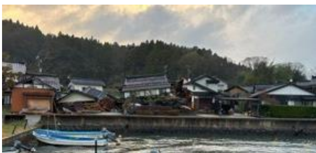
写真5. 2. 2-52 穴水町曾福の倒壊家屋群
