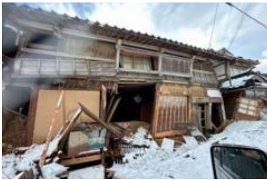
写真5. 2. 2-26 一部は安全限界変形を超えるような大きな残留変形がある家屋（門前町黒島）
