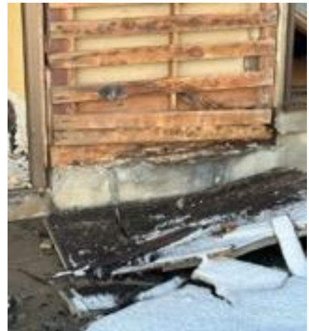
写真5. 2. 2-17 モルタル外壁が大規模に剥落した住宅とその土台の腐朽
