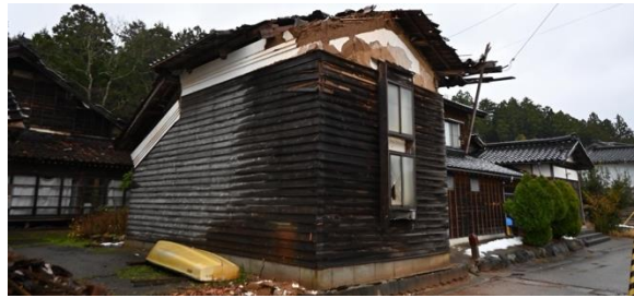
写真5. 2. 2-79 土蔵の被害
