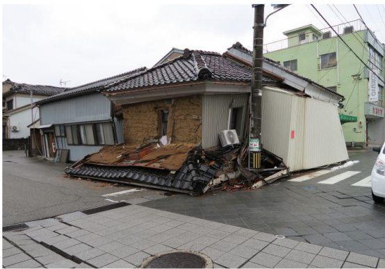
写真5. 2. 2-80 倒壊した木造住宅
