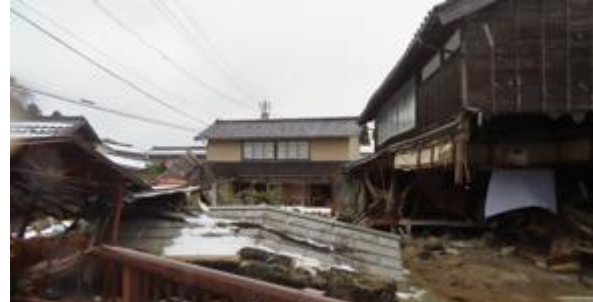
写真5. 2. 2-73 津波により倒壊した木造住宅
