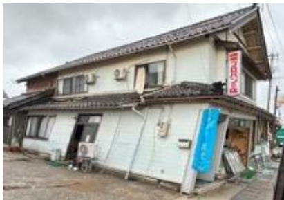
写真5. 2. 2-34 珠洲市正院町正院で一部は安全限界変形を超える大きな残留変形が残る家屋
