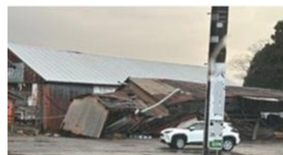
写真5. 2. 2-55 穴水町志ヶ浦の工場社屋の倒壊
