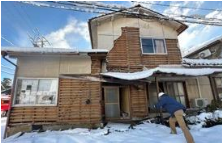
写真5. 2. 2-17 モルタル外壁が大規模に剥落した住宅とその土台の腐朽
