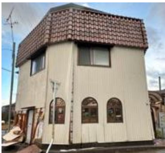
写真5.2.2-59 残留変形がある家屋（穴水町大町）
