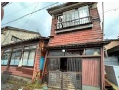
写真5. 2. 2-9 一部は安全限界変形を超えるような大きな残留変形のある住宅（鳳至町）
