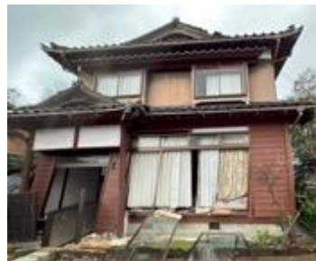
写真5. 2. 2-34 珠洲市正院町正院で一部は安全限界変形を超える大きな残留変形が残る家屋
