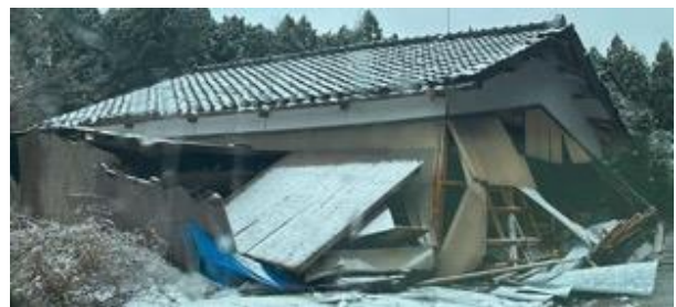
写真5. 2. 2-43 写真 5.2.2-41 の近傍で 2023 年地震時に倒壊を免れたが今回倒壊に至った家屋
