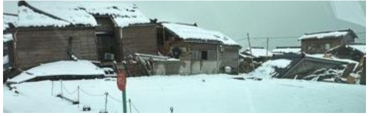
写真5. 2. 2-24 門前町黒島の倒壊家屋群
