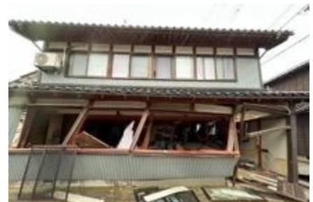
写真5. 2. 2-34 珠洲市正院町正院で一部は安全限界変形を超える大きな残留変形が残る家屋
