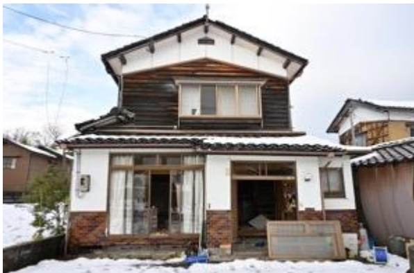
写真5.2.2-51 比較的健全な木造住宅
