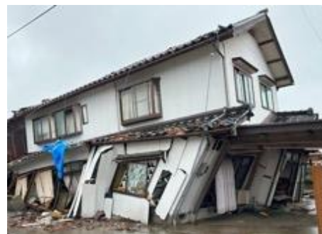
写真5. 2. 2-37 安全限界変形を超える残留変形がある家屋（珠洲市宝立町鵜飼）
