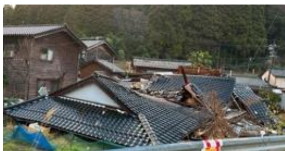
写真5. 2. 2-53 穴水町鹿島の倒壊家屋群
