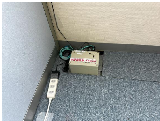
写真 4.4-14 強震計設置状況 (WJMF3 : 南側 1 階、CV374_147)
