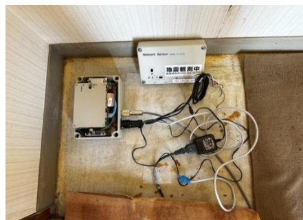
写真 4.4-4 強震計設置状況 (WJMS3：南西側4階、CV374_142)
