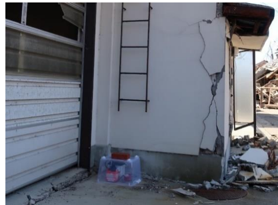
写真 4.4-17 地震計設置状況 (WJMG、Atom No.7_164)
